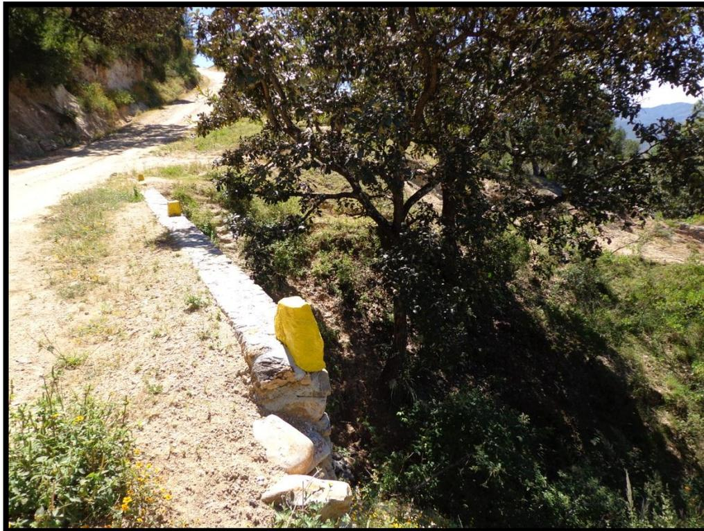
**Figura 16.-** Muro de contención en Santa Catarina. Caliza
