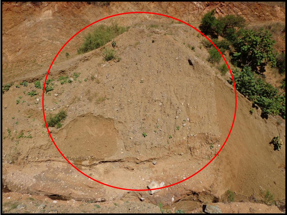
**Figura 25.-** Acumulación de arenas utilizada como presa que colapso, debido a la presión del río ya que limitaba el flujo del río en su totalidad. (8-sp-2011).
