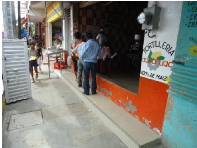
Figura 77. Nótese el murillo en el piso para contener inundaciones.
