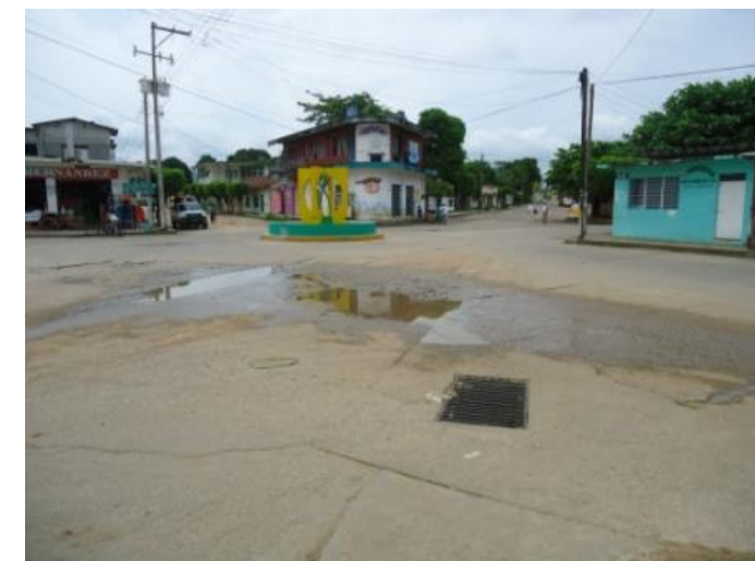
Figura 75. Área inundable (el basamento de la fuente es anegado frecuentemente).
