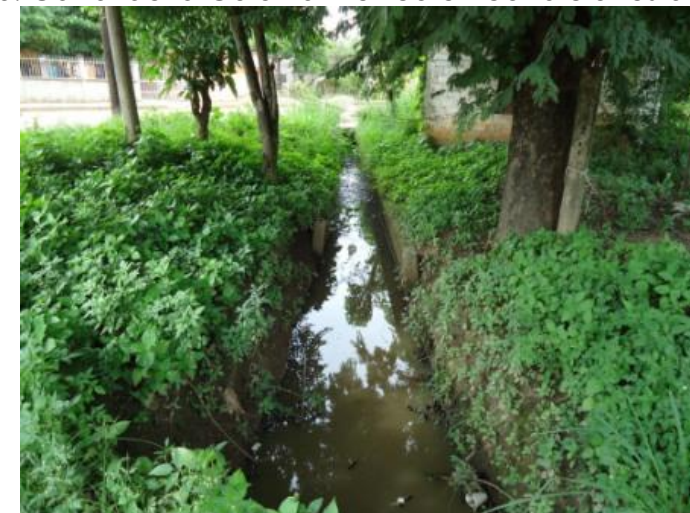
Figura 65. Canal de la Colonia Mexico en condiciones aceptables
