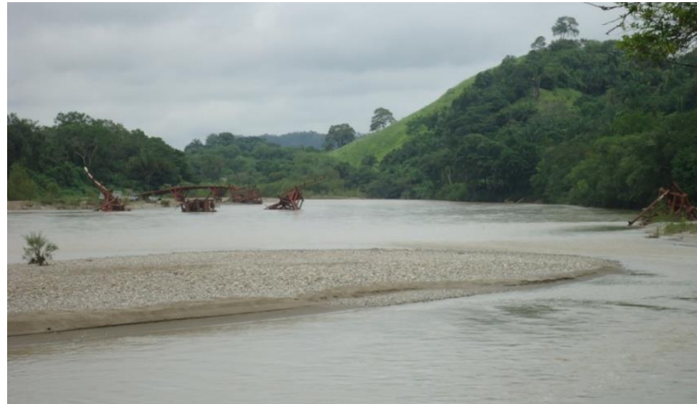
Figura 53. Restos del puente que la crecida de 2010 tiró y arrastró dejando disperso en varias partes del río frente a la localidad Santa Sofía Monte Rosa
