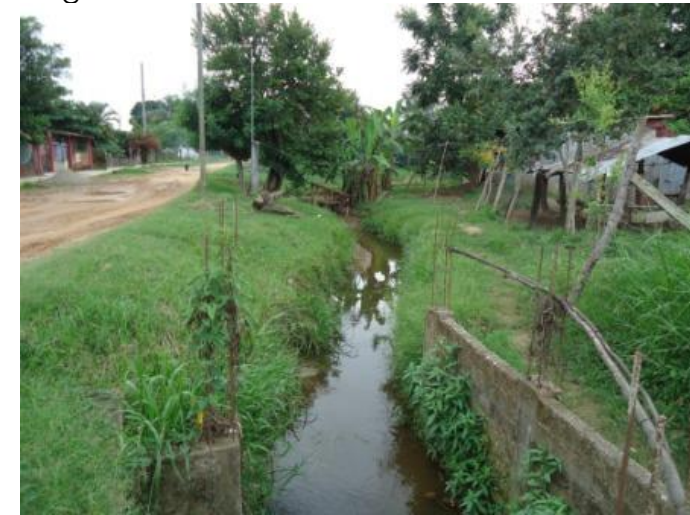
Figura 72. Canal con buenas características.
