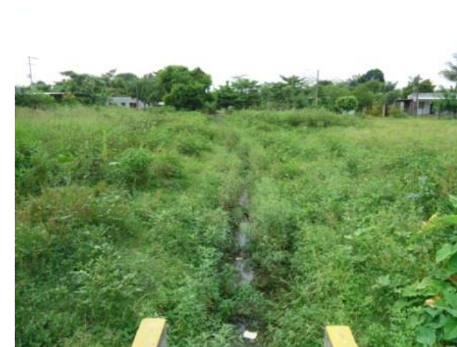
Figura 60. Sección del canal cubierto por vegetación.
