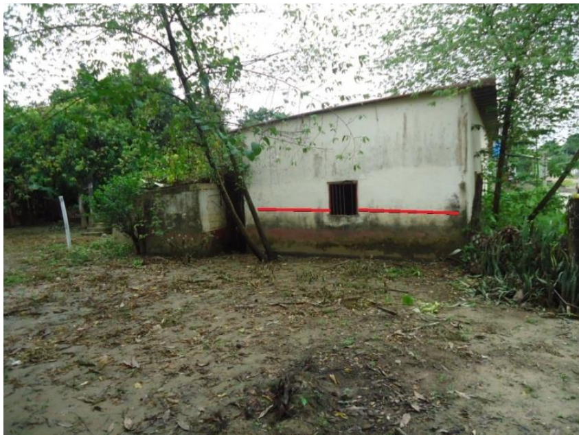
Figura 44. Nivel del agua en una vivienda de la localidad Mixtán
