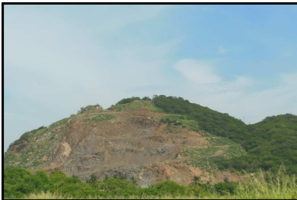
Imagen 55. Banco de material, área susceptible de deslizamientos y derrumbes por extracción de material Geológico.
