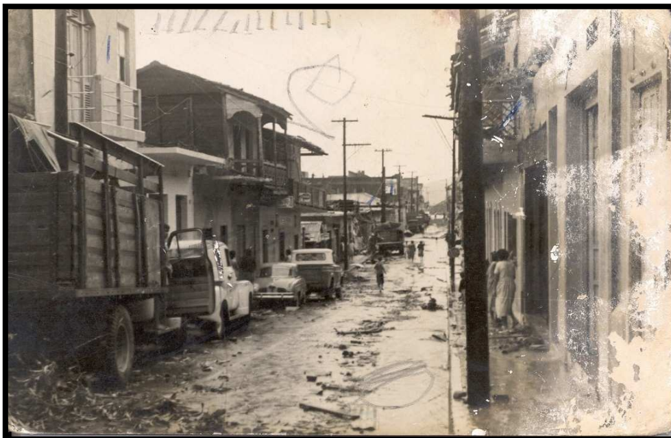
Imagen 98. Se observan los efectos de los flujos de lodo y piedra, sobre vialidades de la cabecera municipal de Manzanillo, a causa del huracán de 1959. Fuente: archivo fotográfico del INPLAN.
