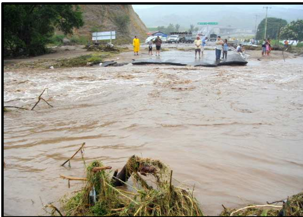
Imagen 130. Se observan daños a las vías de comunicación por inundaciones del arroyo Punta de Agua en 2011.
