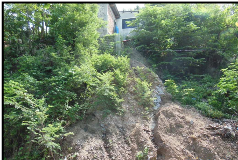
Imagen 44. Colonia el Rocío. Asentamiento ubicado en área de deslizamiento.
