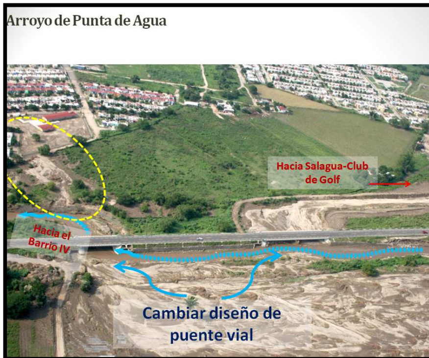
Imagen 79. Se observa otra vista del azolvamiento ocasionado por agua y flujos de lodo del arroyo Punta de Agua a la altura del puente sobre el libramiento Manzanillo-Cihuatlán.
