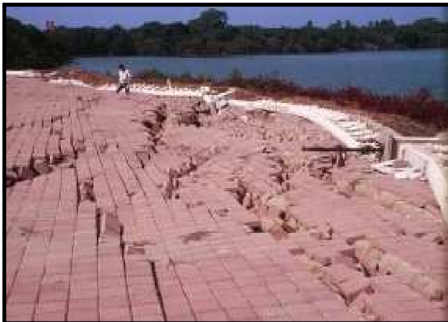
Imagen 5. Evidencias de licuación de suelos en las inmediaciones de la laguna del Valle de las Garzas, debida al sismo de 2003 ( M_w=7.6 ) Fuente: CENAPRED.
