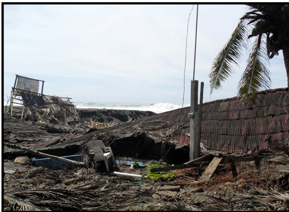
Imagen 107. Se observan los daños sobre el área de palapas en la Playa el Edén. A causa del huracán "Jova" en 2011.
