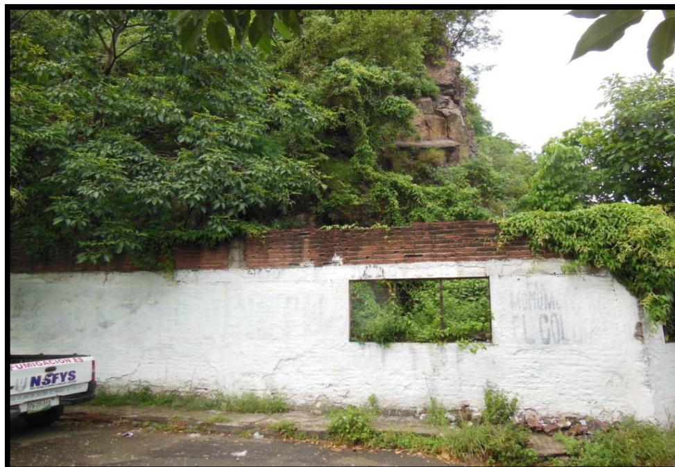
Imagen 68. Vivienda deshabitada que fue afectada por derrumbe de rocas en el año de 2005, sobre la Avenida Niños Héroes.
