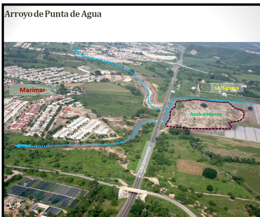
Imagen 77. Se observa el azolvamiento ocasionado por agua y flujos de lodo del arroyo Punta de Agua sobre el puente a la altura del libramiento Manzanillo-Cihuatlán.
