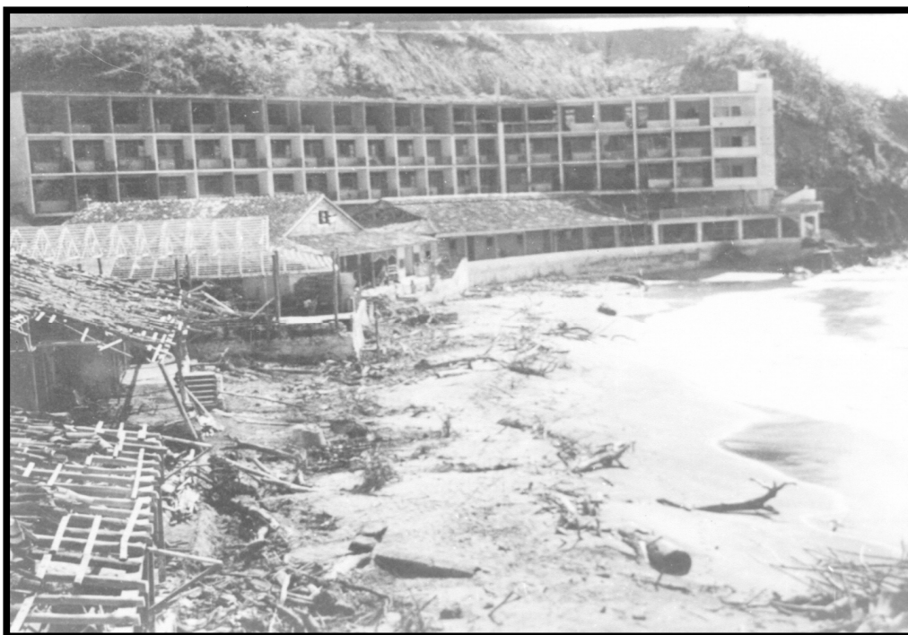
Imagen 95. Se observan los daños ocasionados por la fuerza de los vientos del huracán de 1959, a la zona hotelera de Santiago. Fuente: archivo fotográfico del INPLAN.
