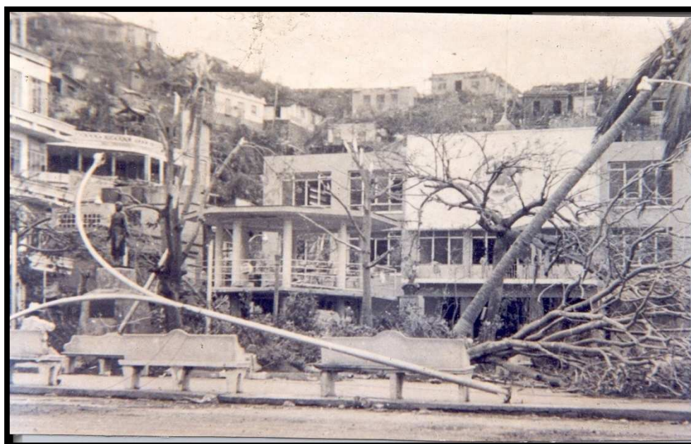
Imagen 100. Se observan los daños ocasionados sobre el jardín principal frente al edificio de la presidencia municipal, debido a la fuerza de los vientos del huracán de 1959. Fuente: archivo fotográfico del INPLAN.
