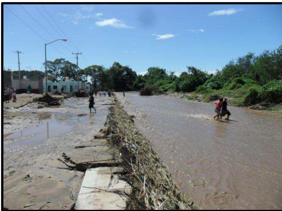
Imagen 126. Desbordamiento del arroyo Chandiablo y áreas urbanas afectadas.
