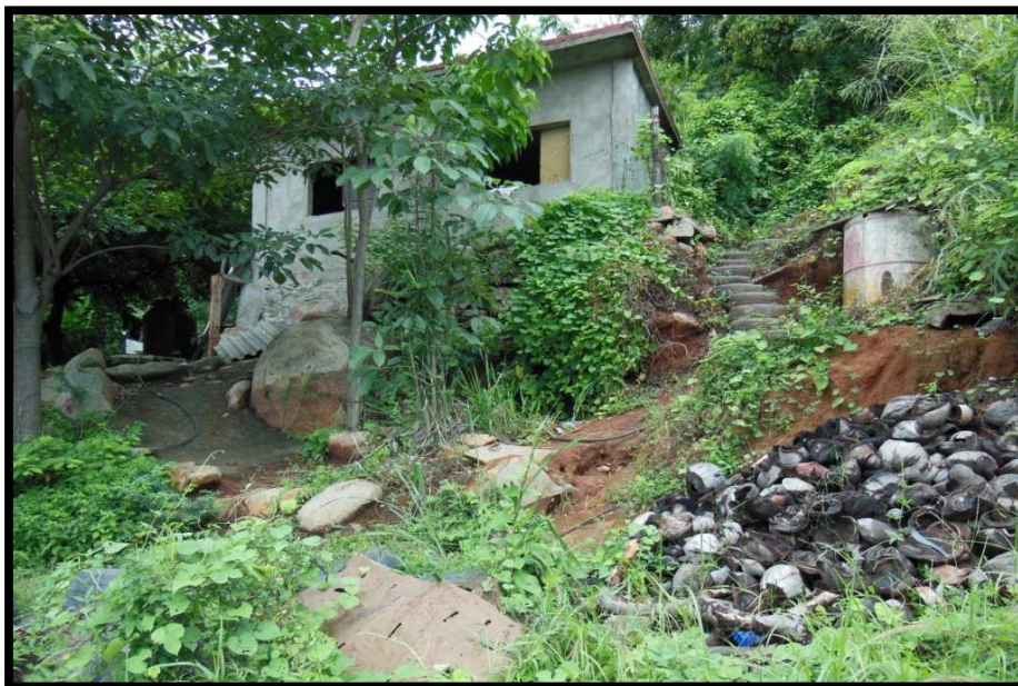
Imagen 47. Asentamiento ubicado en una ladera que es zona de riesgo por deslizamientos y derrumbes sobre el libramiento hacia la localidad del El Colomo.
