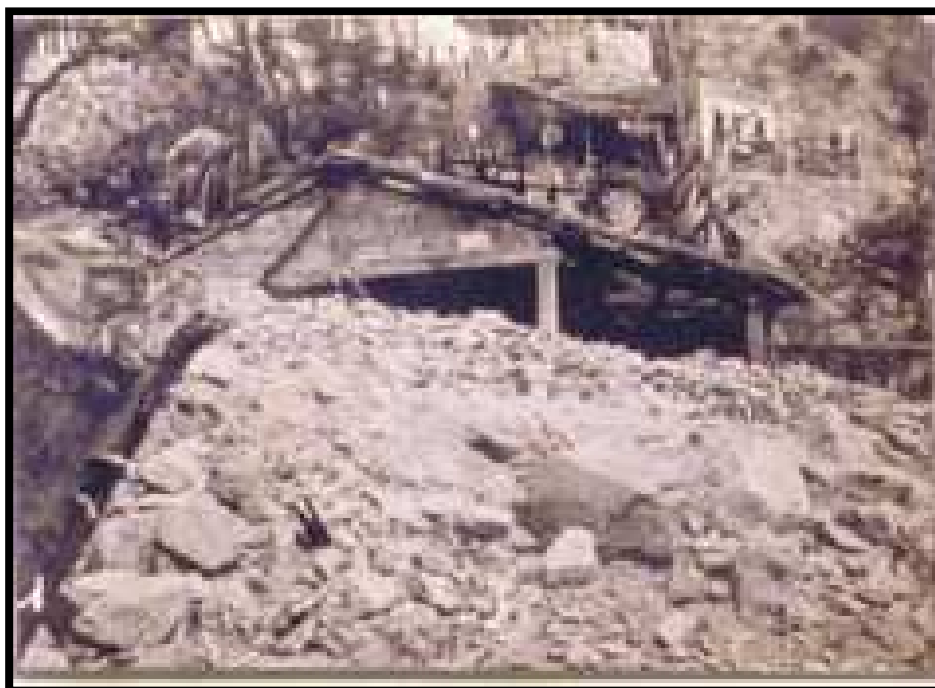
Imagen 39. Se observa una de las primeras evidencias históricas de un deslizamiento de suelo y rocas sobre la cabecera municipal, a causa del huracán de 1959. Fuente: Archivo fotográfico del INPLAN.
