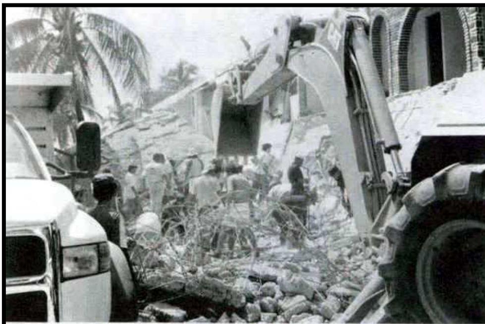
Imagen 2. Colapso de construcciones como la Plaza Santiago por el sismo del 8 de octubre de 1995 (M=8) Fuente: Archivo Fotográfico del INPLAN.
