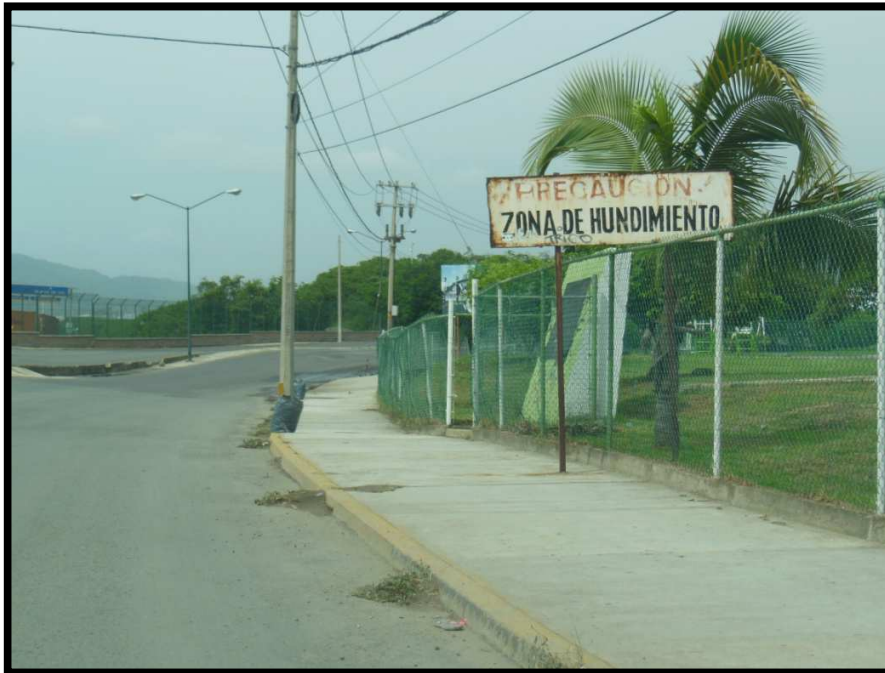
Imagen 92. Zona identificada de peligros por hundimientos, Av. Niños Héroes dentro de la zona urbana de la Cabecera Municipal.
