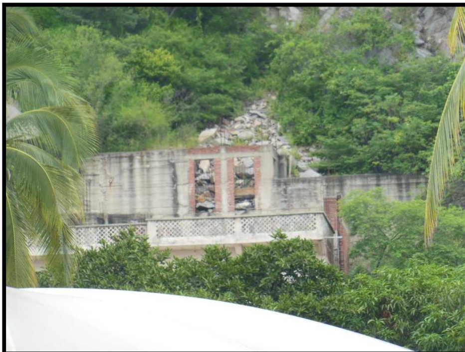
Imagen 66. Se muestran derrumbes de rocas sobre el cerro de la Cruz con afectación a una construcción. Vista desde la calle México, de la colonia centro.
