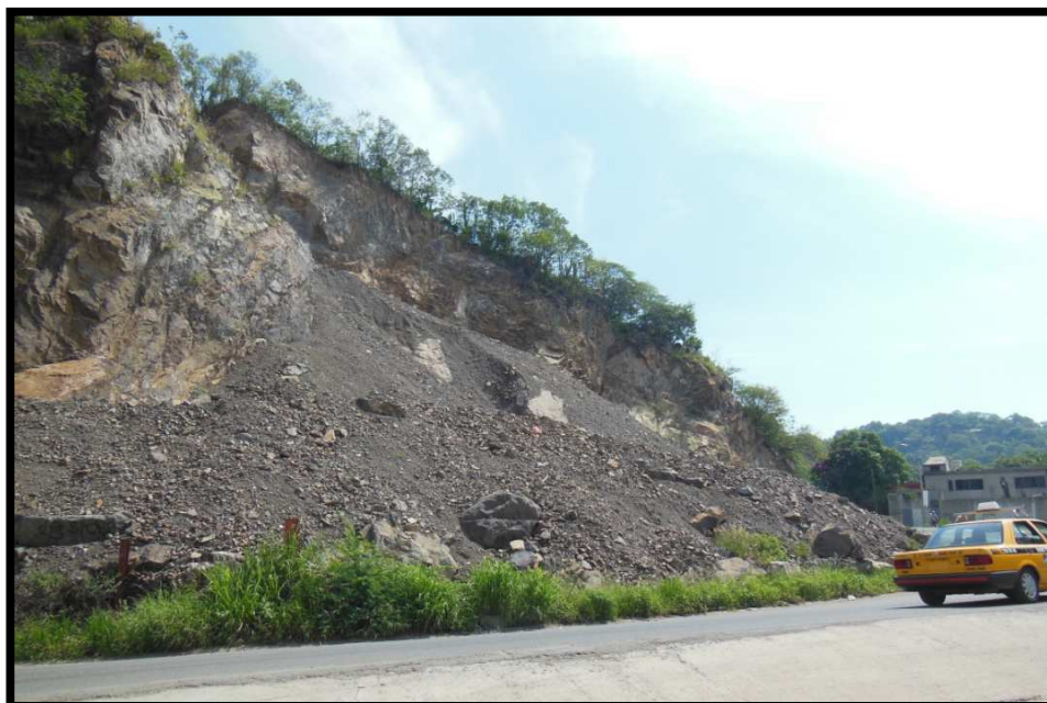
Imagen 50. Zona de derrumbes por la ampliación de la prolongación Av. Hidalgo.
