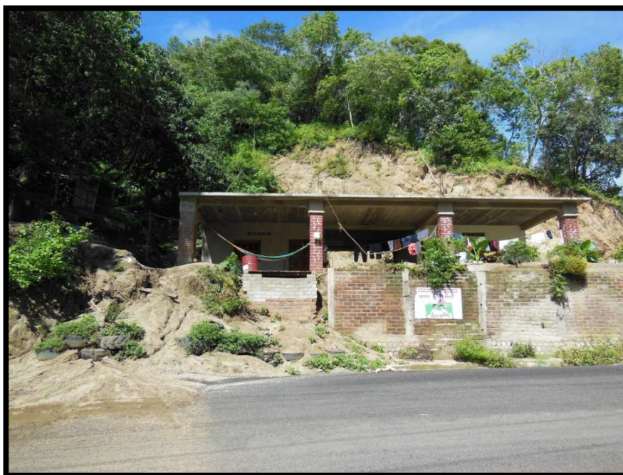
Imagen 48. Asentamiento ubicado sobre una ladera en zona de riesgo por en zona deslizamientos al pie de la carretera hacia la localidad El Huizcolote.
