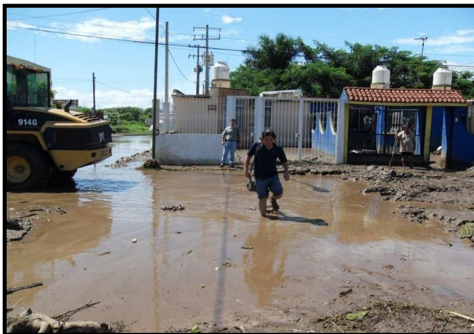
Imagen 87. Viviendas y vialidades dañadas por inundación de flujos de agua y lodo en la Colonia Barrio IV, a causa del huracán "Jova" en 2011.
