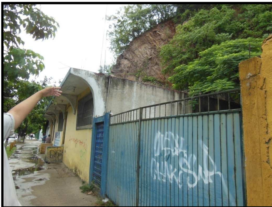
Imagen 69. Viviendas sobre la Avenida Niños Héroes que se ubican en áreas de peligros por derrumbes y caída.
