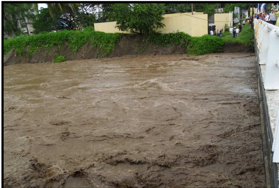
Imagen 116. Puente de Santiago sobre el arroyo Chandiablo.
