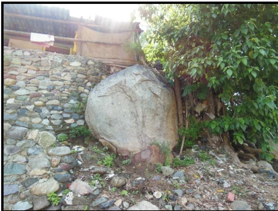
Imagen 59. Se observa asentamiento ubicado sobre una ladera, identificada como zona de riesgo en Localidad Punta de Agua.
