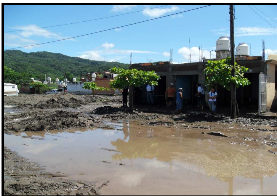
Imagen 88. Viviendas y vialidades dañadas por inundación de flujos de agua y lodo en la Colonia Barrio IV, a causa del huracán "Jova" en 2011.
