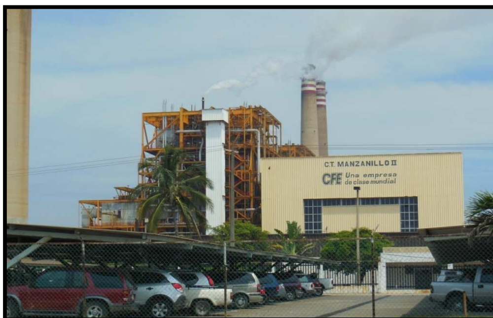
Imagen 21. Planta Termoeléctrica Manzanillo II. De la C.F.E. Ubicada en Punta de Campos
