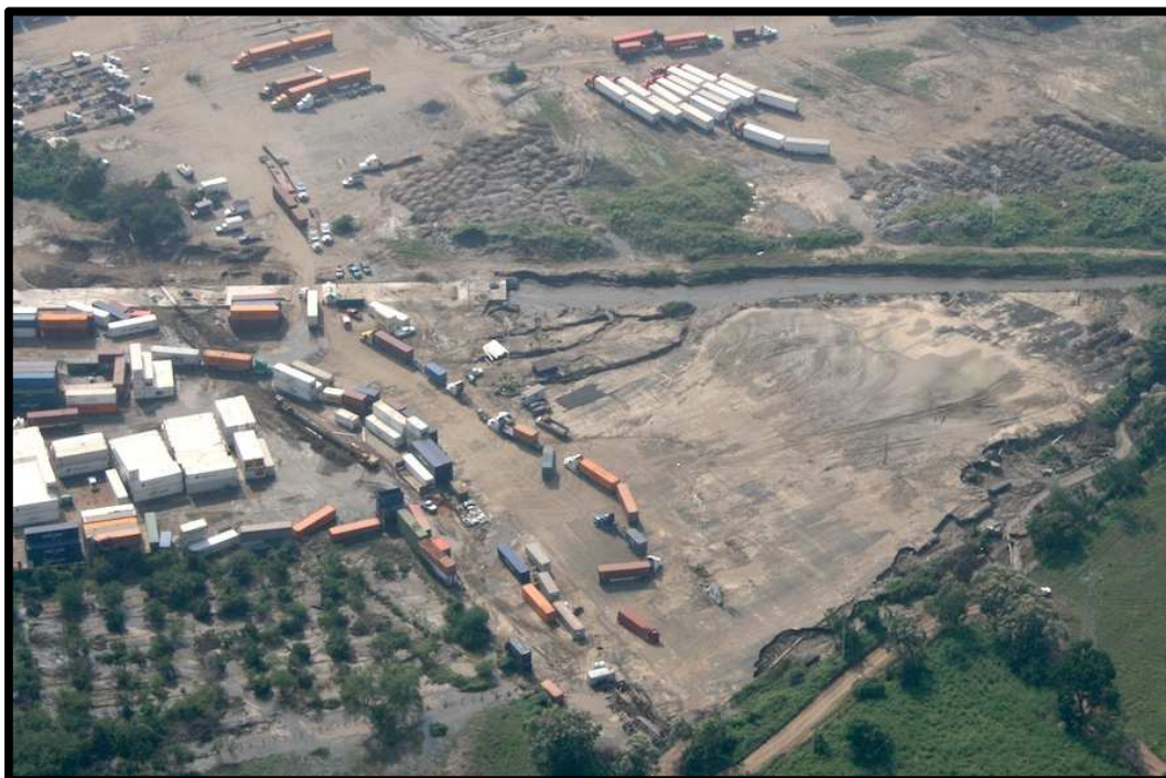
Imagen 132. Se observa el estrangulamiento del arroyo Jalipa, lo que genera desbordamientos.
