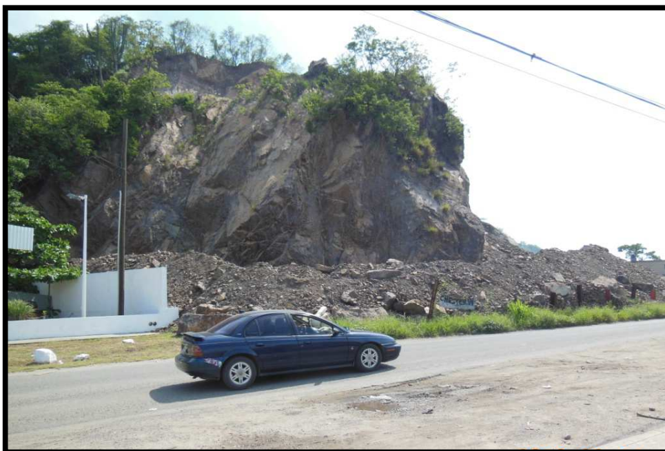
Imagen 49. Zona de derrumbes por la ampliación de la prolongación Av. Hidalgo.
