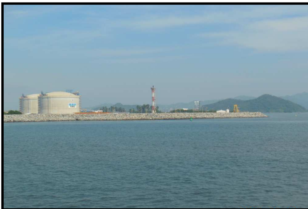
Imagen 20. Instalaciones de la Regasificadora de gas natural KMS, planta Manzanillo.
