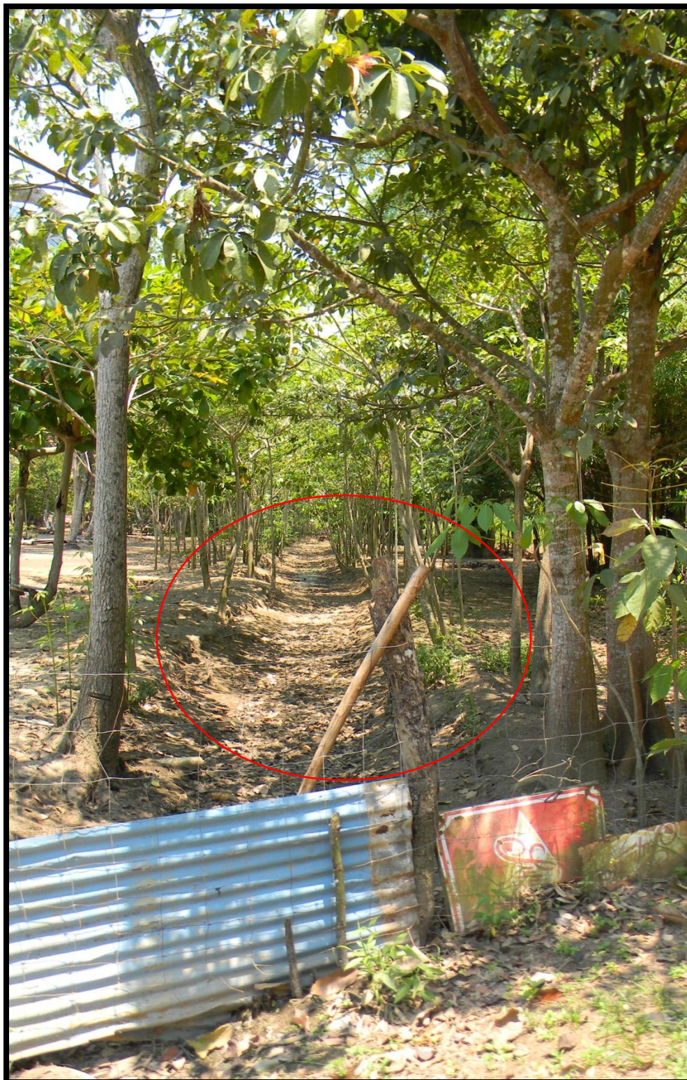
Figura 16.- Canales artificiales que drenaban laguna, pero algunos se azolvaron por falta mantenimiento.
