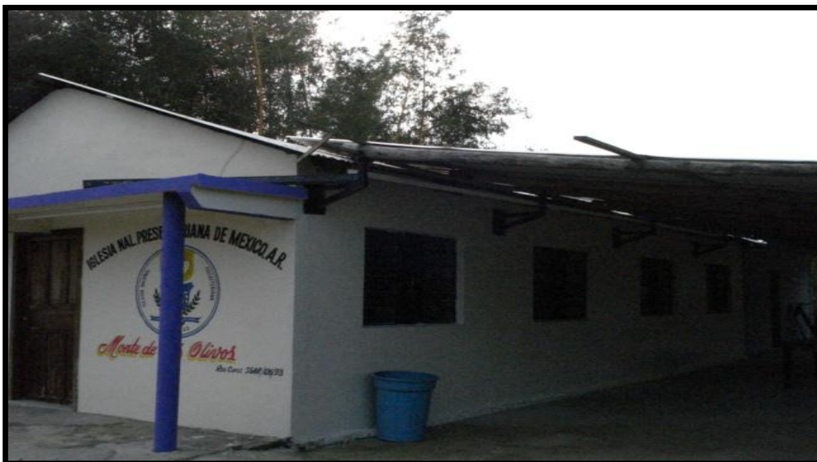
Figura 26.- Iglesia Nacional Presbiteriana de México. A.R, Montes de Olivo, Refugio temporal con capacidad de 60 personas localizado en la colonia Km 2.5 de la Cabecera Municipal.
