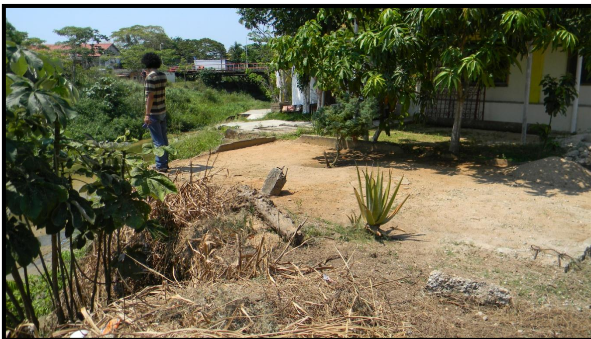
Figura 4.- Casa cerca del río deshabitada ya que se empezaba a deslavar en Colonia Nueva del Río.
