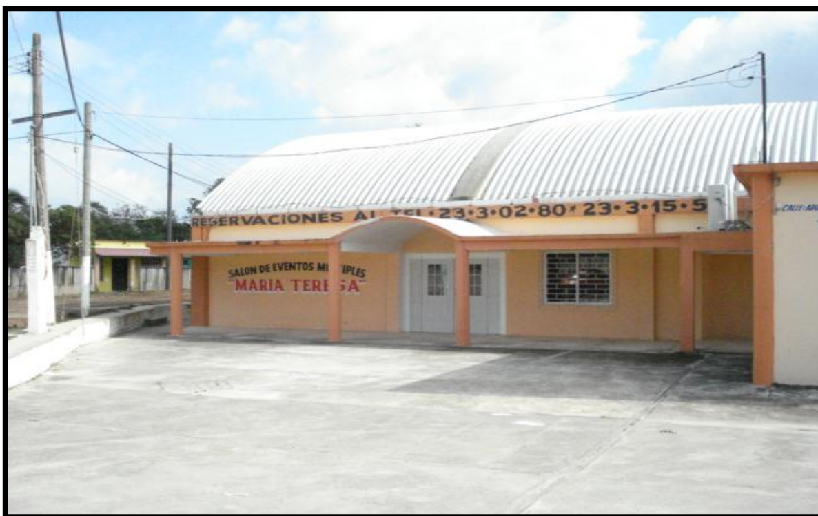
Figura 29.- Salón de eventos múltiples María Teresa, refugio temporal con capacidad de 141 personas localizado en la colonia Factoría PEMEX de la Cabecera Municipal.
