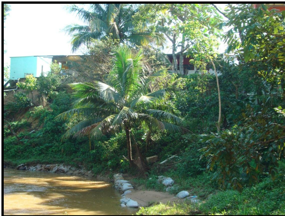
Figura 53. Muros de contención sobre río Agua Dulce.
