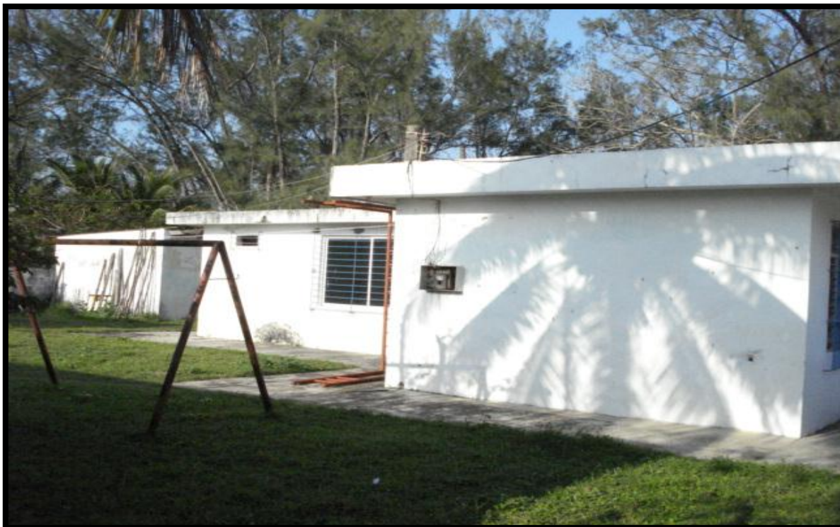
Figura 37.- Purificadora Agua Dulce, refugio temporal con capacidad de 50 personas, se encuentra en la Localidad de Tonalá.
