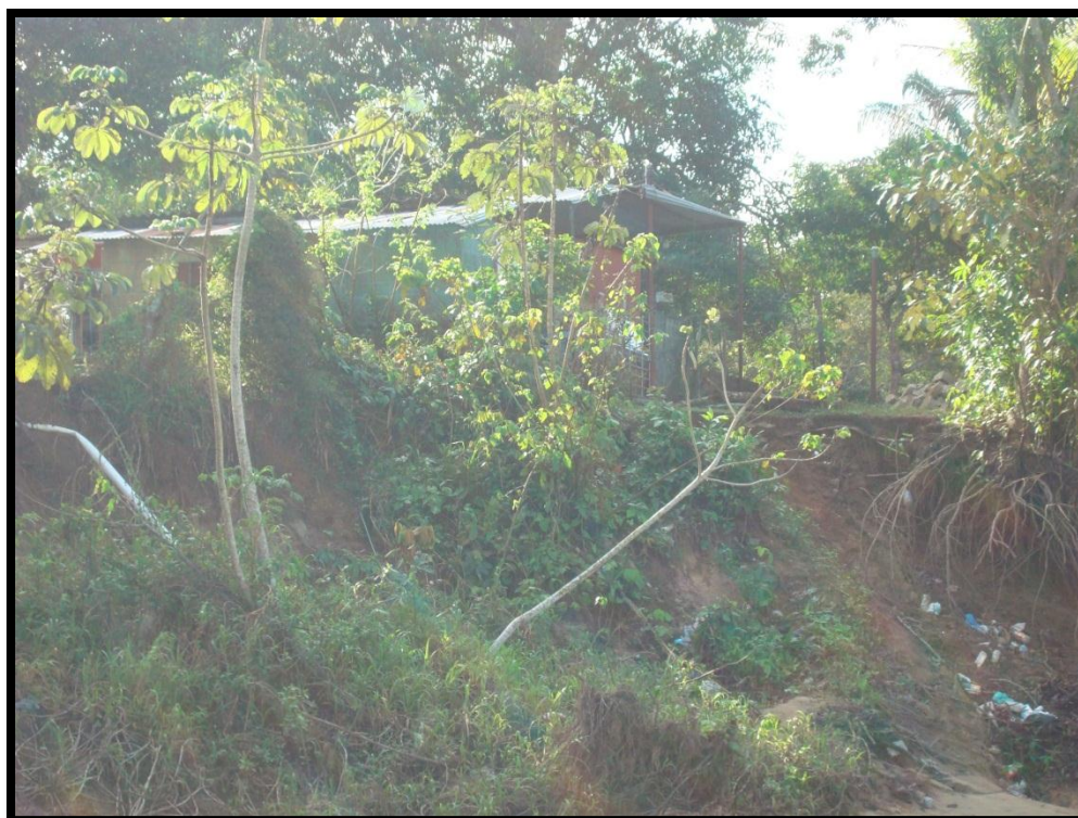
Figura 42. Vivienda en riesgo de deslave, provocado por erosión hídrica.
