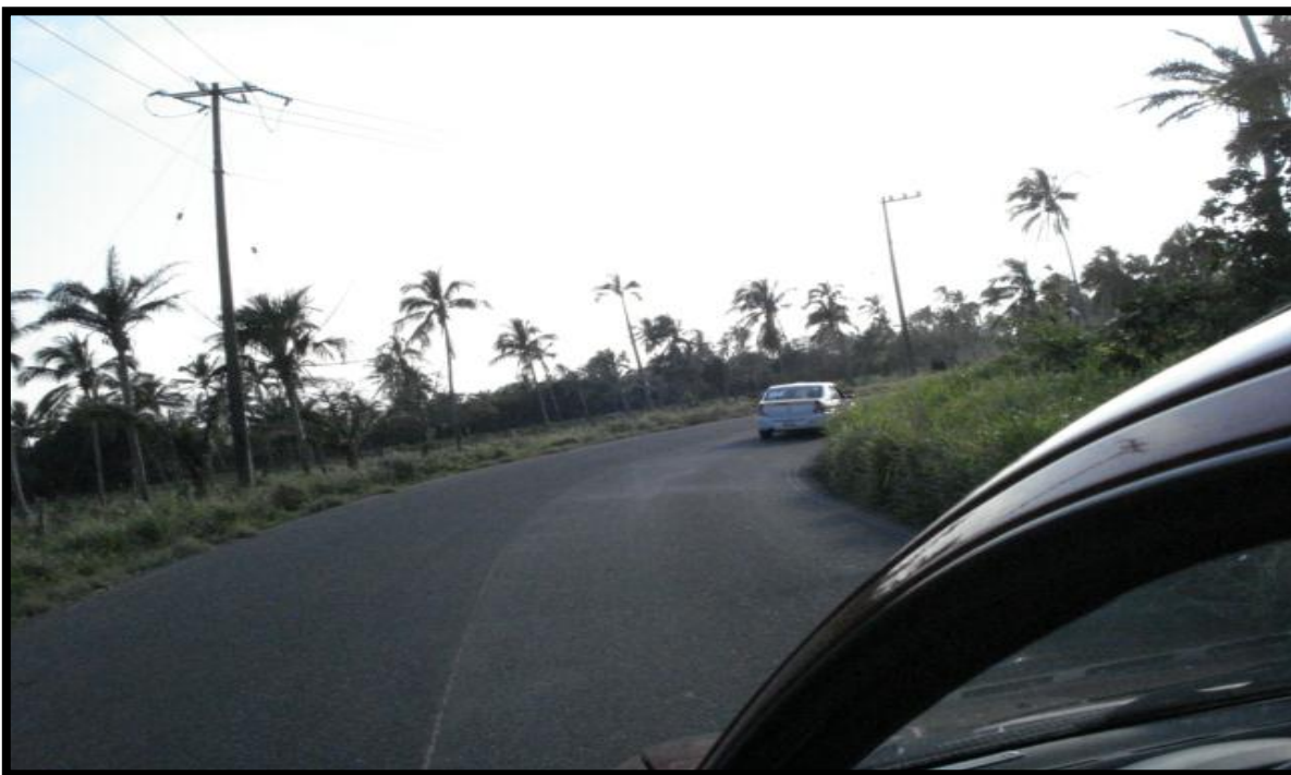
Figura 36.- Carretera Federal, curva peligrosa, 8 accidentes anuales aproximadamente en la Localidad de Tonalá.
