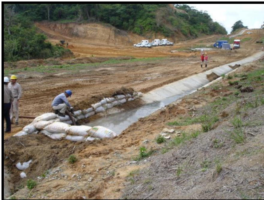
Fotografía 5.3. Recuperación de Naftas con Agua en derrame ocurrido el 27 de Enero de 2005.
