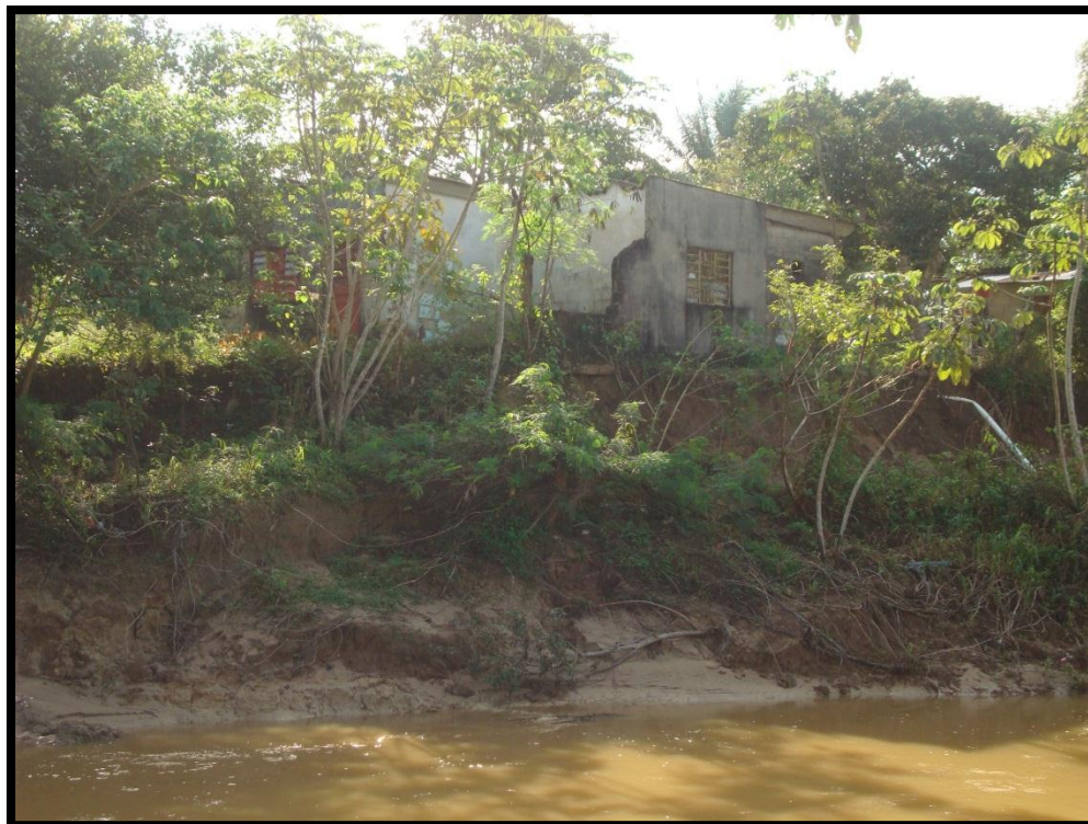
Figura 41. Vivienda afectada por erosión hídrica en la colonia Kilómetro 2.5.
