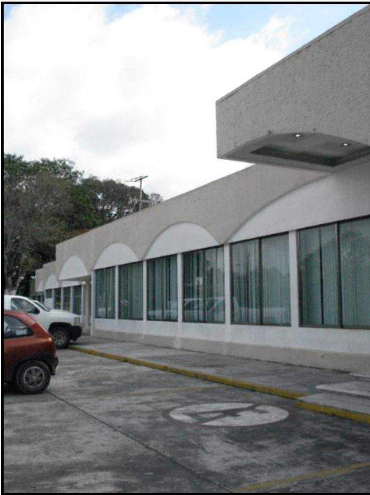
Figura 32.- Club TO-VEN-VU, refugio temporal con capacidad para 240 personas, localizado en la colonia Factoría PEMEX de la cabecera municipal.
