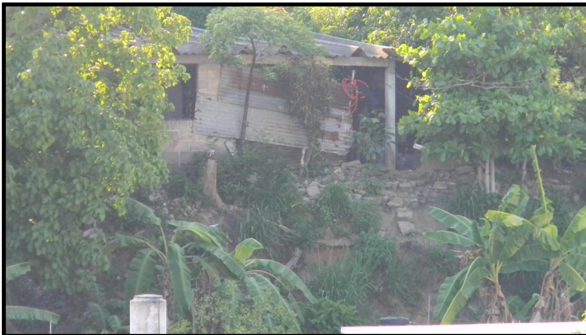
Figura 10.- Casa en riesgo de deslave Colonia Lázaro Cárdenas de la Cabecera Municipal.
