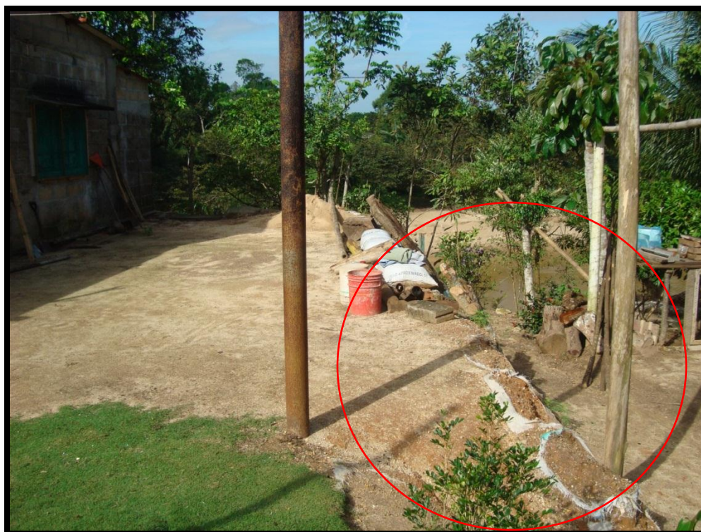
Figura 46. Muros de contención en vivienda en la Colonia Cuatro Caminos. Fuente: Protección Civil Municipal.
