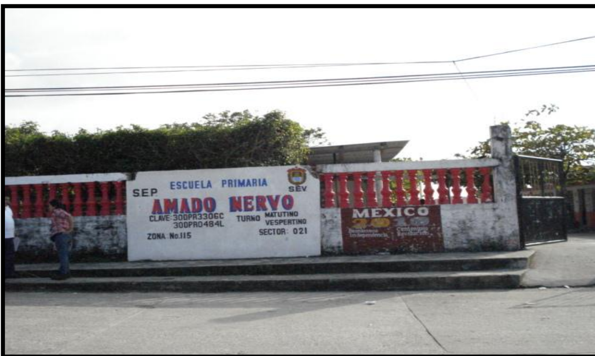
Figura 31.- Escuela primaria Amado Nervo, refugio temporal con capacidad para 200 personas localizado en la colonia Emiliano Zapata de la cabecera municipal.
