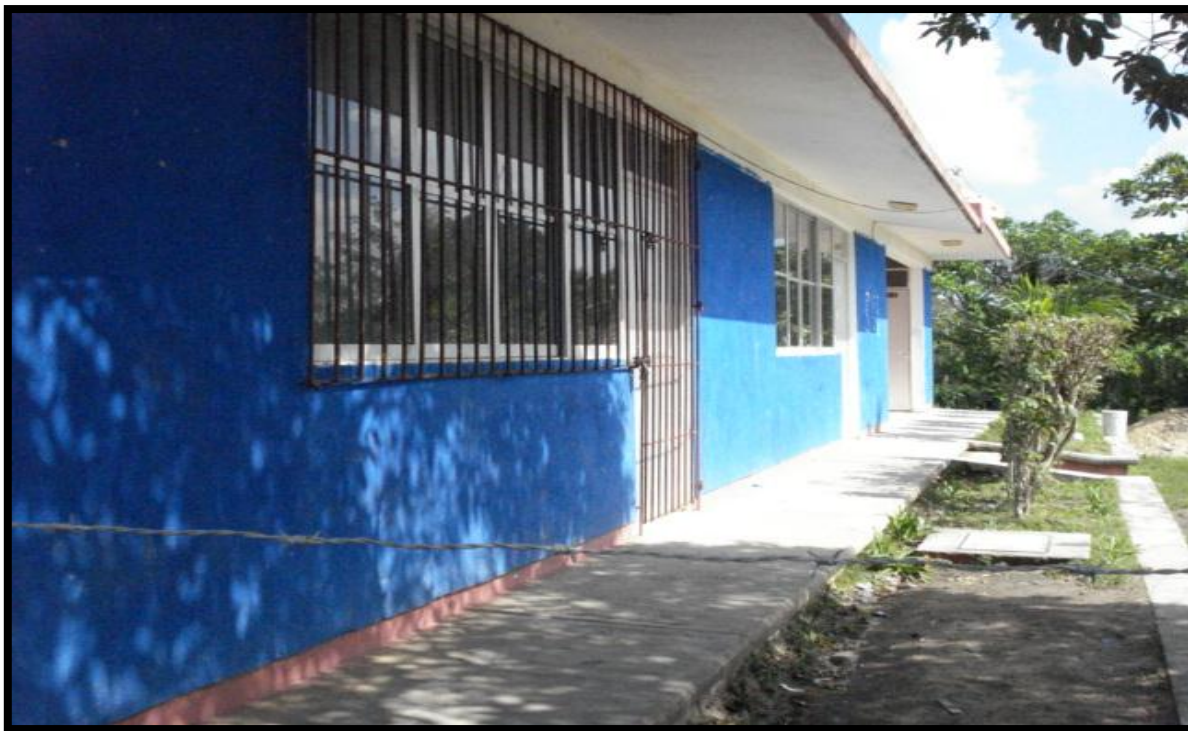
Figura 18.- Escuela Telesecundaria, refugio temporal con capacidad de 50 personas, en la localidad de Ejido Los Soldados.
