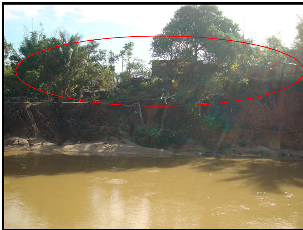
Figura 43. Siete viviendas en riesgo de deslave, provocado por erosión hídrica. Fuente: Protección Civil Municipal.
