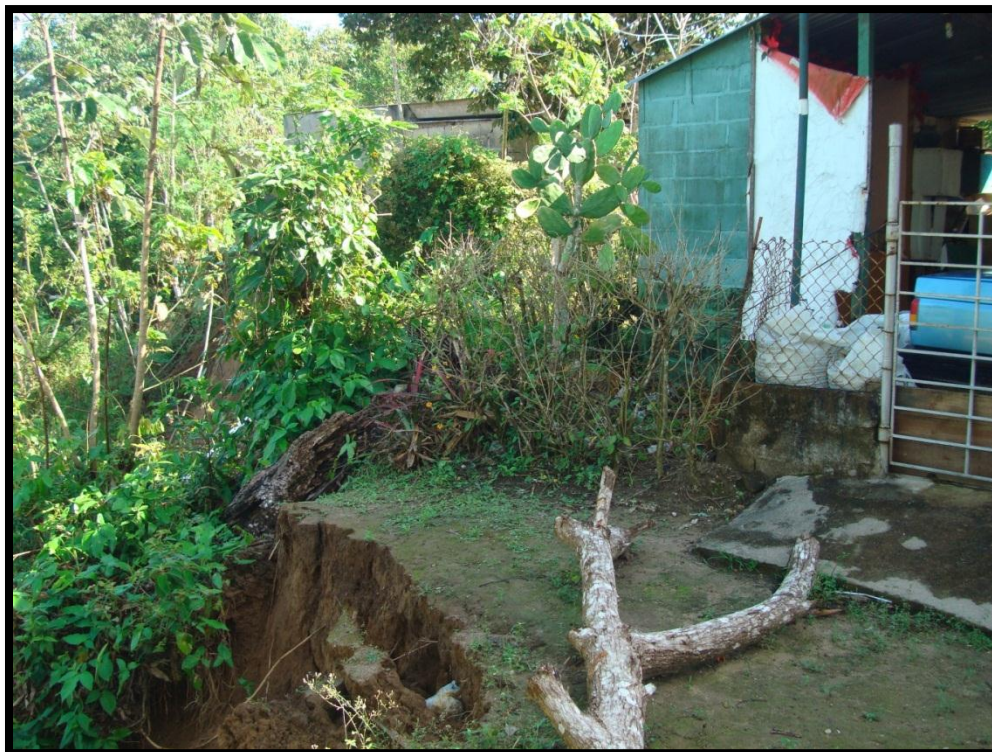
Figura 49. Vivienda en riesgo por deslave en Colonia Nueva del Río.
