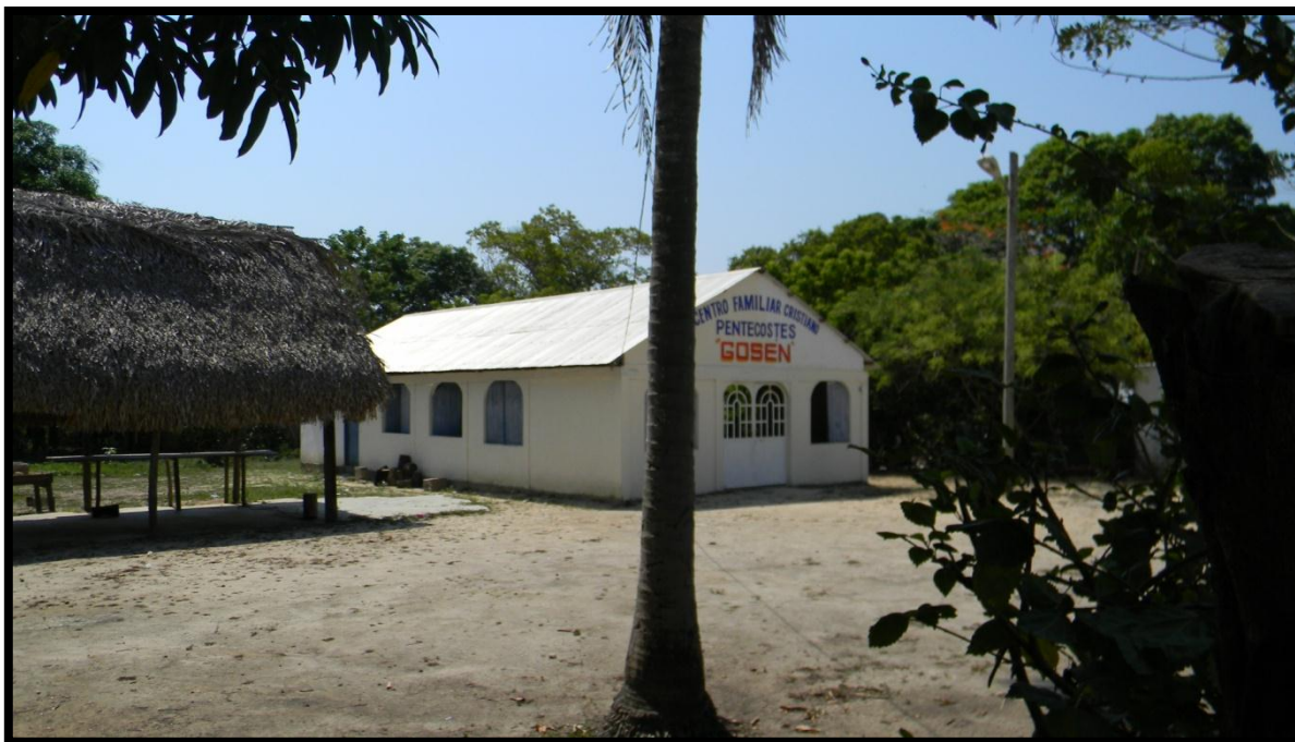
Figura 14.- Refugio temporal con capacidad de 40 personas en Ejido Los Manantiales.
