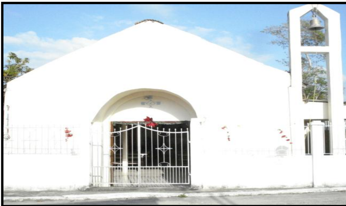
Figura 34.- Capilla San Marcos, refugio temporal con capacidad de 55 personas, localizado en la colonia Allende de la cabecera municipal.
