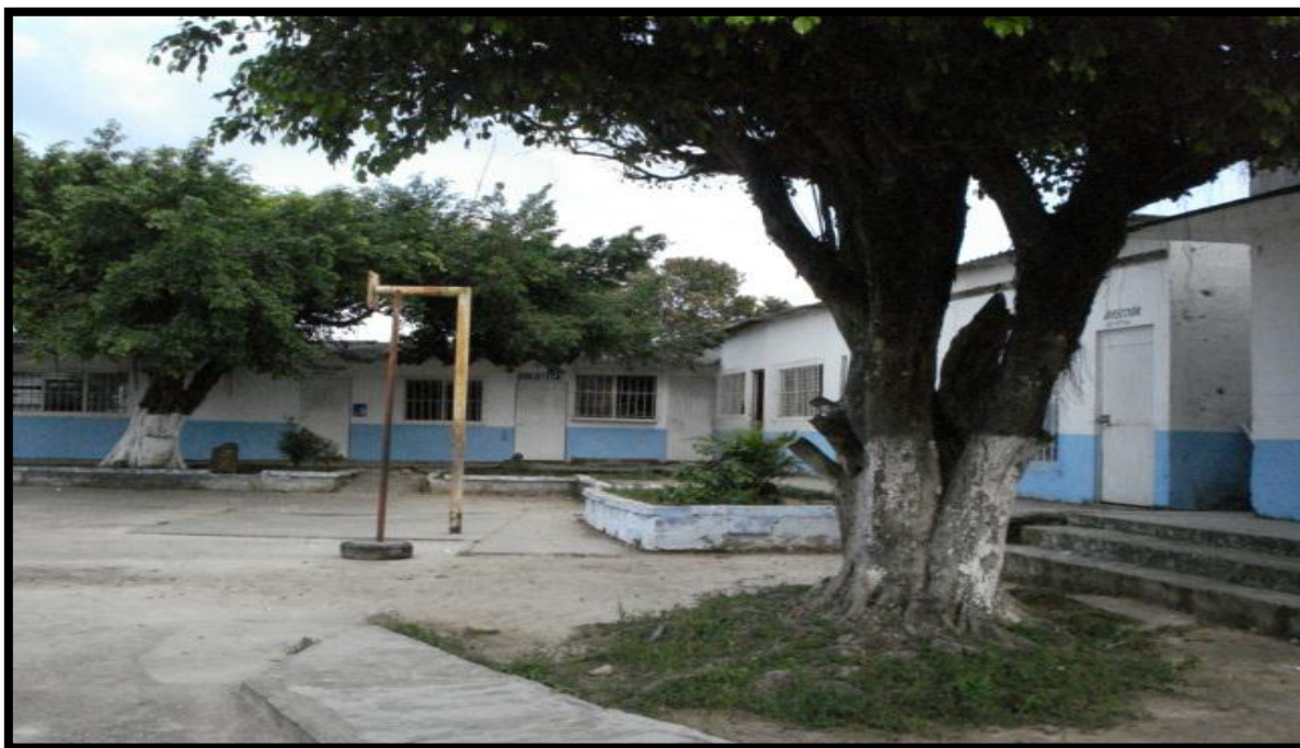
Figura 24.- Escuela primaria Cuauhtémoc, refugio temporal con capacidad de 84 personas en la colonia Nueva del Río Agua Dulce.
