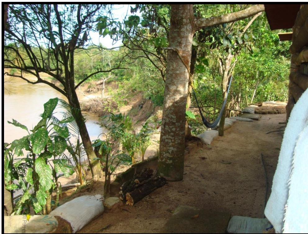
Figura 48. Muros de contención para evitar inundación en vivienda en la Cabecera Municipal.
