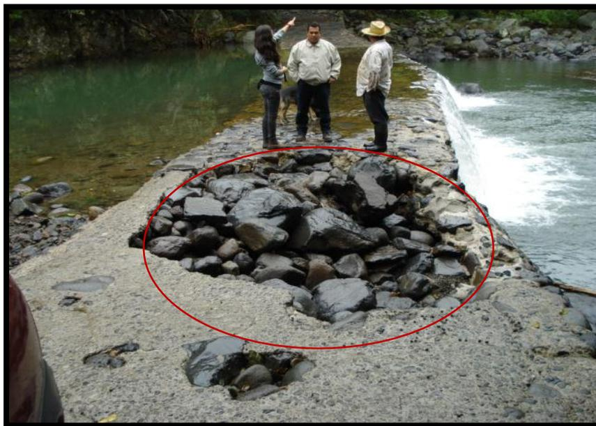
**Figura 26.** Afectación en puente por aumento del caudal del río Santa Bárbara en la localidad La Florida ocasionado por lluvia atípica el 02 de Enero del 2012 provocada por el frente frío No. 23. Presencia de erosión lineal.
