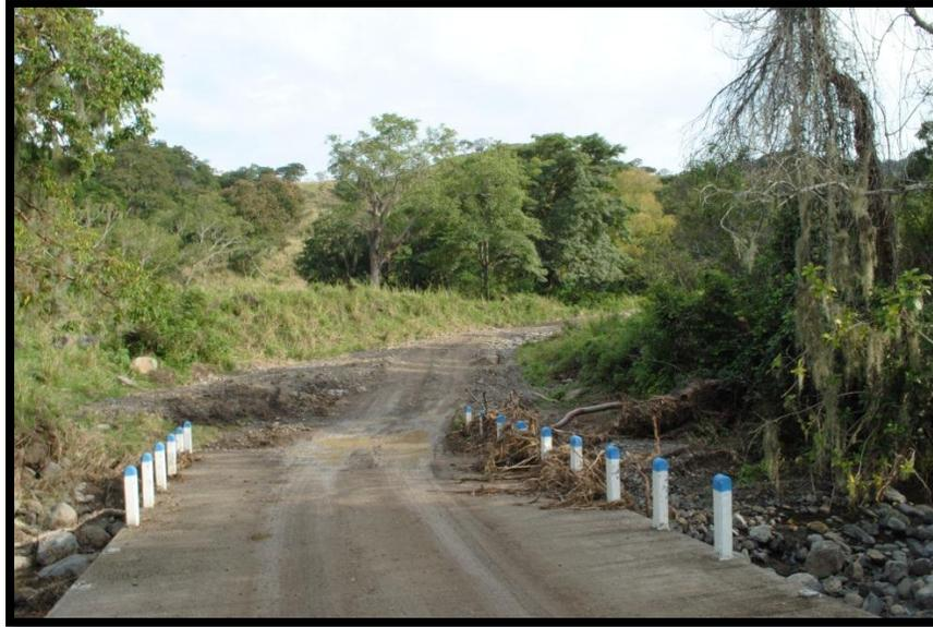
**Figura 9.** Afectaciones a camino de terracería por el desbordamiento del río El Pital camino Paso del Toro – La Sabana.
