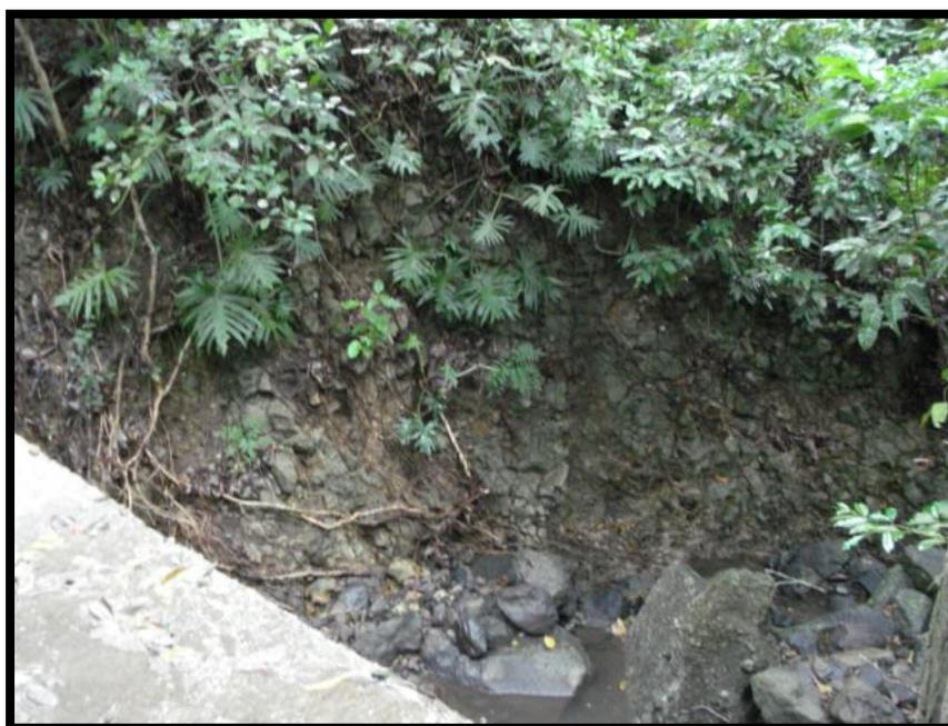
**Figura 28.** Vialidad instalada en cause de corriente intermitente que en temporada de lluvias impide el paso de vehículos e incomunica a la población aledaña, camino La Florida – El Zapotal.
