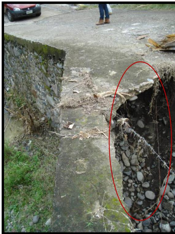
**Figura 51.** Puente dañado por erosión lineal en la localidad La Planilla.
