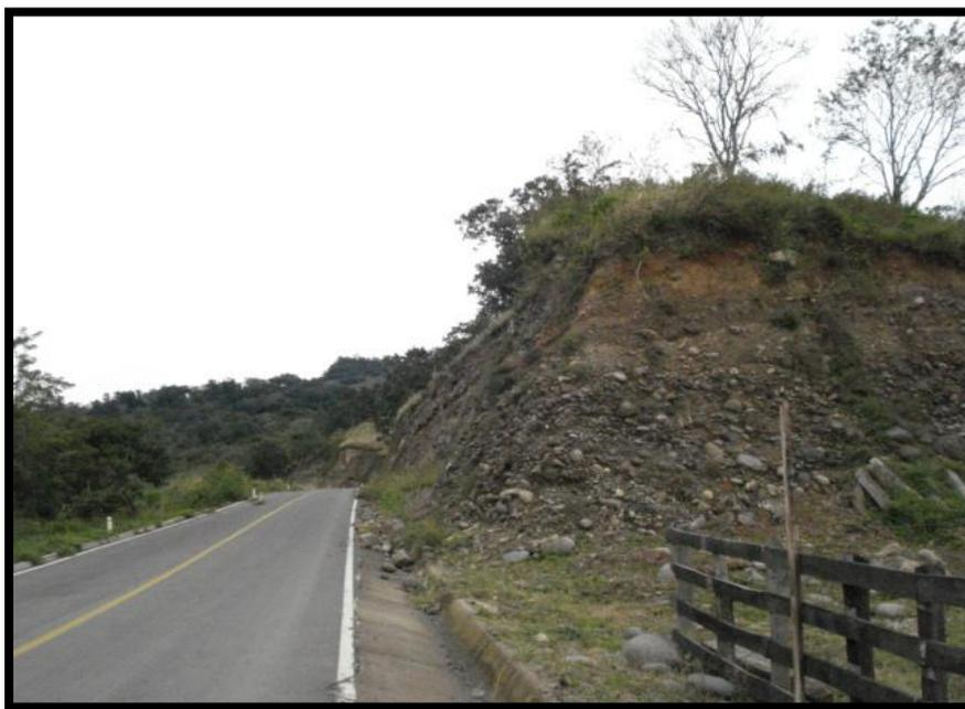
**Figura 54.** Zona con presencia de deslaves, derrumbes y cárcavas carretera Arroyo Frio – Agua Dulce.
