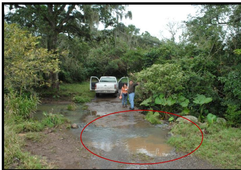
**Figura 6.** Afectaciones a camino de terracería por desbordamiento de corriente efímera en temporada de lluvias, carretera Las Maravillas – Juan Martín.
