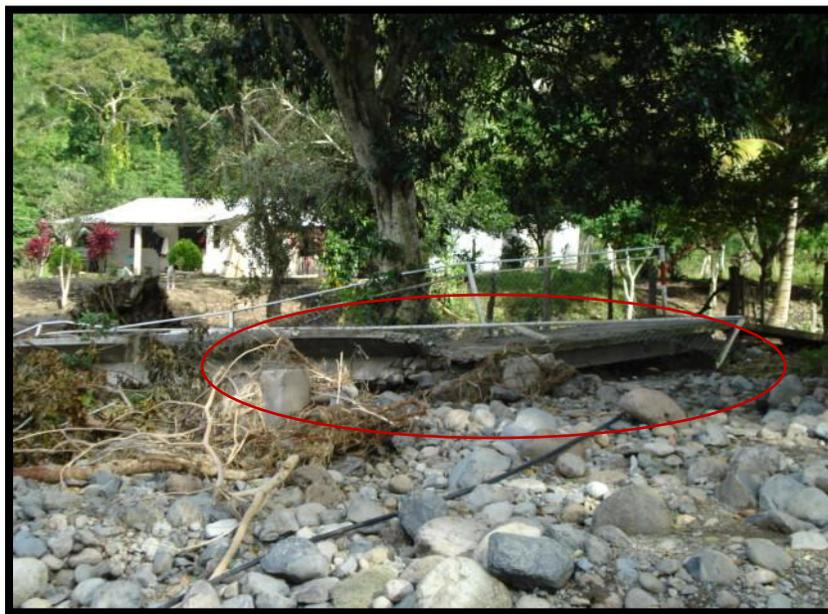
**Figura 43.** Erosión lineal y desprendimiento de materiales por aumento del caudal de la corriente intermitente Arroyo Grande en la localidad de Aparicio.
