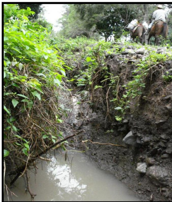
**Figura 31.** Presencia de cárcavas por erosión hídrica que afecta a camino de terracería, camino La Florida – El Zapotal.
