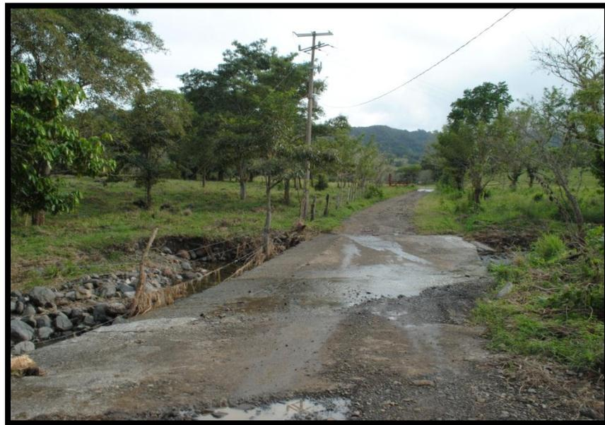
**Figura 10.** Afectaciones a camino de terracería por desbordamiento de corriente intermitente camino Paso del Toro – La Sabana.
