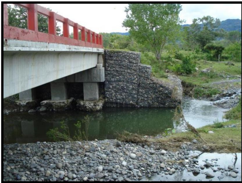
**Figura 38.** Puente dañado por aumento de caudal intermitente ocasionado por lluvia atípica el 02 de Enero del 2012 provocado pro el frente frío No. 23 sobre el camino Las Iguanas – Emilio Carranza.
