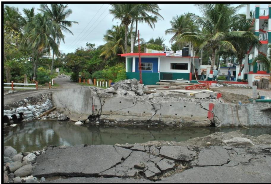
**Figura 46.** Puente colapsado por socavamiento debido a la lluvia atípica del 02 de Enero del 2012 asociadas al frente frío No. 23. En la localidad de Lechuguillas.
