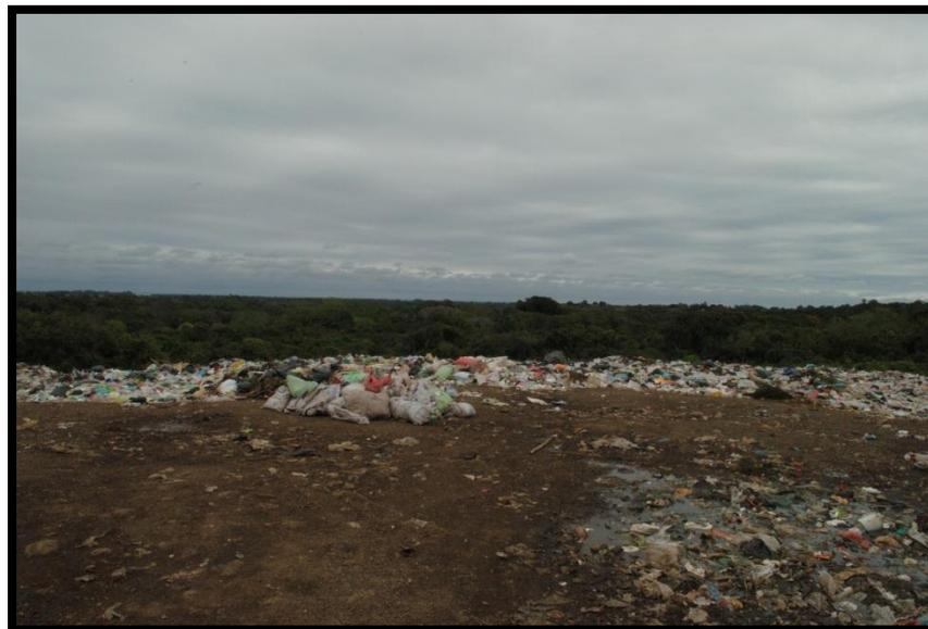
**Figura 40.** Relleno sanitario irregular debido a que presenta carencias de infraestructura, como falta de geomembrana, laguna de lixiviados, tubería de gas metano, cercado arbolado, acopio de residuos, pesa de recepción entre otros en la localidad de San Antonio.
