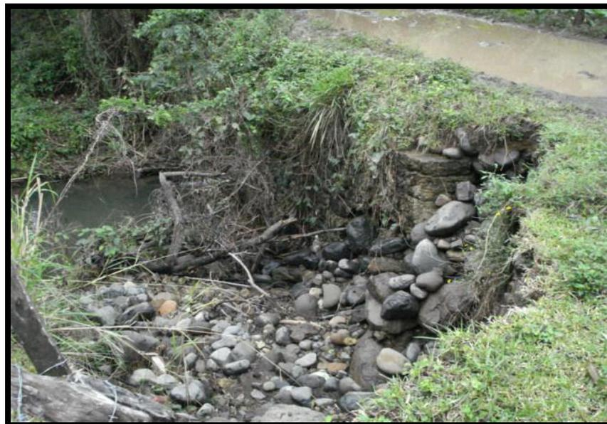
**Figura 31.** Afectación en camino de terracería por corriente intermitente. Erosión lineal, camino La Florida – El Zapotal.
