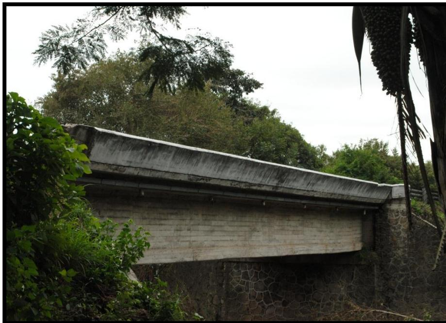
**Figura 47.** Afectación al puente Miraflores por erosión lineal generada por el afluente el Roblar en la localidad Miraflores.
