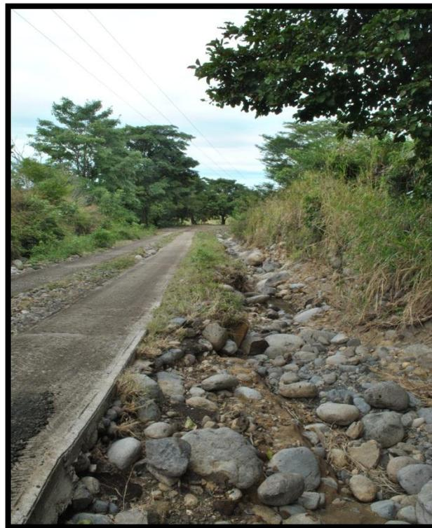
**Figura 37.** Presencia de cárcavas sobre la carretera hacia Paso del Toro.
