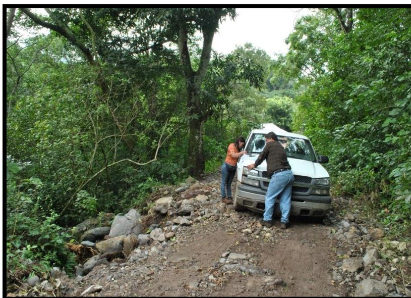
**Figura 8.** Afectaciones a camino de terracería por corrientes intermitentes y erosión lineal carretera Paso del Toro – La Maravilla.
