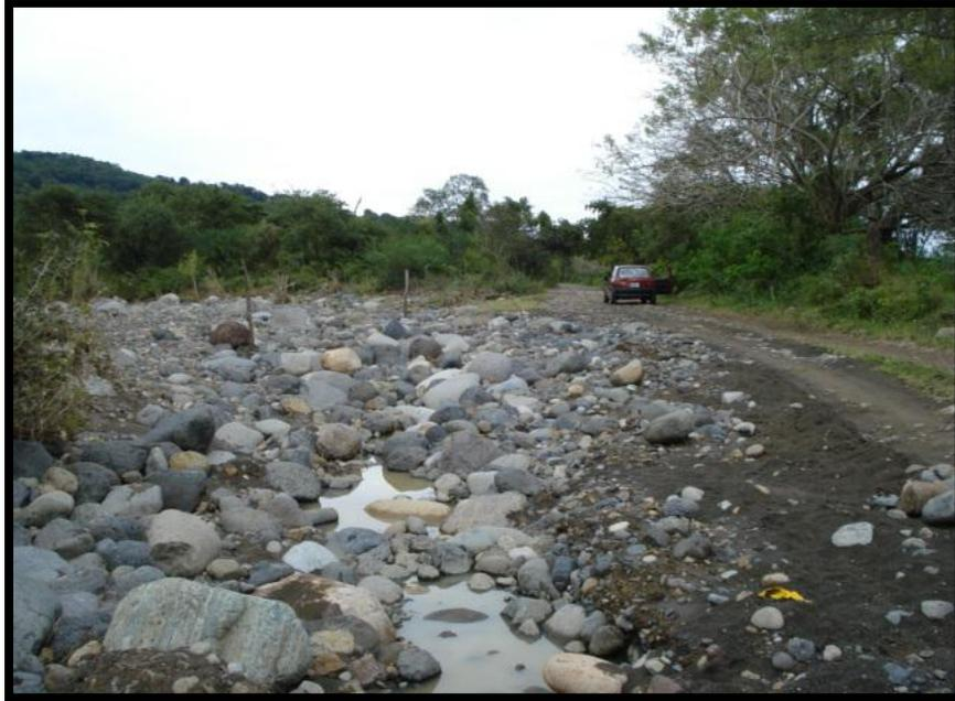
**Figura 36.** Vialidad instalada en cauce de corriente intermitente que en temporada de lluvias impide el paso de vehículos y deja incomunicado a la población aledaña en la localidad Las Iguanas.
