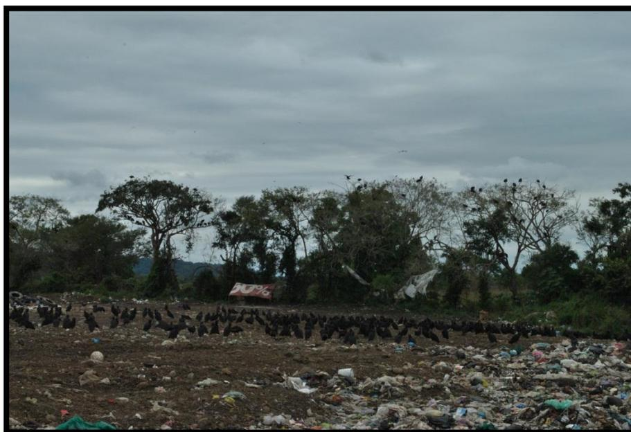
**Figura 41.** Relleno sanitario irregular debido a que presenta carencias de infraestructura, como falta de geomembrana, laguna de lixiviados, tubería de gas metano, cercado arbolado, acopio de residuos, pesa de recepción entre otros en la localidad de San Antonio.
