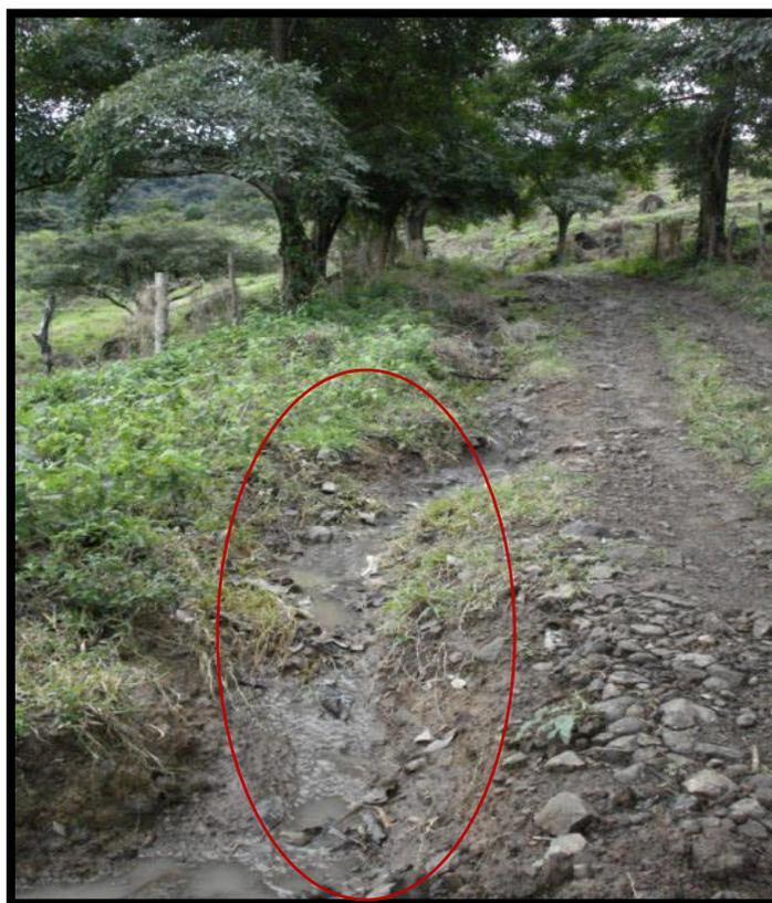
**Figura 30.** Presencia de surcos por erosión hídrica, camino La Florida – El Zapotal.
