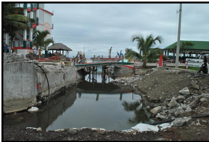
**Figura 45.** Puente colapsado por socavamiento debido a la lluvia atípica del 02 de Enero del 2012 asociadas al frente frío No. 23. en la localidad de Lechuguillas.
