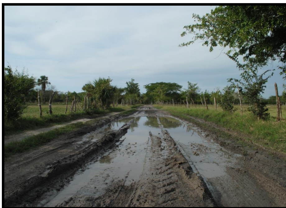
Figura 33. Camino de terracería afectado por encharcamientos, camino Arroyo Canchey – El Hule.
