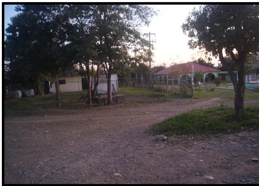
Figura 77. Estación de bombeo que abastece a toda la localidad de La Reforma.
