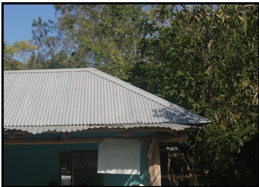
Figura 72. Venta irregular de combustible aproximadamente 100 litros de gasolina y 50 litros de Diesel.
