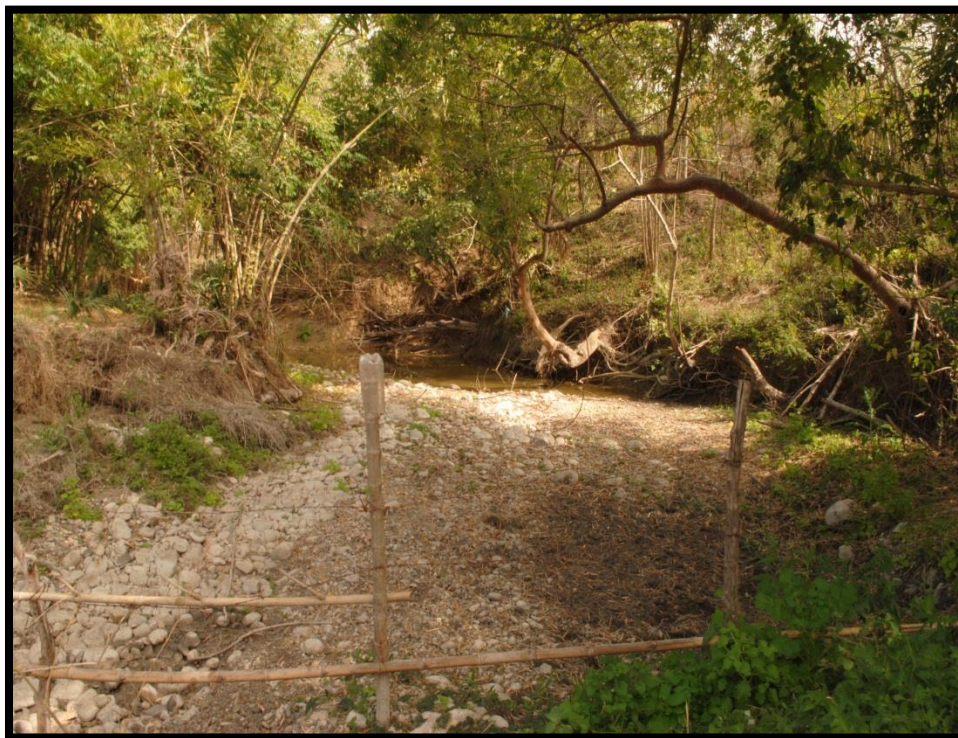
Figura 7. Depósito de materiales y erosión lineal, camino Ejido Alto del Pato.
