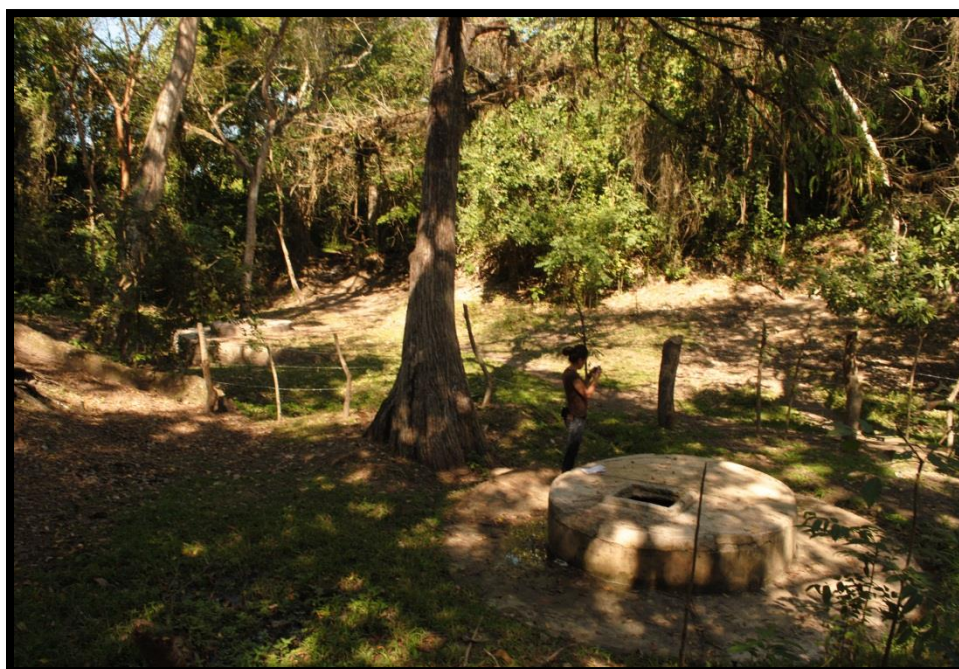
Figura 41. Pozo de agua con aproximadamente 4 metros de profundidad, camino Llano Grande – El Seis.
