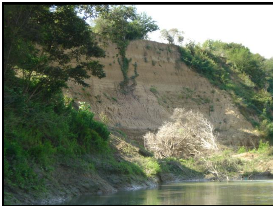
Figura 14. Erosión lineal provocada por el río Tempoal, localidad Alto de Vega Rica.
