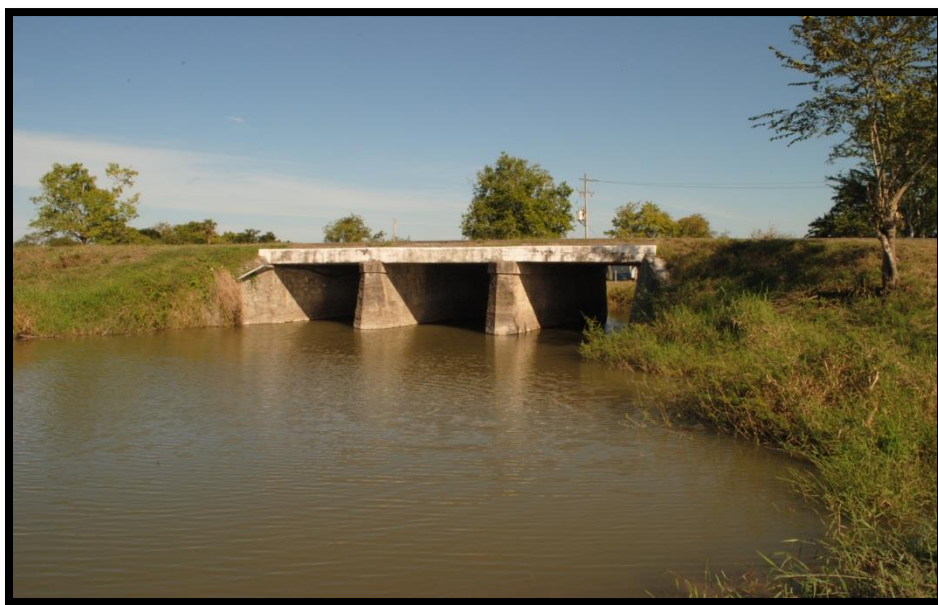
Figura 43. Puente Zapotal. Zona inundable que en temporada de lluvias registra 9 metros de altura. Carretera Federal Tuxpan - Tampico.
