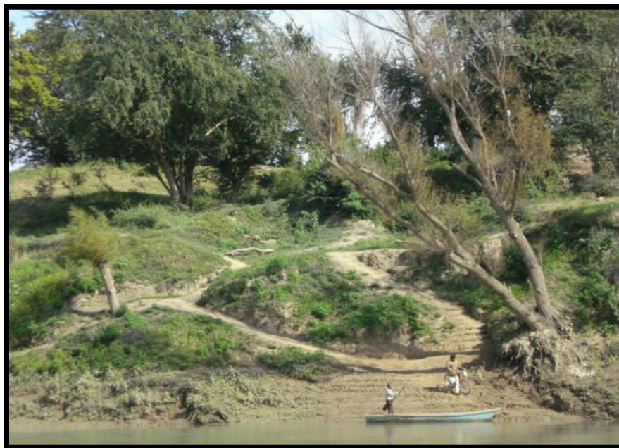
Figura 51. Erosión lineal provocada por el río en localidad Vega Rica Orilla Temporal.
