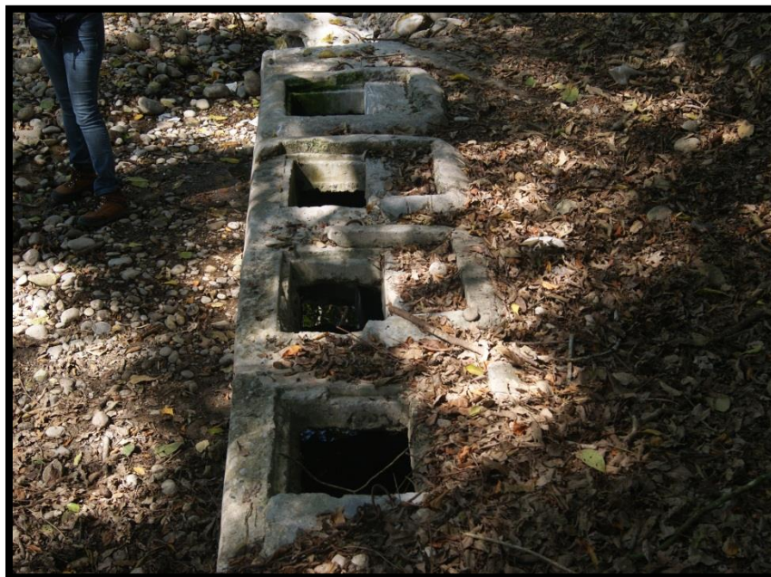
Figura 67. Manantial que abastece a la localidad de El Aguacate Terrero. No se encuentra en operación.
