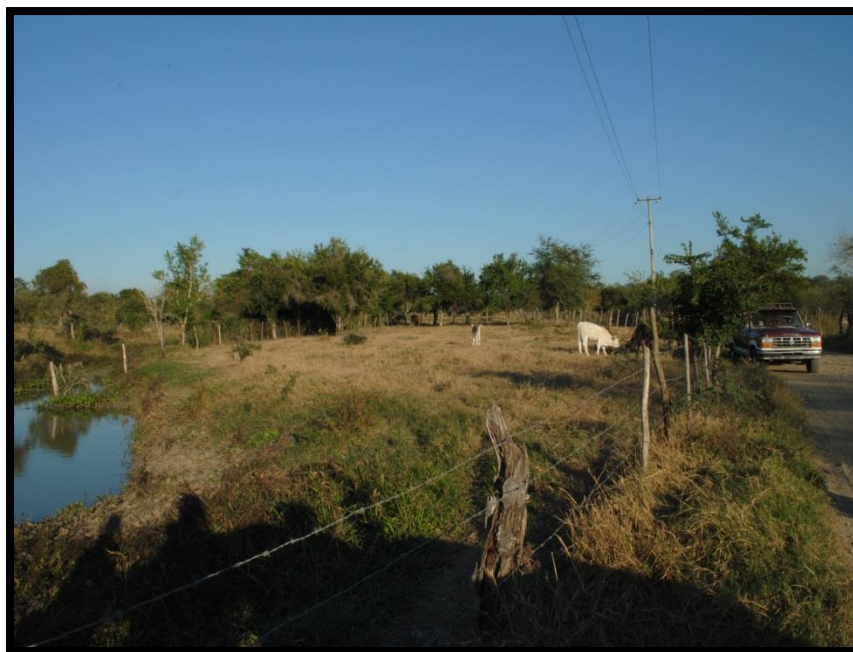
Figura 45. Zona inundable afectada por corrientes intermitentes, en temporada de lluvias cubre aproximadamente 150 metros incomunicando a las localidades circunvecinas. Camino Valantín – La Palma.
