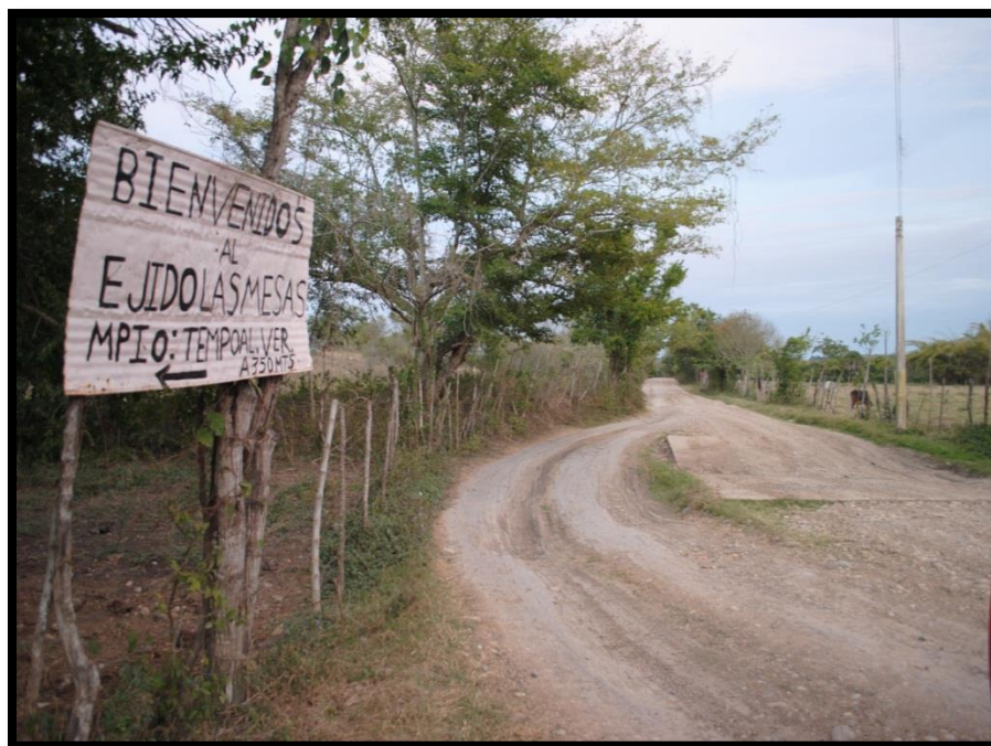
Figura 39. Zona inundable que afecta a camino de terracería. Presencia de vados. Camino Las Mesas – Potrero de Brasil.
