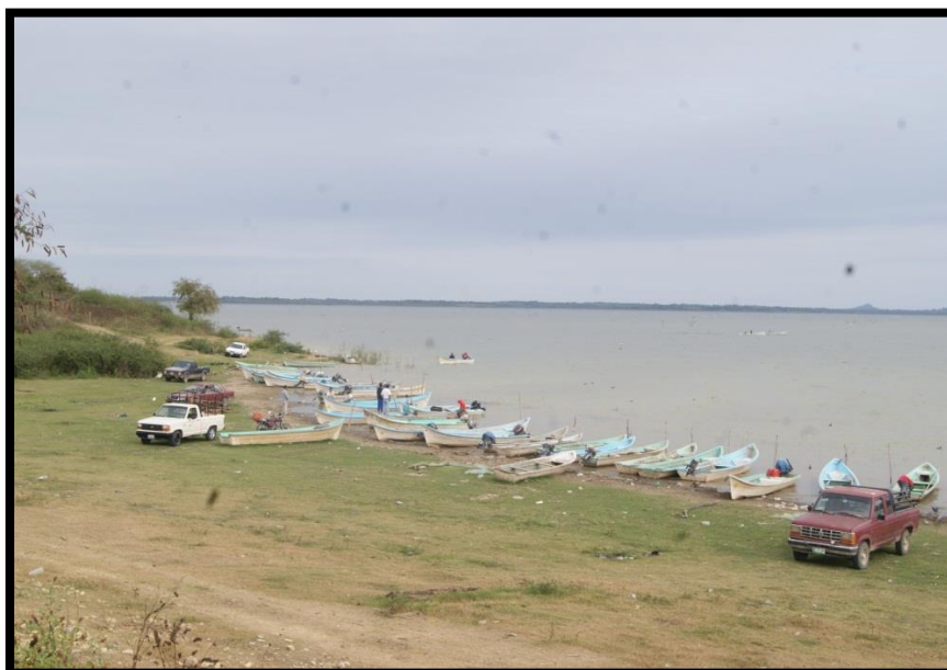
Figura 64. Presa Chicayan. Afectaciones por vientos provenientes del sureste, en temporada de lluvias ocasiona desbordamiento de ríos y arroyos, localidad La Victoria.
