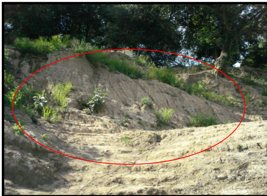
Figura 50. Erosión lineal provocada por el río Temporal en localidad Vega Rica Orilla.
