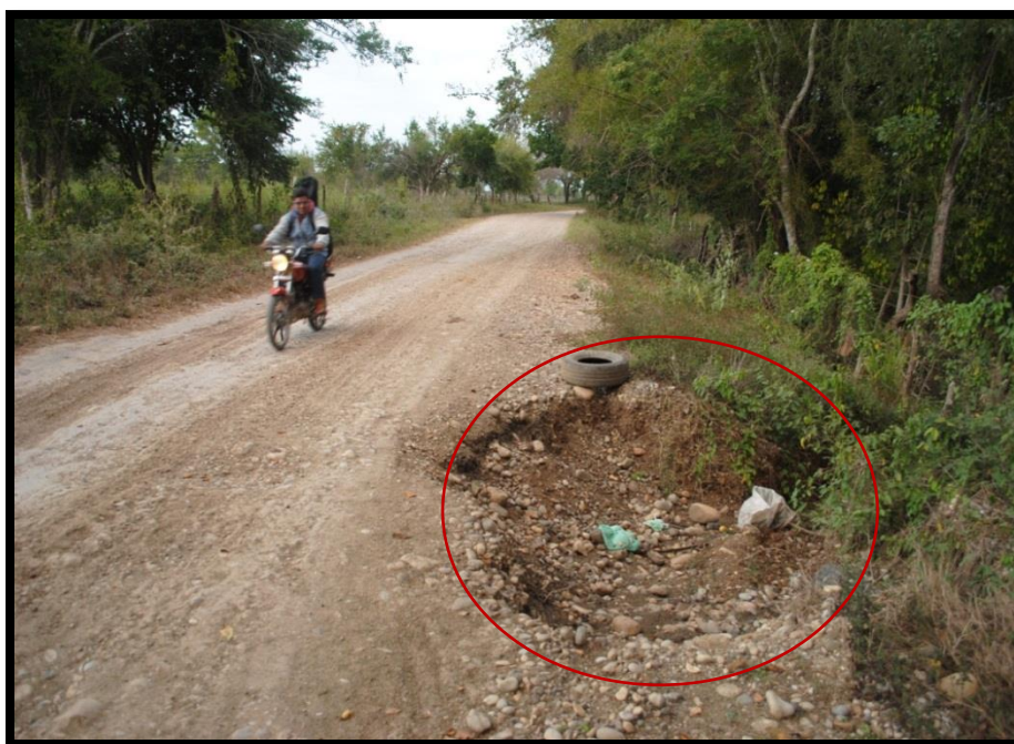
Figura 17. Zona con presencia de cárcavas y deslave en camino de terracería. Tramo hacia la localidad Potrero Brasil.
