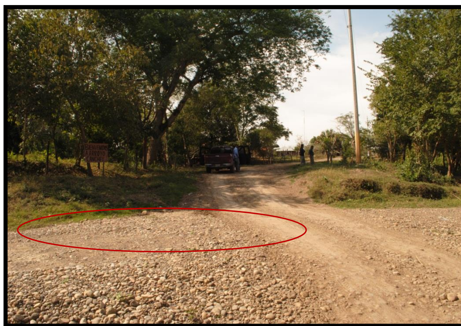
Figura 29. Camino principal de terracería afectado periódicamente por el desbordamiento del Arroyo Canchey incomunicando a la población.
