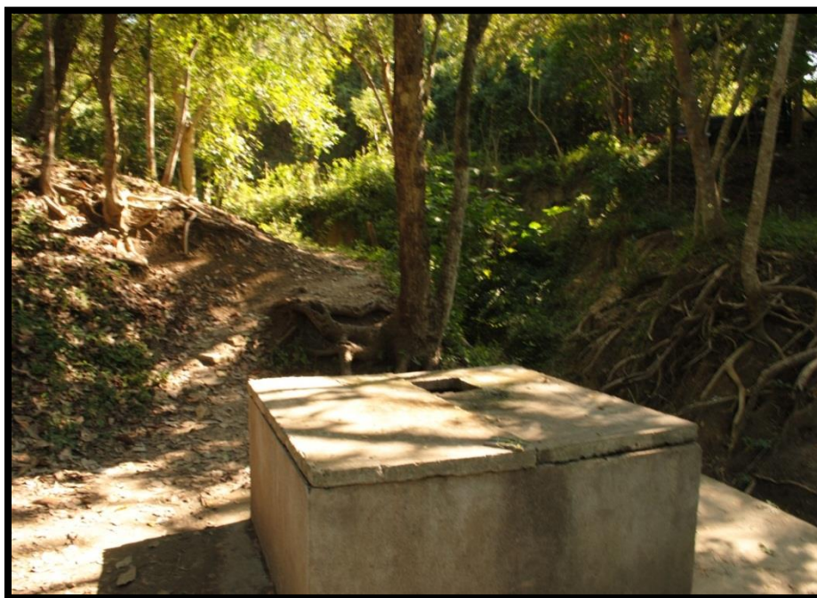
Figura 40. Pozo de agua con 12 metros de profundidad. Erosión lineal provocada por corriente intermitente. Congregación Armadillo.
