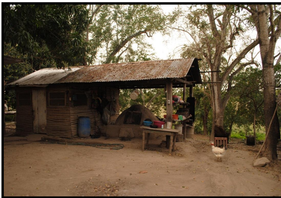
Figura 34. Vivienda afectada por el desbordamiento del río Moctezuma, localidad Tancholin.
