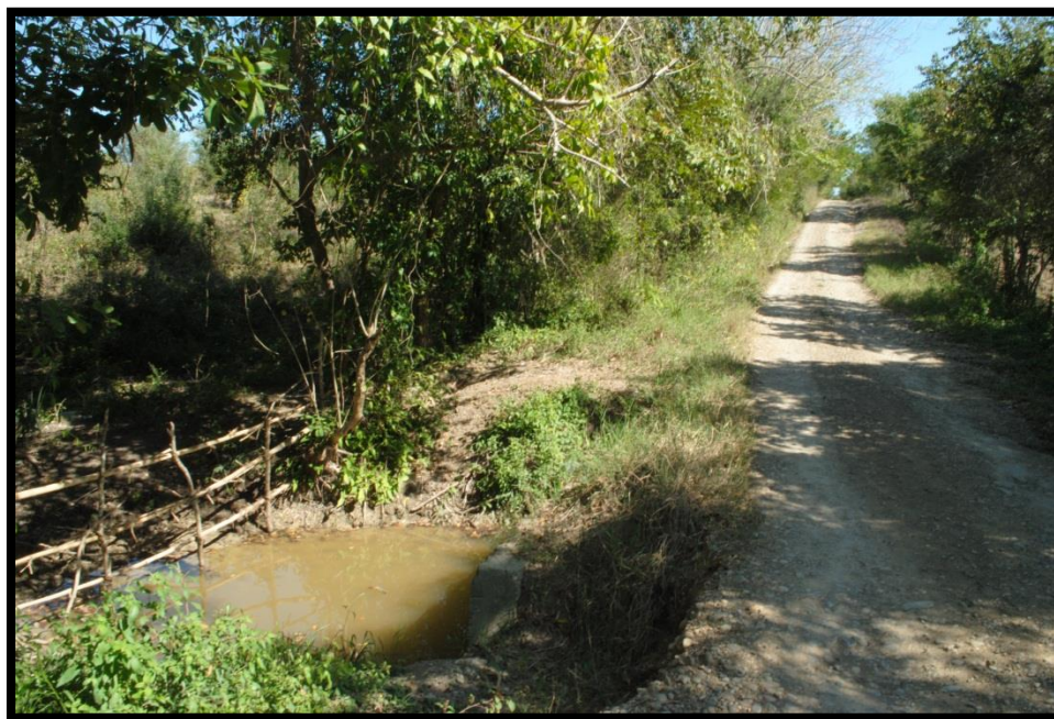
Figura 19. Erosión hídrica. Presencia de surcos. Tramo hacia la localidad San Francisco.
