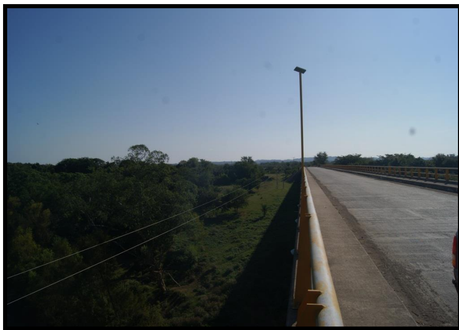
Figura 73. Puente Santa Cruz, construido en 2005, comunica alrededor de 50 localidades en la Cabecera Municipal.
