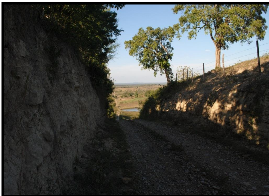
Figura 21. Presencia de deslaves y derrumbes debido a la construcción del camino de terracería sobre el tramo Horcón Potrero. Único acceso para la población.
