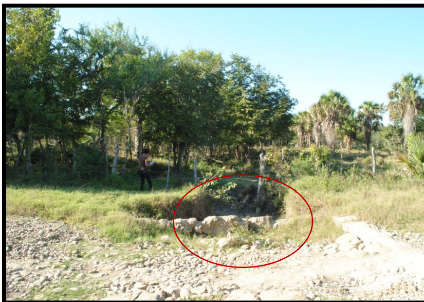
Figura 44. Afluente del río Matachile. Inundando en temporada de lluvias a los pobladores de las localidades circunvecinas. Camino Horcón Potreo – Guayalito.
