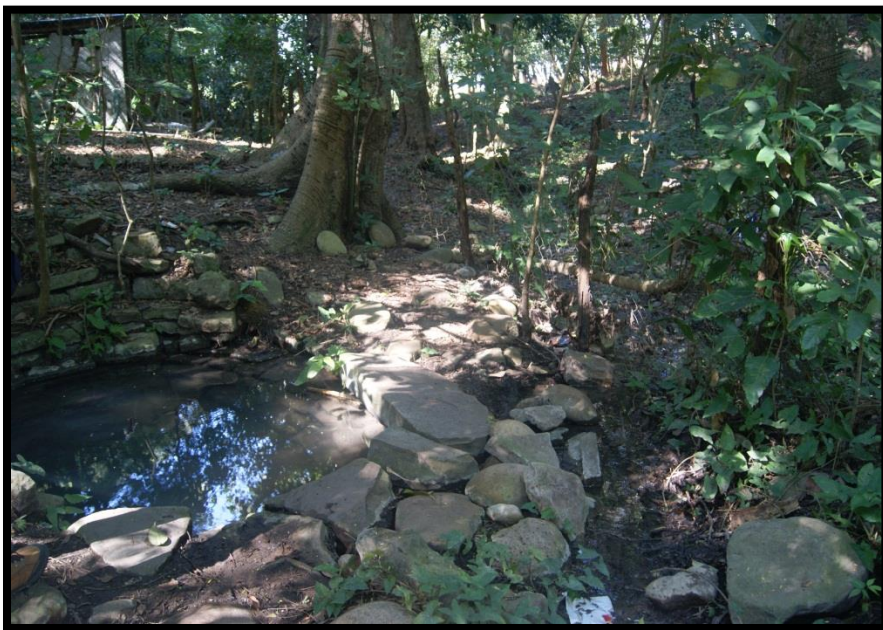
Figura 68. Pozo de agua de 2 metros de profundidad que abastece a la localidad Rangel.
