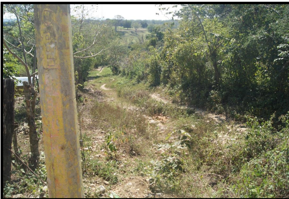
Figura 61. Presencia de cárcavas por erosión hídrica, localidad Santa Fe.
