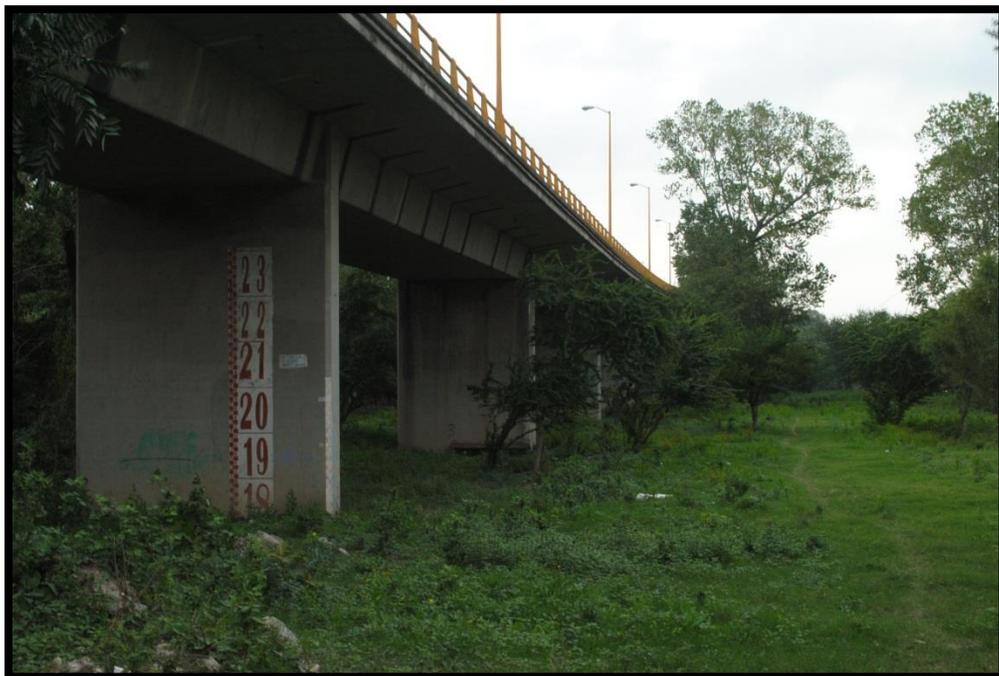
**Figura 12.** Escala de referencia utilizada para indicar los niveles de inundación, en la localidad de Álamo.
