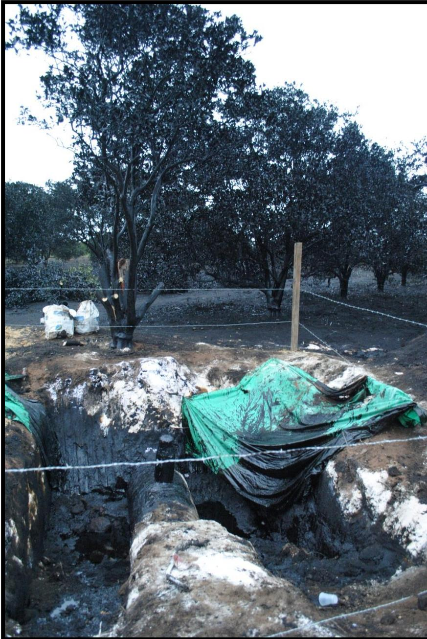
**Figura 15.** Fuga de petróleo en ductos de PEMEX. Alcance de afectación 800 metros a la redonda y hasta 40 metros de altura. Contaminación en cultivos de cítricos. Afectación 6 hectáreas, en la Colonia Lombardista, de la Cabecera Municipal.
