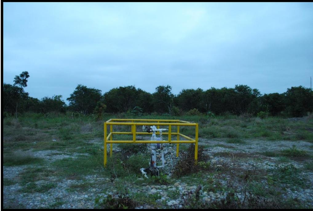
**Figura 18.** Pozo de extracción de gas, en la Colonia Lombardista, de la Cabecera Municipal Álamo.
