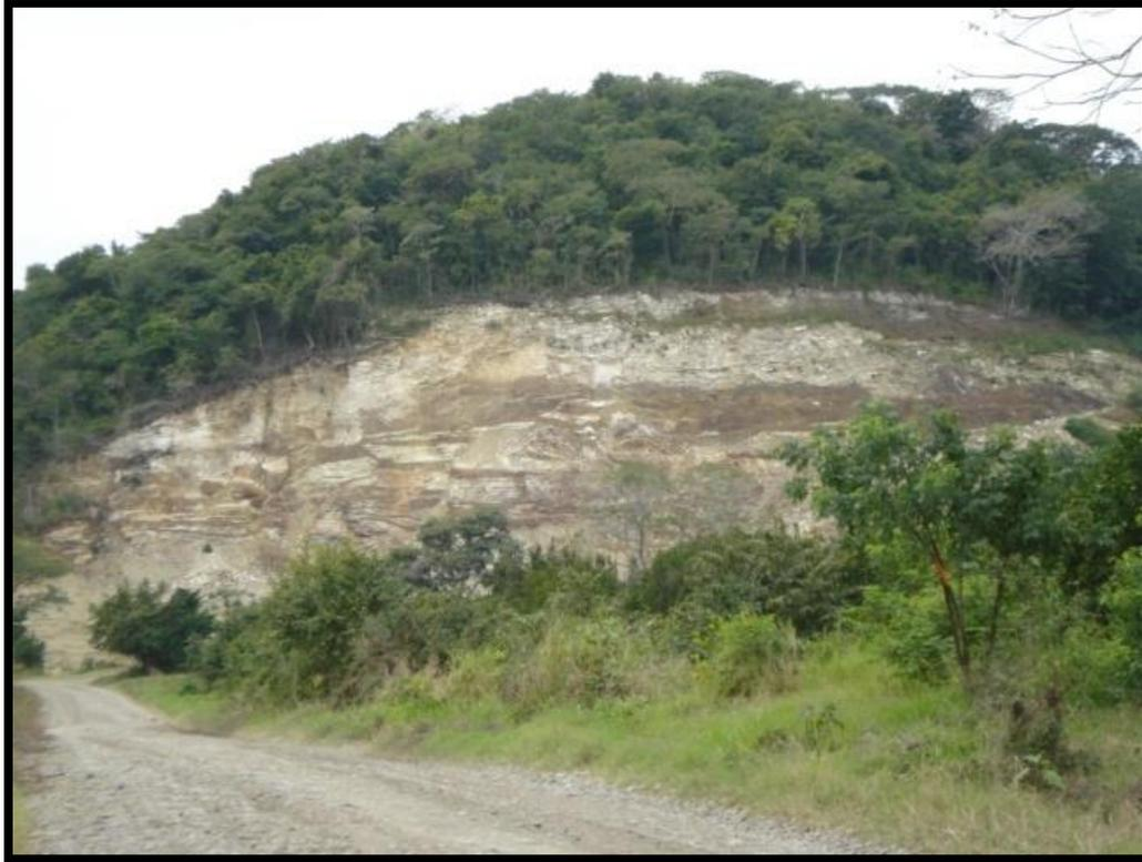
**Figura 28.**Extracción de materiales utilizados para revestimiento, en el tramo carretero La Defensa-Ciudad Madero-Poza Rica.
