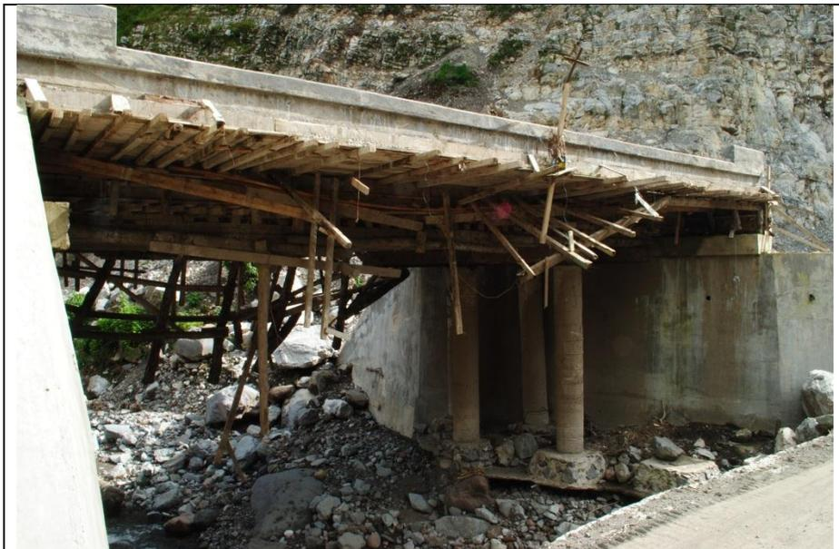
**Fotografía 5.6.** Puente Dañado por Crecimiento del Río Metlac.
