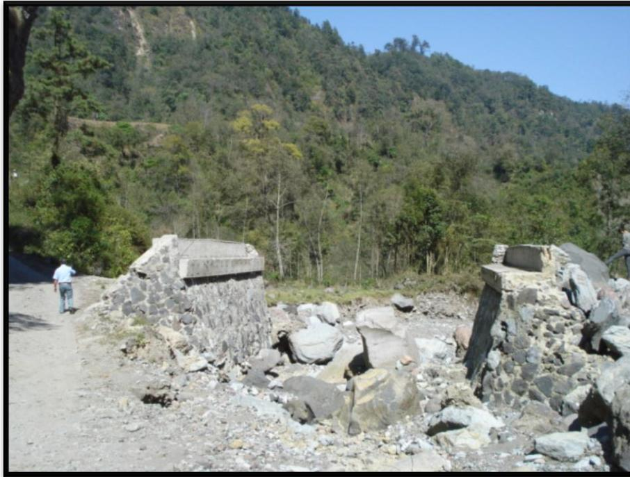
**Figura 47.** Afectaciones por puente inconcluso por aumento del caudal y arrastre de materiales de corriente intermitente en la colonia camino Metlac primero- La Ciénega.
