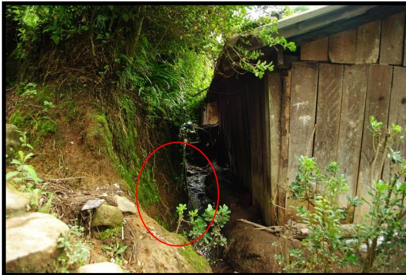
**Figura 8.** Erosión lineal que afecta viviendas en la cabecera municipal.
