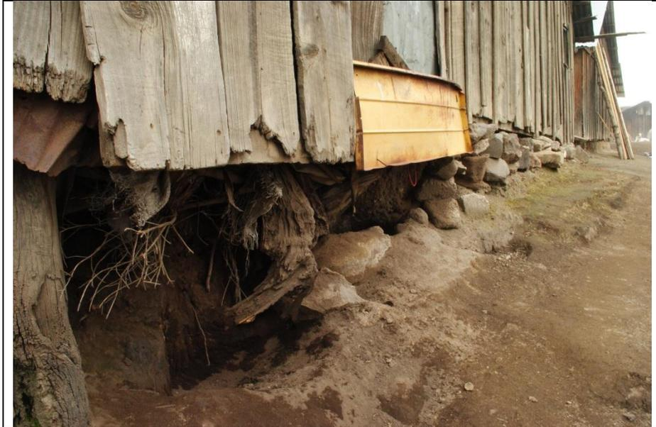
**Fotografía 5.4.** Vivienda Afectada por Escurrimientos Pluviales en la Localidad de Agua Escondida.
