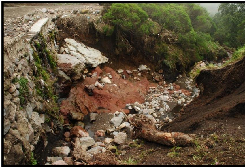
**Figura 17.** Cárcava provocada por erosión lineal en el tramo del camino San Miguel Pilancon – Agua Escondida.
