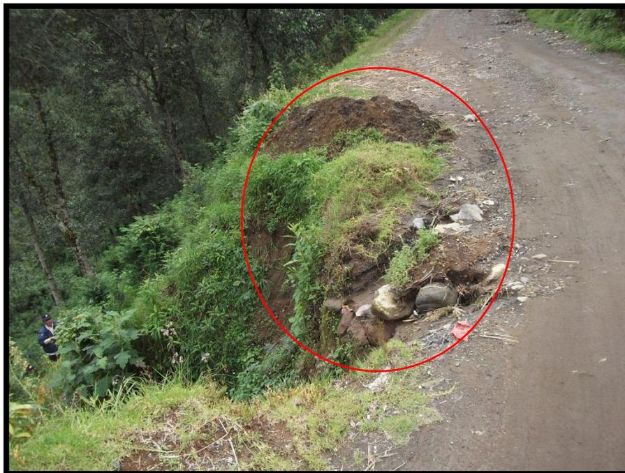
Figura 32. Camino afectado por desgaste de suelo en el camino Chilapa – La Lagunilla.
