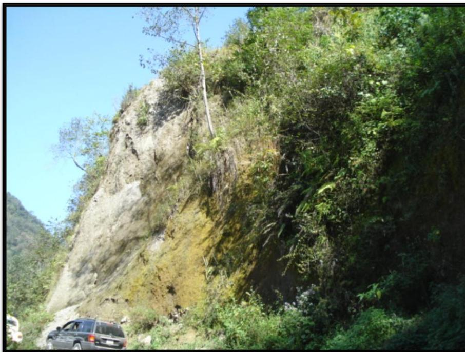
**Figura 50.** Presencia de deslizamientos, antiguo banco de material (arena, grava, piedra) en la colonia Metlac primero.
