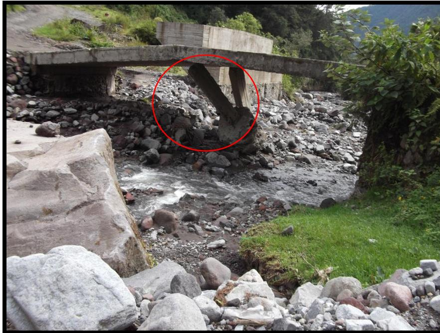
**Figura 24.** Afectaciones en puente por erosión hídrica, aumento del caudal y arrastre de materiales del río Metlac, en la localidad camino Metlac primero- La Ciénega.
