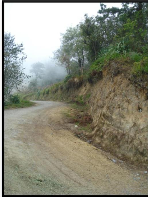
**Figura 57.** Propuesta para ruta de evacuación, posible construcción de terraplén, zona propensa a deslizamientos en Villa Hermosa.
