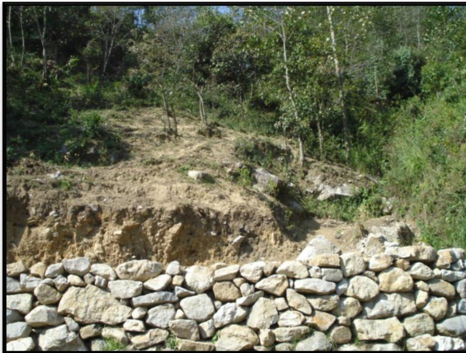
**Figura 52.** Muro de contención en ladera, alledaño a carretera pavimentada en tramo San Lorenzo-Cumbre del Español.
