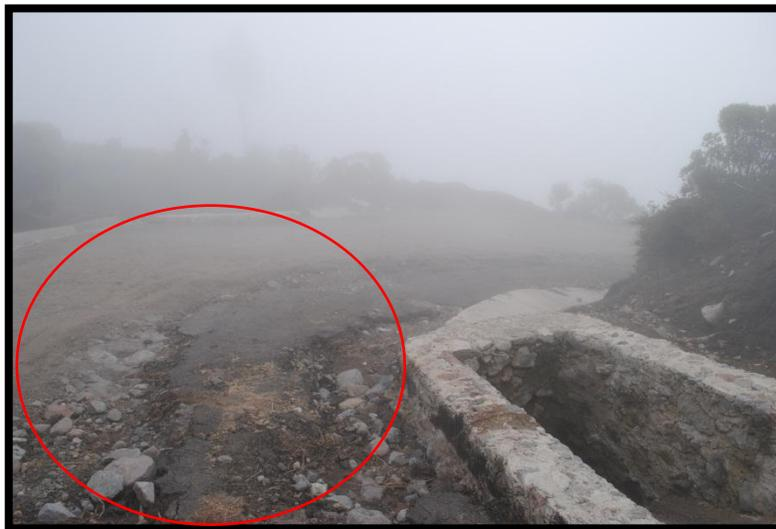
**Figura 2.** Aspecto de neblina y estragos en vialidad por escurrimiento pluvial en tramo San Miguel Pilancón – Agua Escondida
