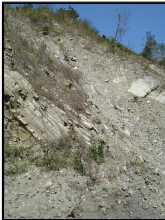
**Figura 46.** Deslave en camino de terracería (Flujos de Detritos), en la localidad Metlac Segundo.
