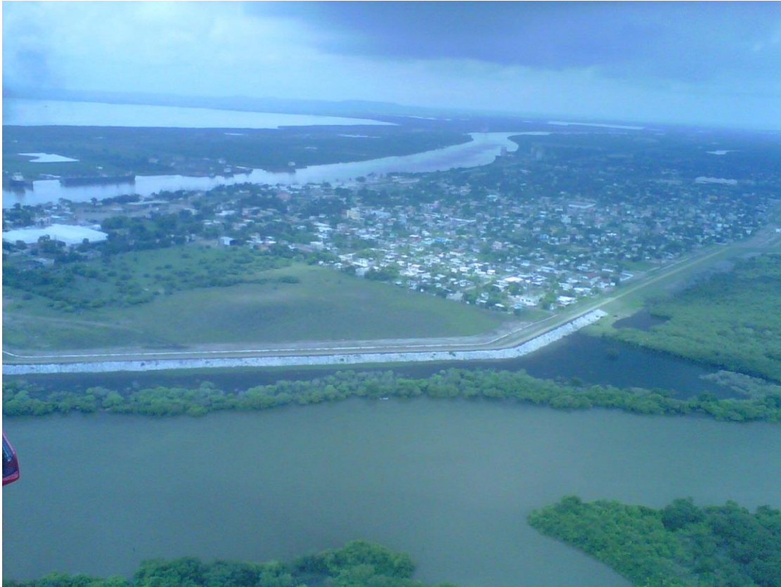
Foto 5.4.1. Localidad de Moralillo, con la laguna del Chairel en la parte inferior de la imagen, y el bordo en construcción, para protección de las inundaciones recurrentes, resguardando el lado más vulnerable de la localidad.
