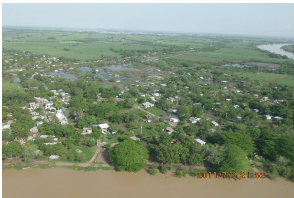
Foto 5.2.6.2. Colmatación del río y desbordamiento hacia las colonias mal ubicadas en el asentamiento.
