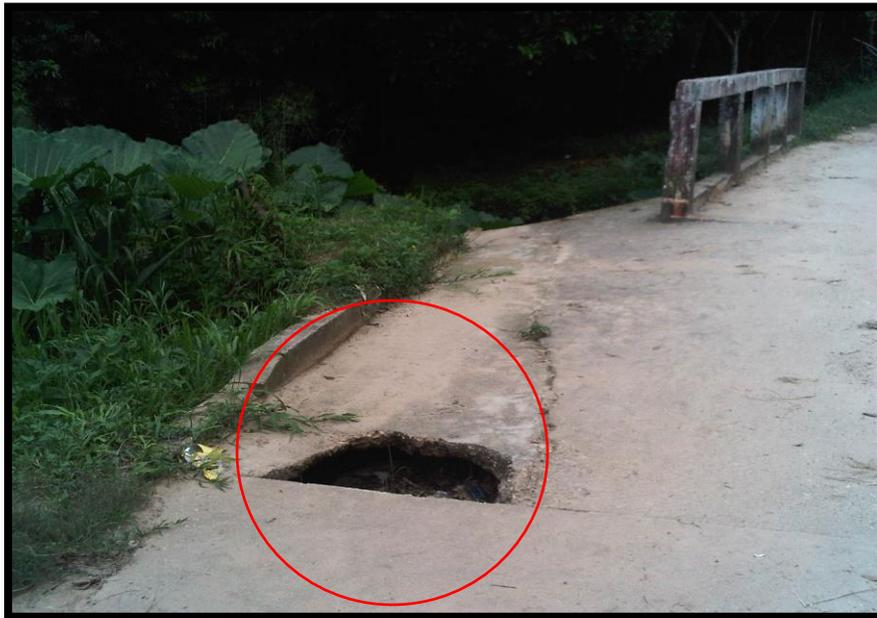
**Figura 10.** Puente en malas condiciones, el arroyo incrementa su nivel un metro.
