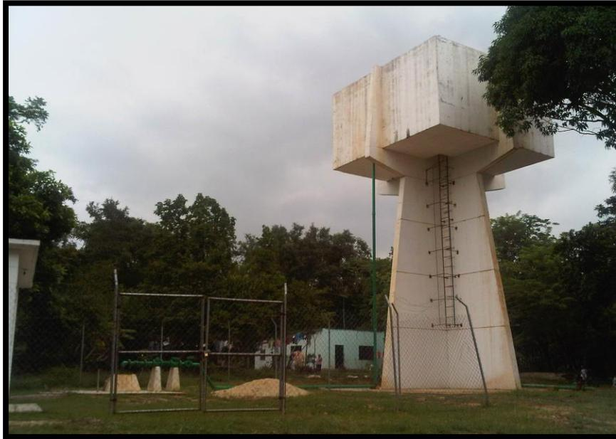
**Figura 5.** Tanque de agua número 3 capacidad de 100,000 litros instalado en la colonia Tierra Colorada, abastece a esta colonia, El Porvenir y una porción de Tapalan.
