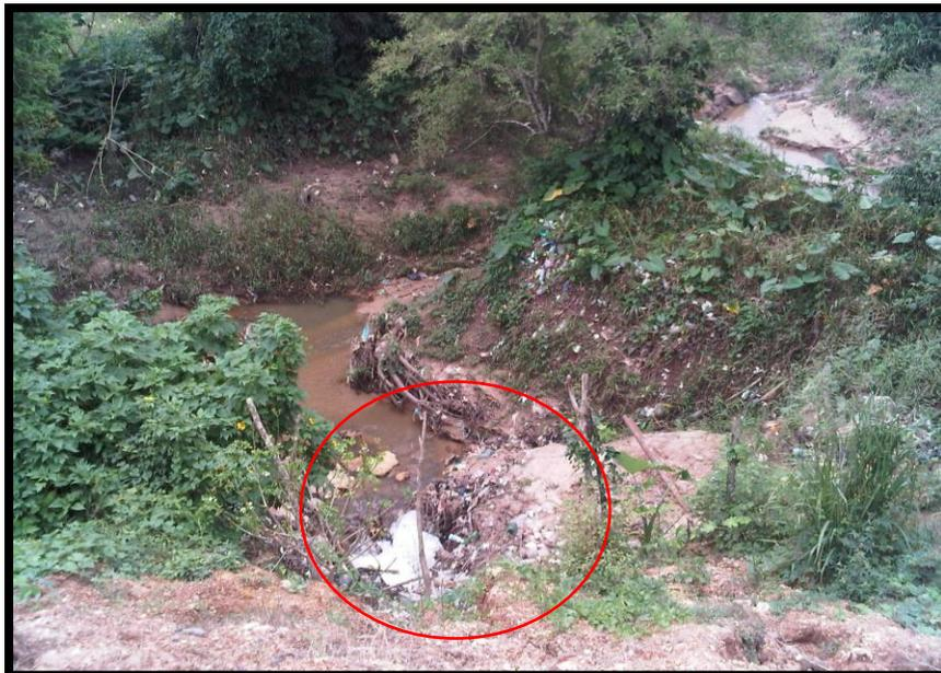
**Figura 2.** Paso del Encanto, conducto que se obstruye por el transporte de sedimentos y acumulación de residuos sólidos, pasa bajo las vías del tren (límite entre Chinameca y Oteapan).
