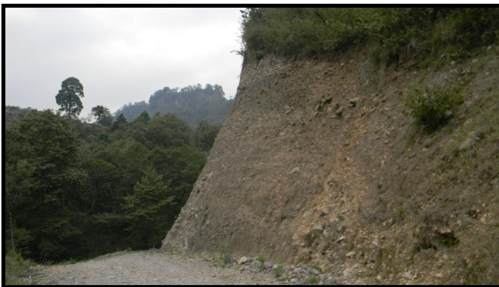
Figura 11. Deslave, pendiente con 80° de inclinación en camino a Tepexilotla.
