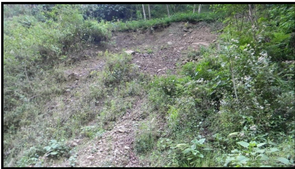
Figura 13. Movimientos de remoción en masa en la localidad Carrizal.
