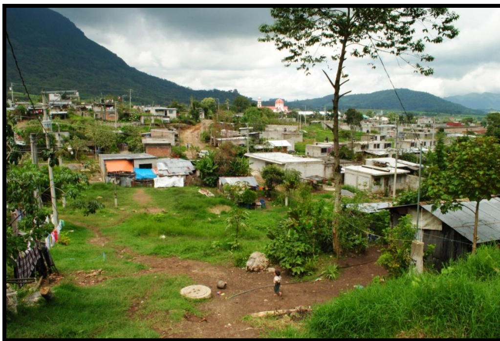
Figura 20. Zona de encharcamiento en la cabecera municipal.
