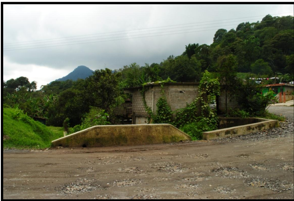
Figura 21. Puente en la entrada a la localidad Rincón Pintor, zona de encharcamiento.
