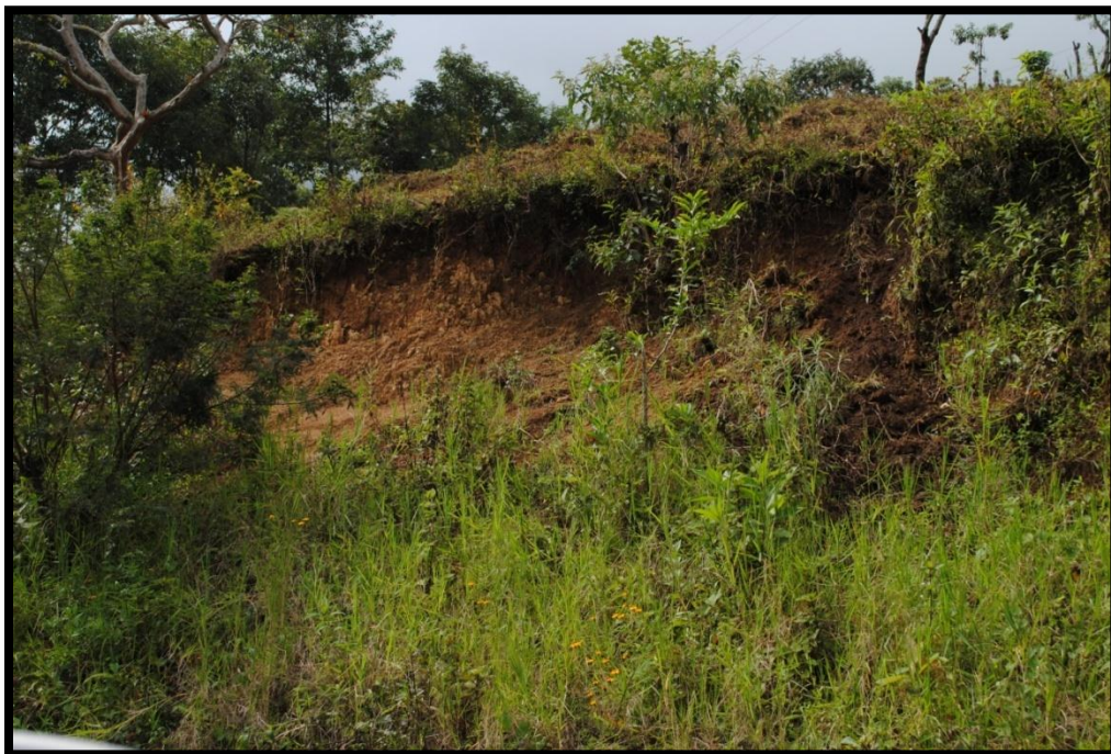
Figura 25. Zona de derrumbe y erosión.
