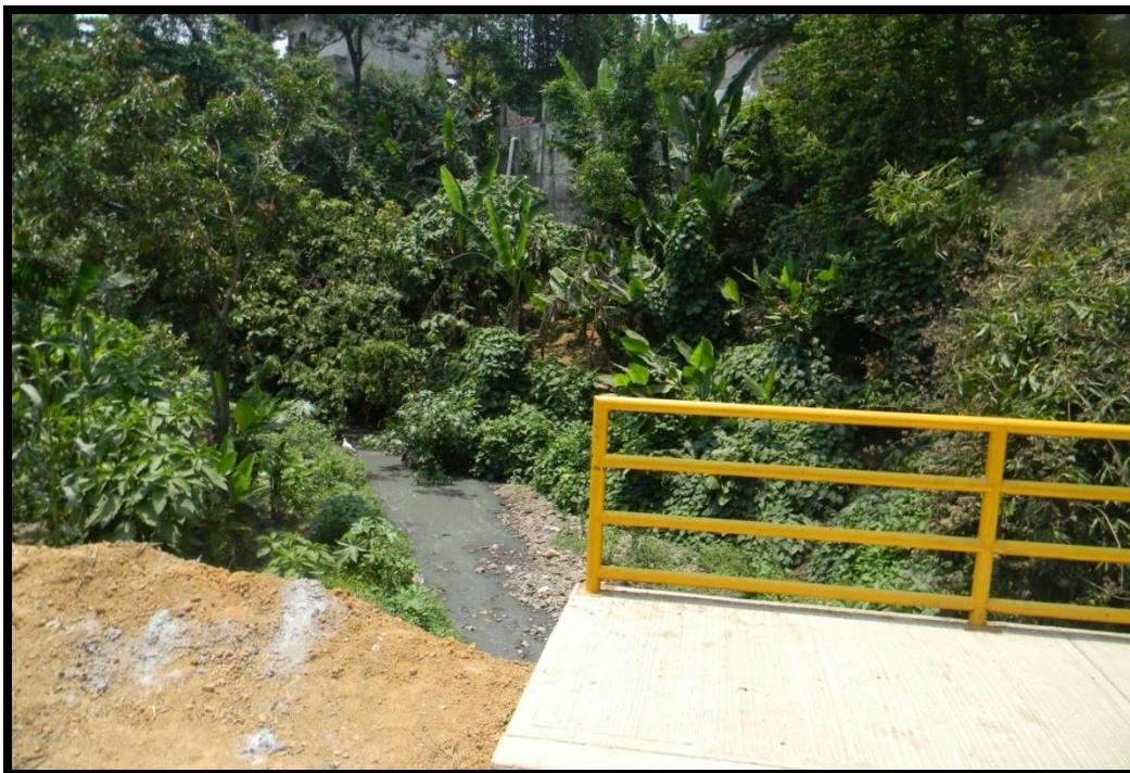
Figura 3. Arroyo de aguas residuales, movimiento de remoción en masa, inundación en 2003.
