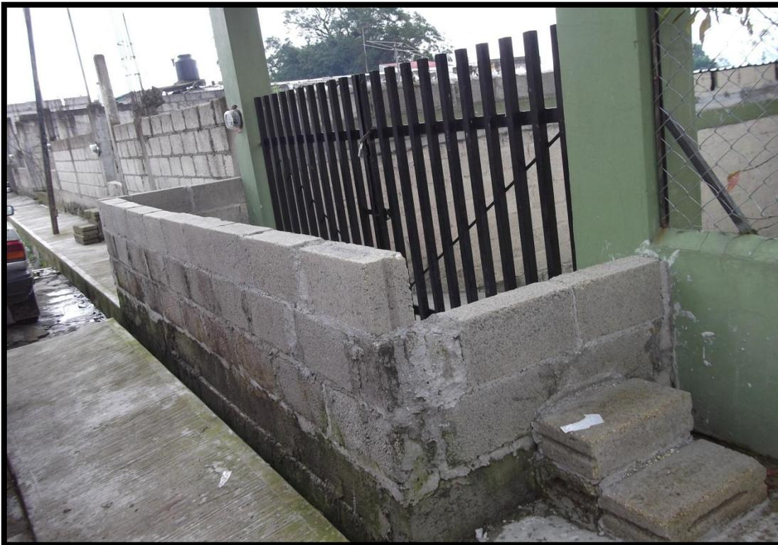
**Figura 9.** Vivienda en la que se instaló muro de 1.2 metros para impedir paso de agua.
