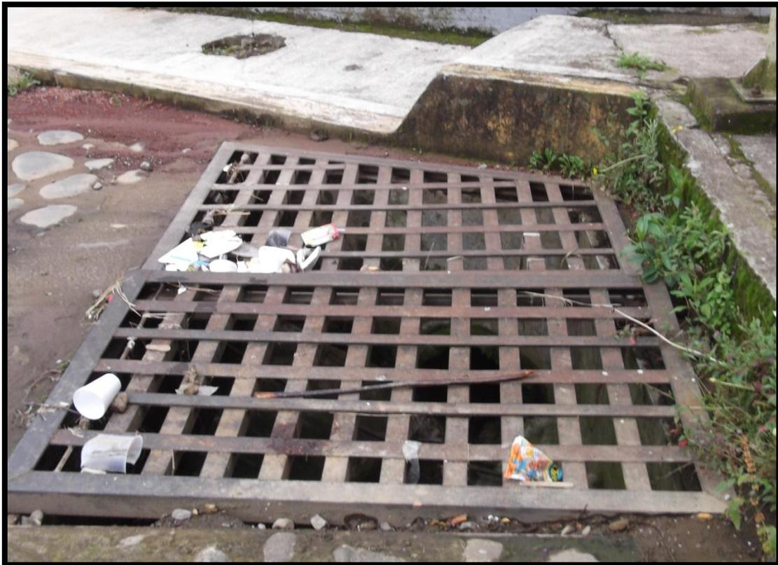
**Figura 11.** Zona de encharcamiento de agua por exceso de agua en alcantarillado.
