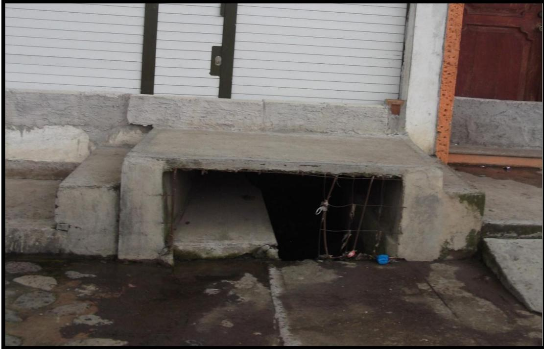
**Figura 10.** Canal de conducción con capacidad insuficiente para captación de agua.
