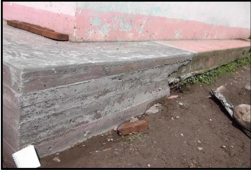
**Figura 30.** Vivienda vulnerable a inundacion por desviamiento de corriente superficial.
