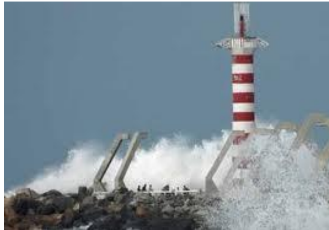
Imagen V. 2. 1. e. Oleaje que producen los ciclones tropicales sobre la zona costera de Coatzacoalcos.
