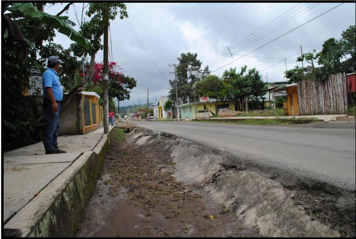
**Figura 27.** Cuneta con sedimentos.
