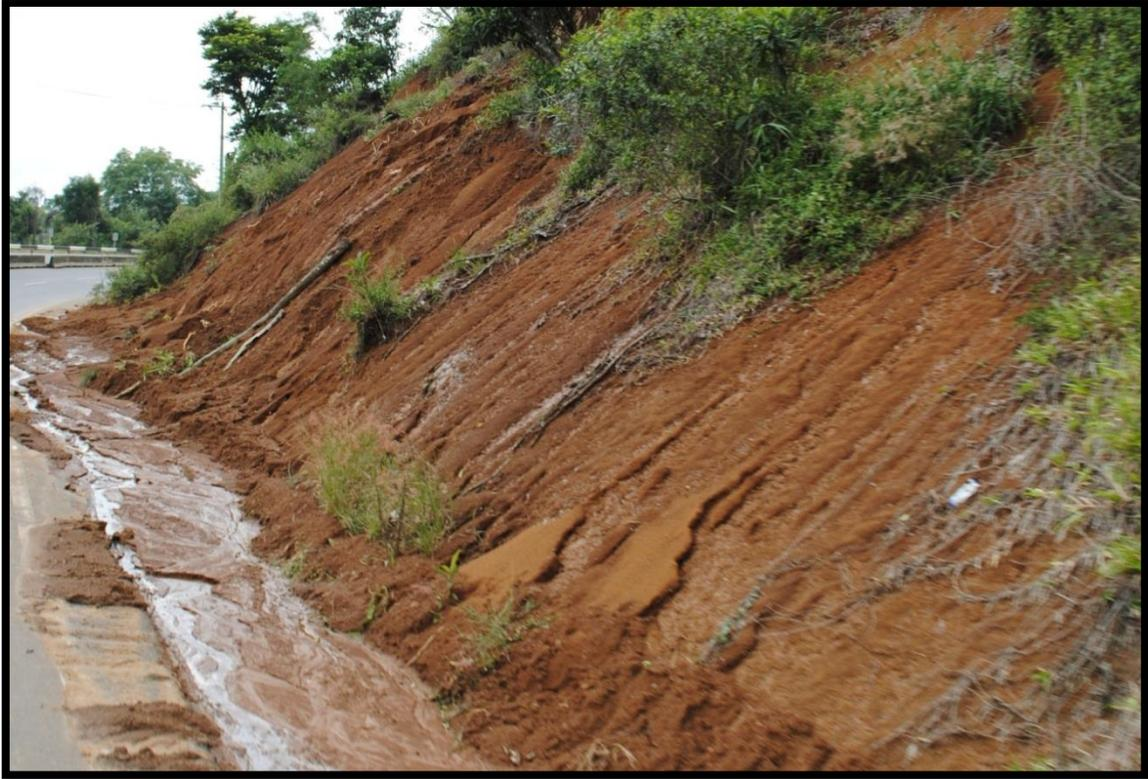
**Figura 37.** Movimiento de remolicon de masa.
