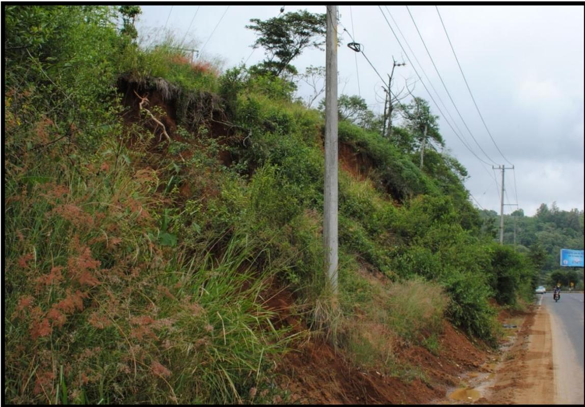
**Figura 38.** Afectacion de movimientos de remolicon de masas.
