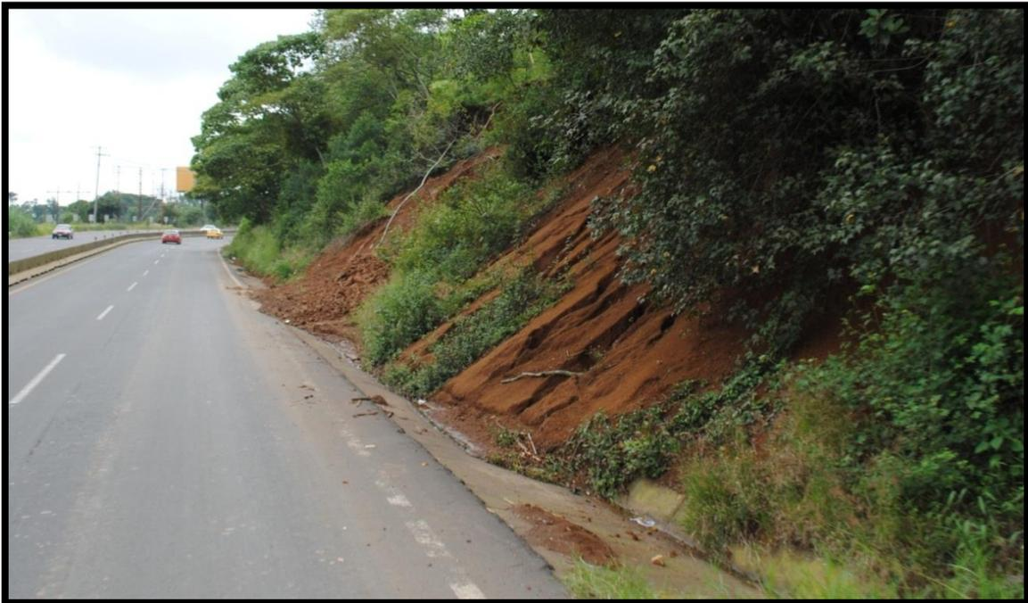
**Figura 36.** Movimientos de remolicion de masas sobre la carretera Xalapa-Coatepec.
