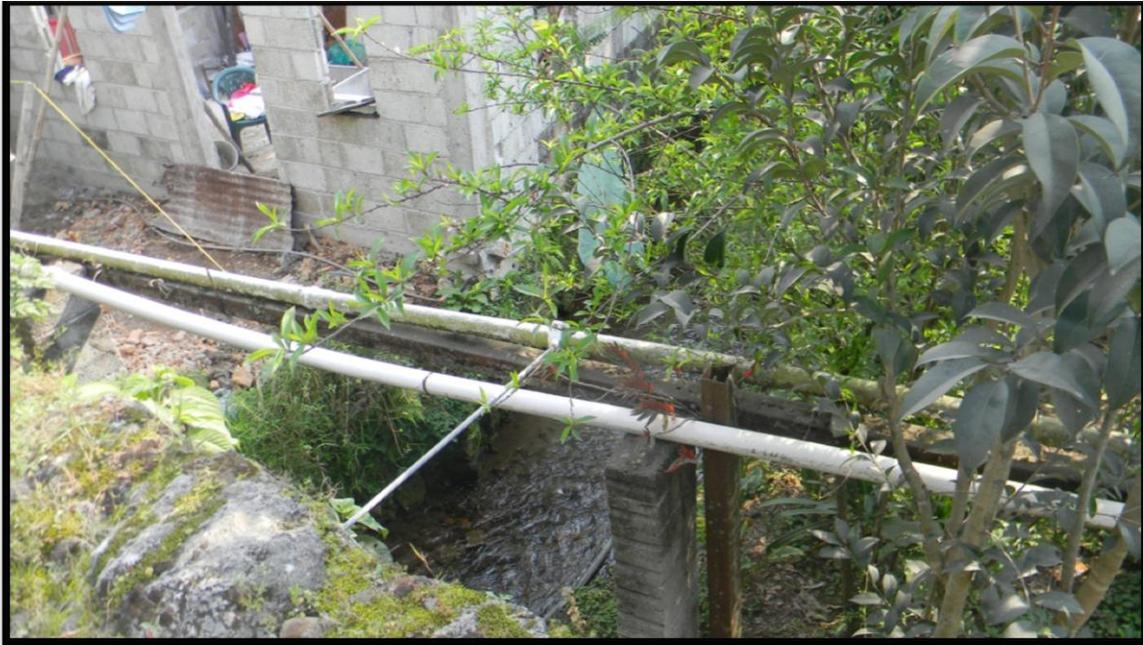
**Figura 50.** Puente en riesgo de colapsar en Atzacán.
