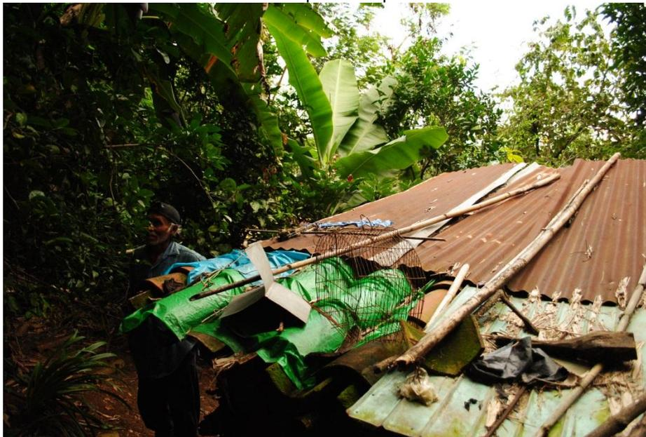
**Fotografía 5.9.** Techo de Lámina de Asbesto y Objetos que son Usados para Retenerlas, lo que aun así es Peligroso Debido a que al Ser Arrasados por el Viento Pueden Impactar en Alguna Persona o Casa.
