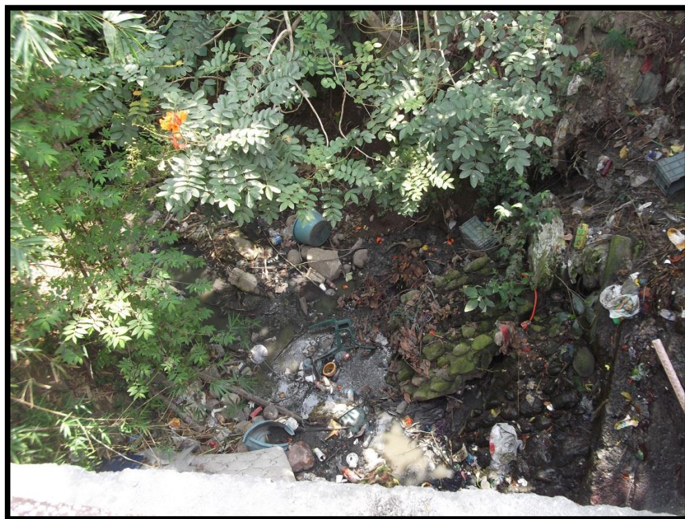
Figura 22. Descarga de aguas residuales.
