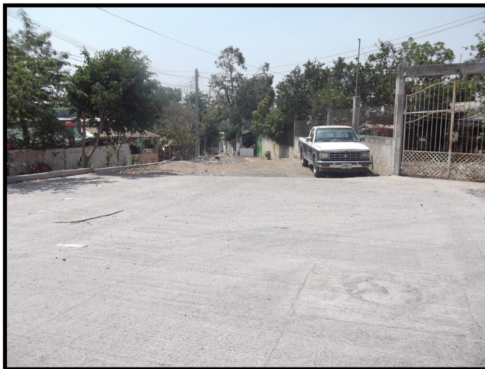
Figura 3. Zona de Inundación en José Cardel.
