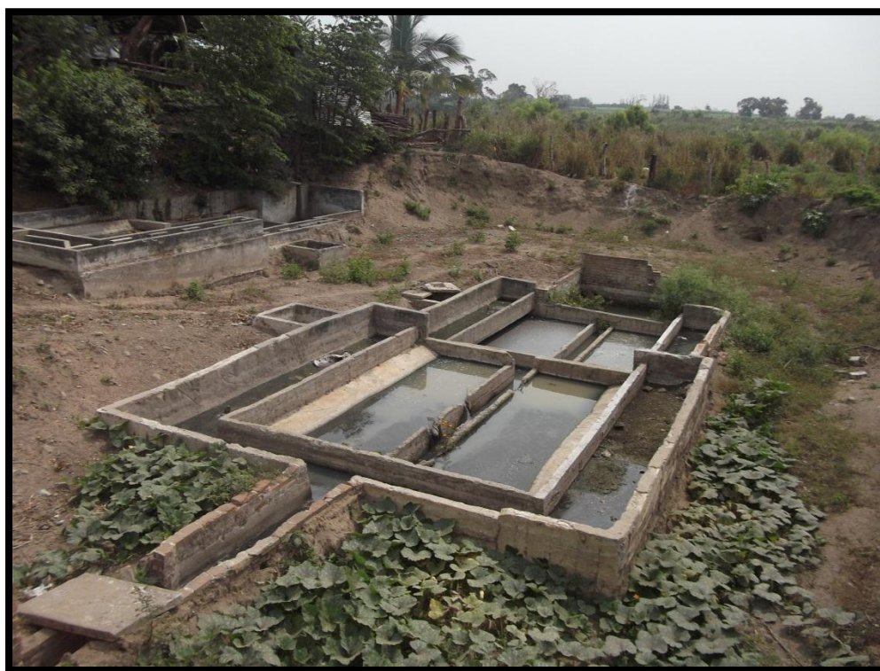
Figura 28. Descarga de aguas residuales.
