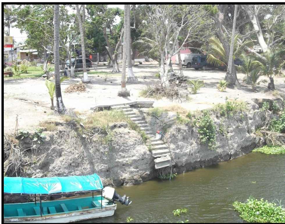
Figura 12. Erosión laminar que afecta instalaciones recreativas en la localidad La Posta.
