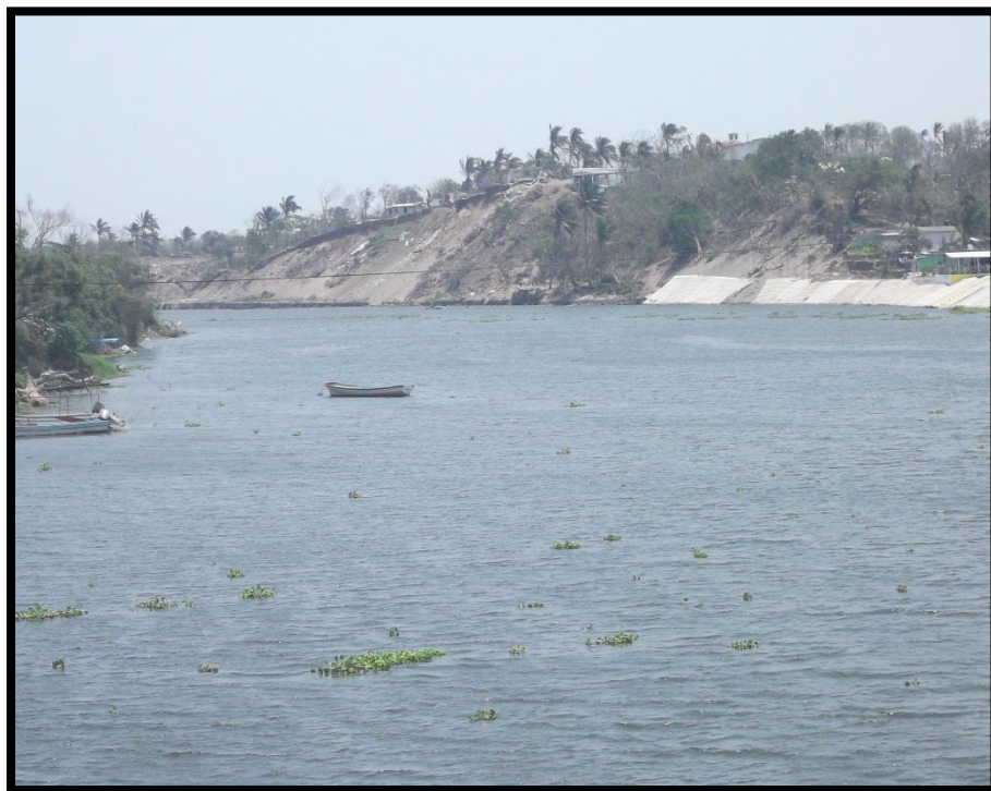
Figura 9. Erosión laminar provocada por río La Antigua durante el huracán Karl, viviendas vulnerables.
