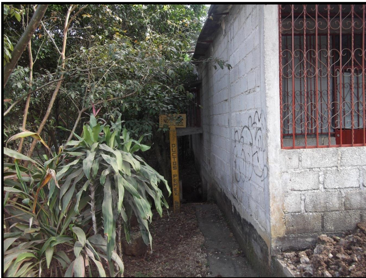
Figura 12.- Gaseoducto Pemex, Tubería de 12" en la Localidad de Guadalupe (La Patrona), Amatlán de los Reyes.
