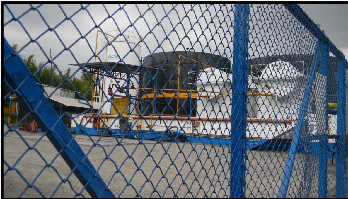
Figura 25.- Estación de Distribución de Combustible, Instalada en las Inmediaciones de la Localidad Peñuela, Amatlán de los Reyes. Almacenan Combustibles en una Cantidad Considerable.
