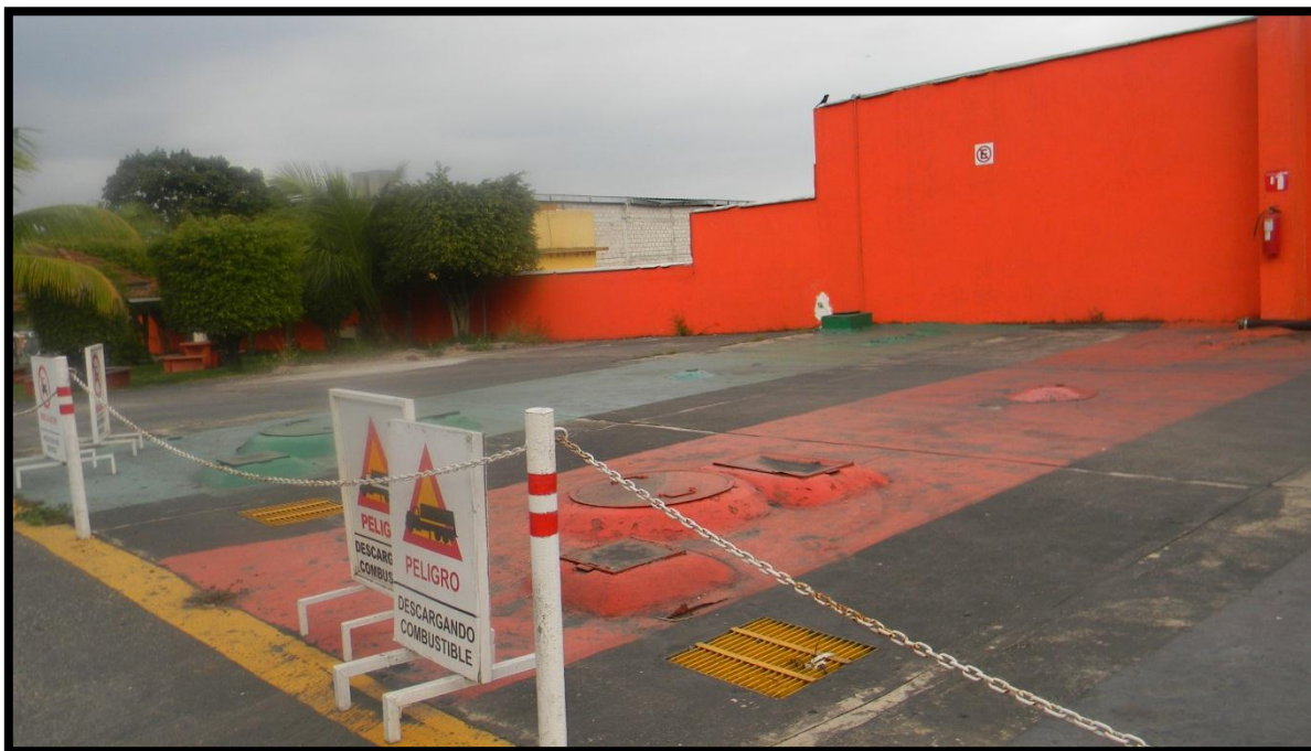
Figura 24.- Gasolinera E.S. 4357 Instalada en Noviembre de 1995, en la Localidad de Rancho Trejo, Amatlán de los Reyes.
