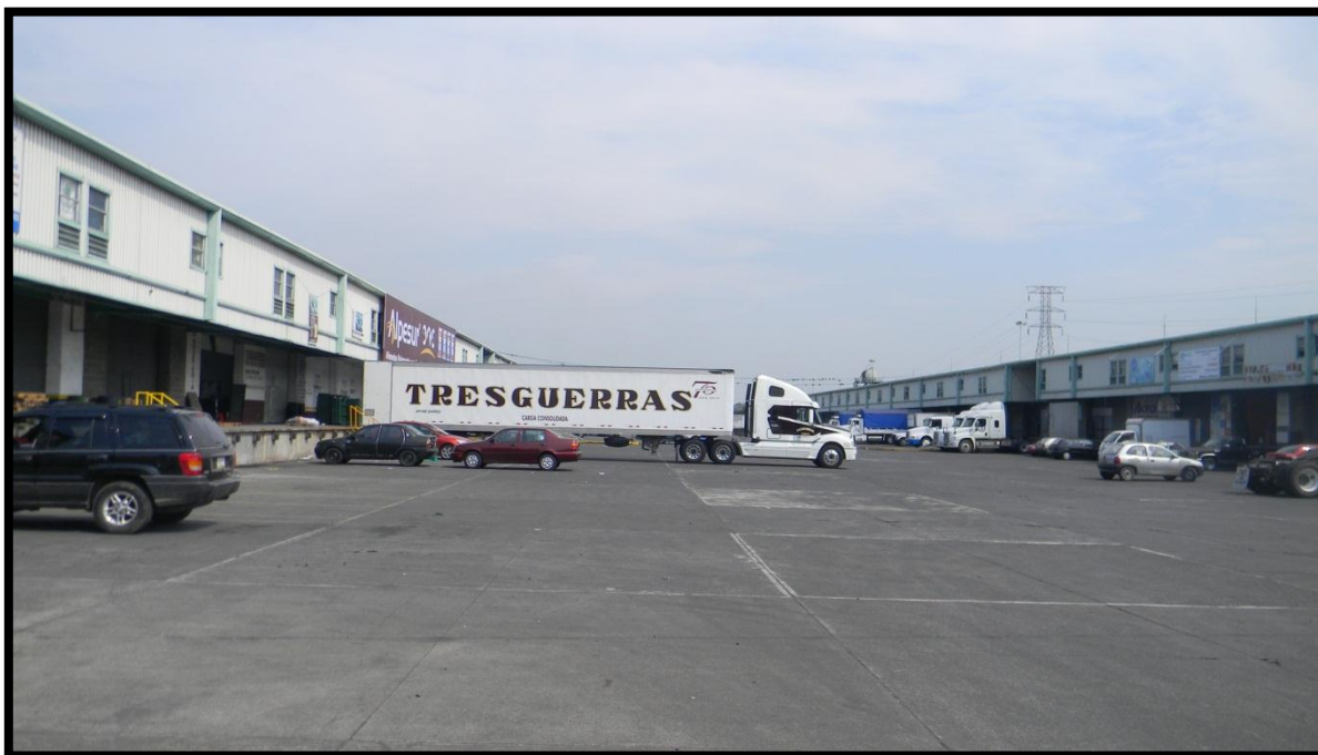
Figura 33.- Conjunto de Bodegas para Arrendamiento "Central de Abastos" se Almacenan Sustancias Químicas Peligrosas.
