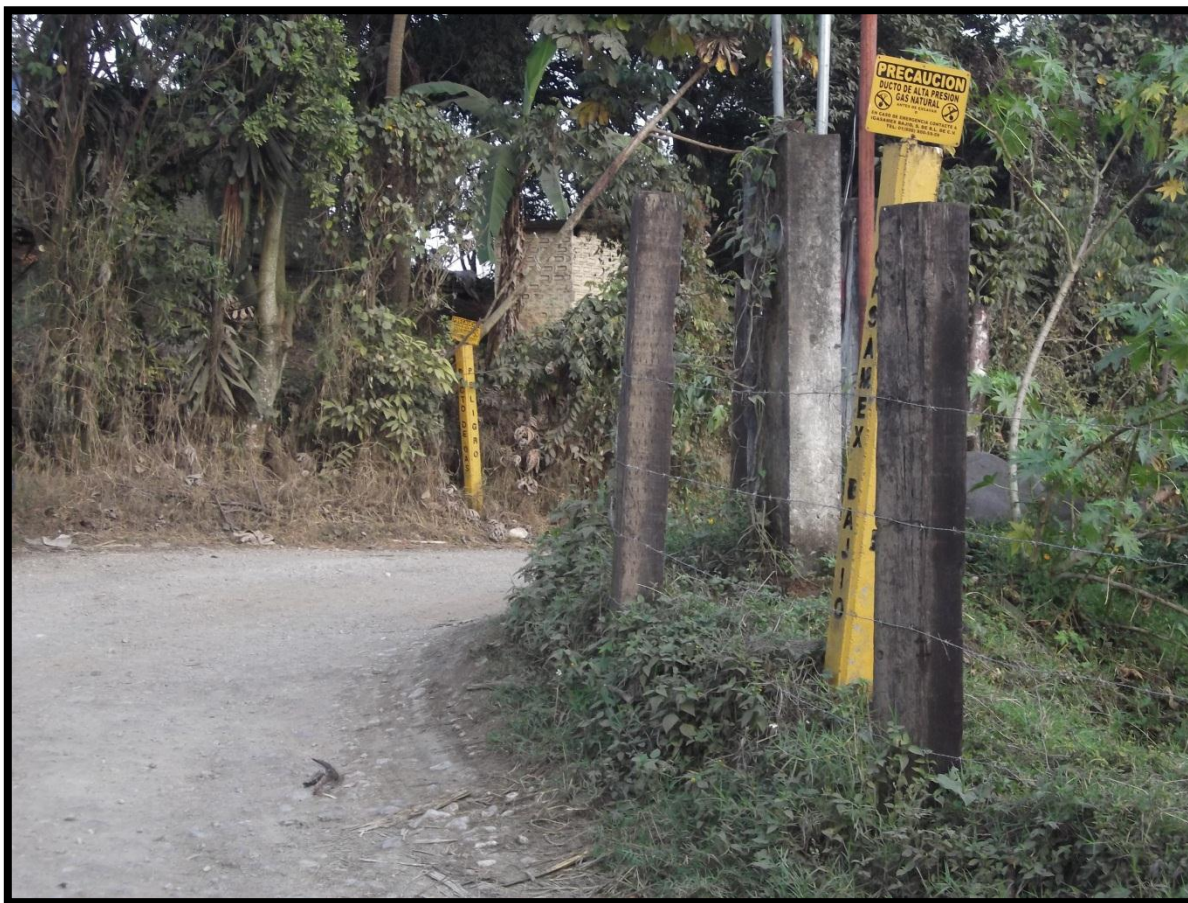
Figura 20.- Gaseoducto, Igasamex. Sigue la Línea Hacia el Este 80, en la Localidad El Porvenir, Amatlán de los Reyes.
