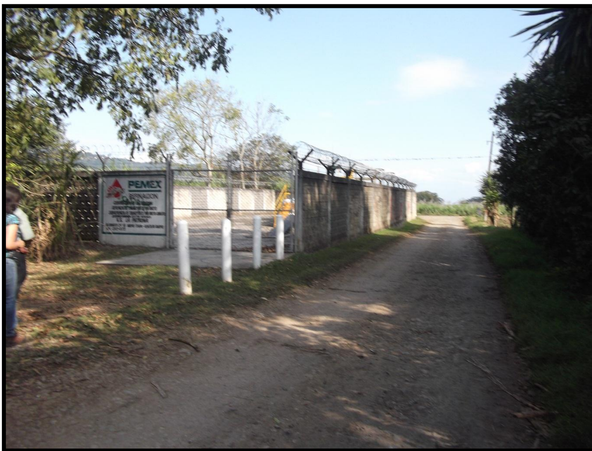
Figura 14.- Estación de Bombeo V.S. La Patrona. Oleoducto de 24" de Diámetro. Nuevo Teapa-Venta de Carpio. Km 510+575.
