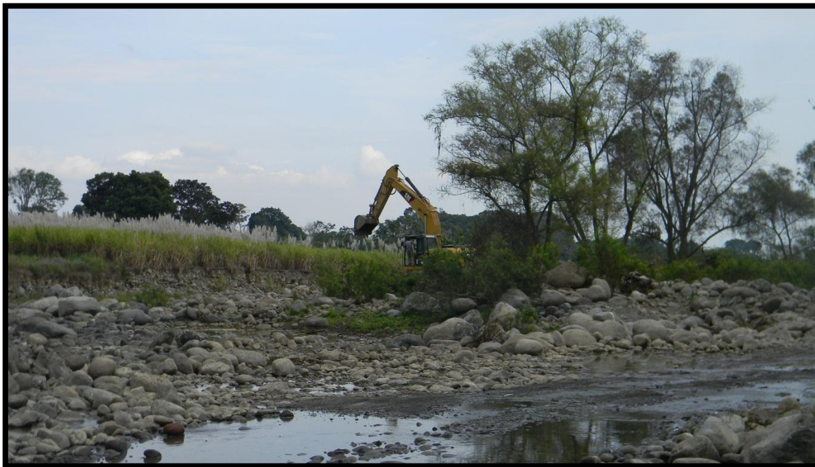
Figura 7.- Extracción de Rocas del Río Seco con la Finalidad de Desazolvarlo en la Localidad Paraje Nuevo, Amatlán de los Reyes.
