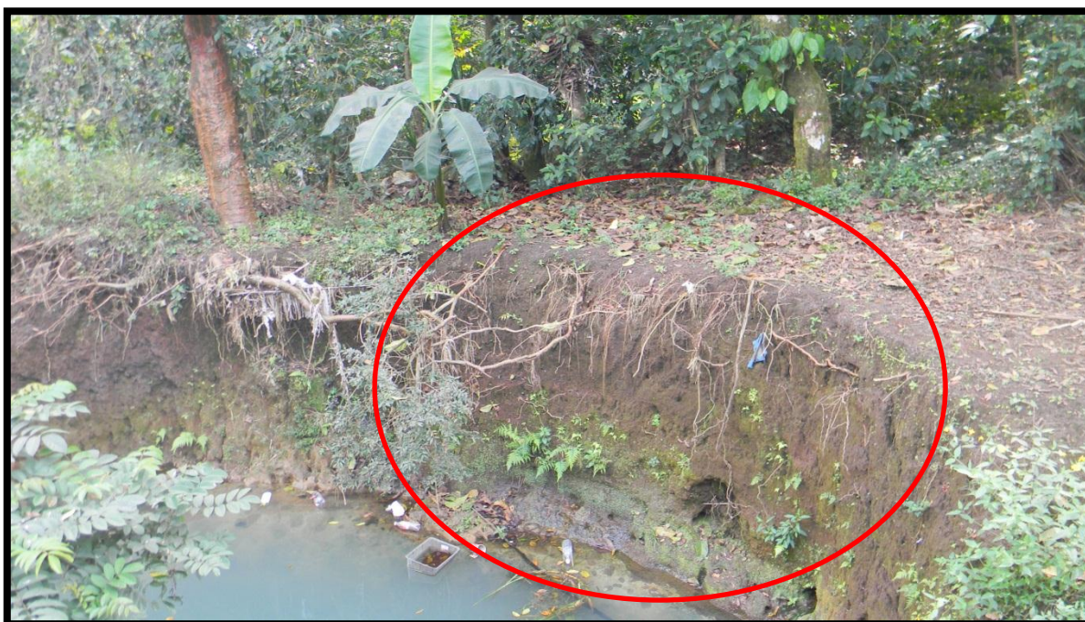
Figura 5.- Erosión Lineal Debido a Canal de Aguas Residuales en la Localidad de Guadalupe (La Patrona), Amatlán de los Reyes.
