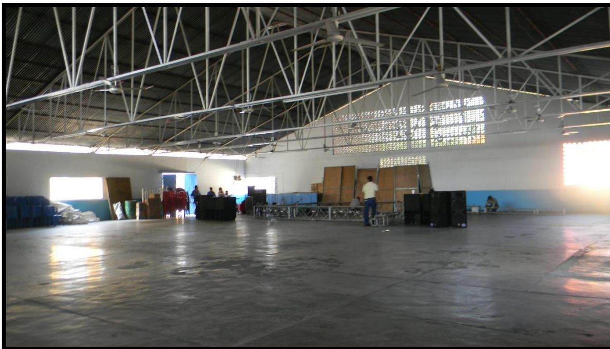
Figura 31.- Refugio Temporal "Salón de Usos Múltiples Amatlán". Capacidad 570 personas.
