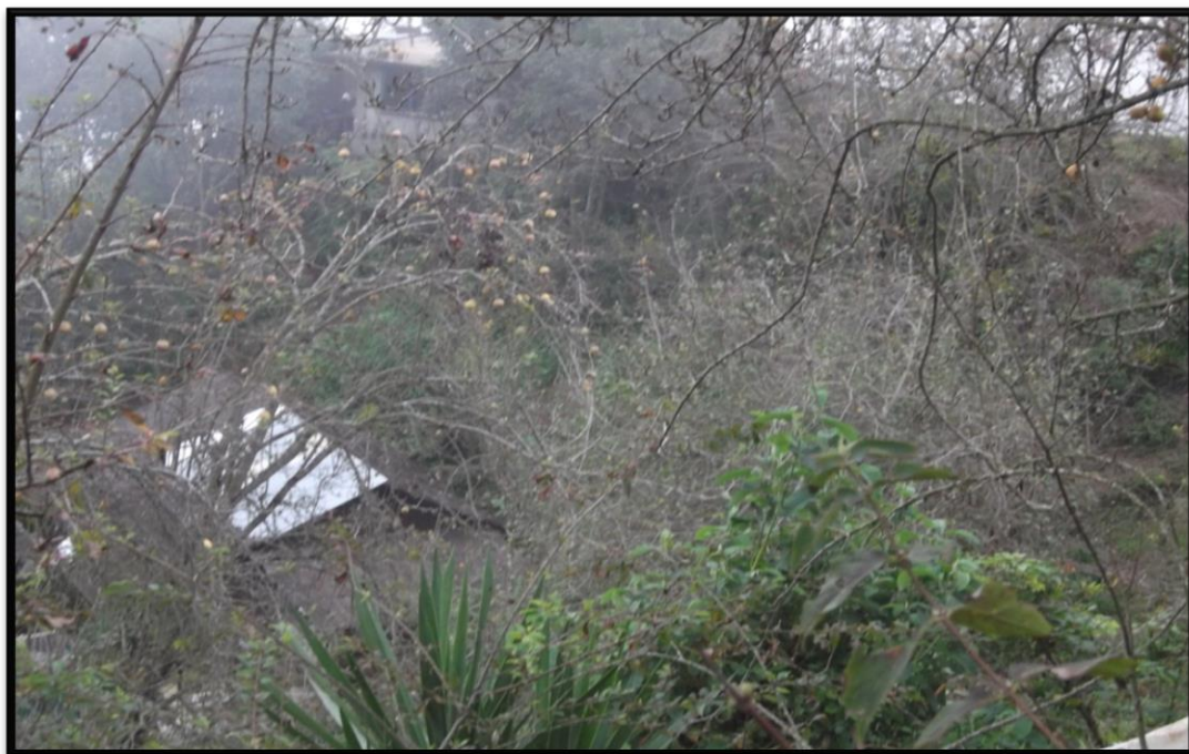
Figura 4.- Deslave de tierra en el tramo vial Calzacayo- El Águila.
