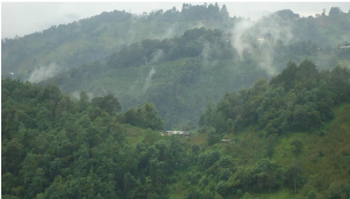
Fotografía 5.4. Casas en un Grado de Riesgo Alto por la Ubicación y el Material del que Están Construidas.
