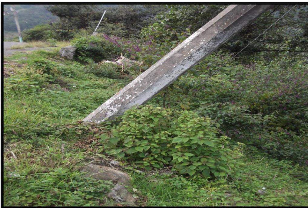
Figura 1.- Deslave en la carretera de Cocaltzingo.
