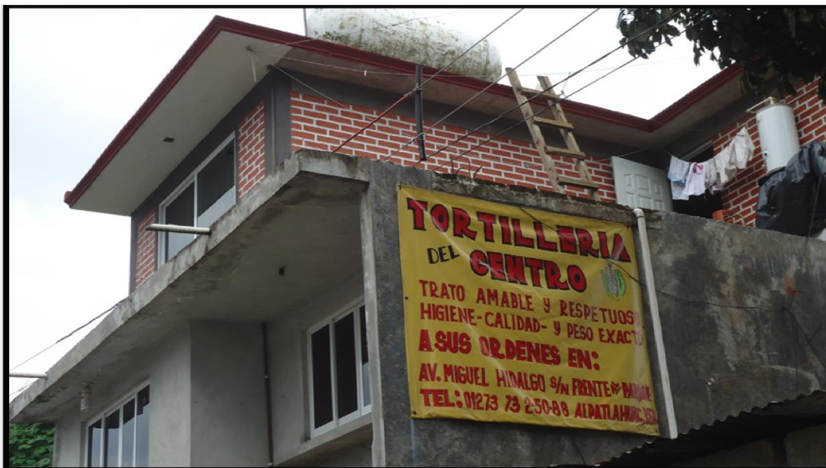
Figura 19.- Tortillería " del centro", con un tanque de 100 lt, instalado en el 2008 en Cabecera Municipal.
