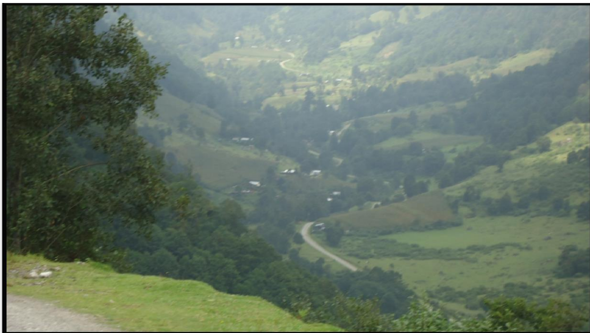
Figura 21.- Viviendas afectadas por vientos fuertes debido a su ubicación en la localidad Calzacayo
