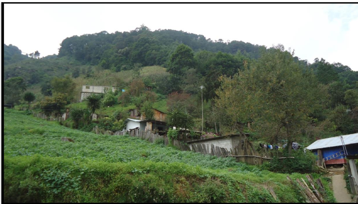
Figura 20.- Viviendas propensas a deslizamientos por estar asentadas en una ladera en la localidad Malacatepec.
