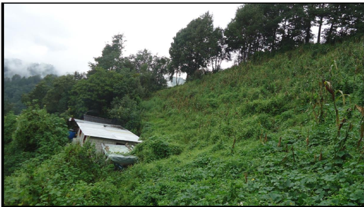
Figura 22.- Vivienda en peligro por estar ubicada en una pendiente en la localidad Calzacayo.
