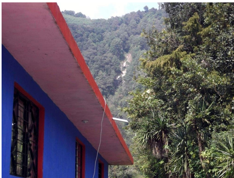
Fotografía 3.2. Deslave y Derrumbe en Calizas con Altas Pendientes, Localidad Ocalzingo.
