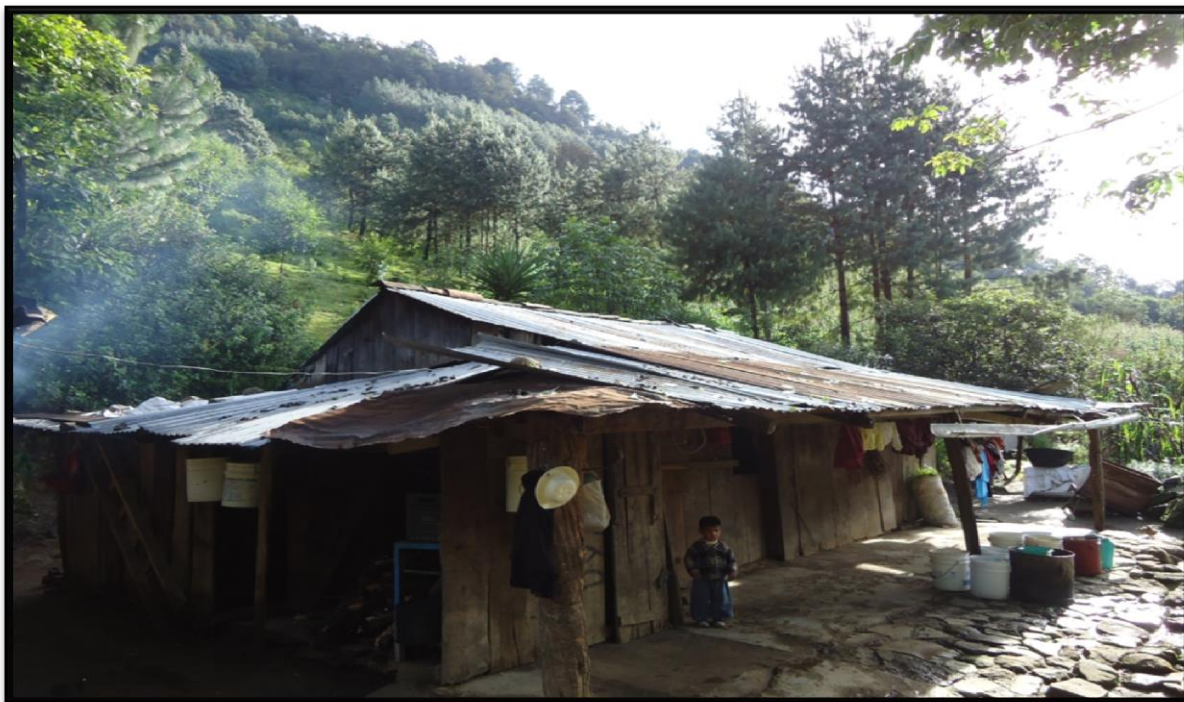
Figura 13.- Vivienda vulnerable a fenómenos meteorológicos como viento, granizo y precipitación. Fuente: Protección Civil Municipal.
