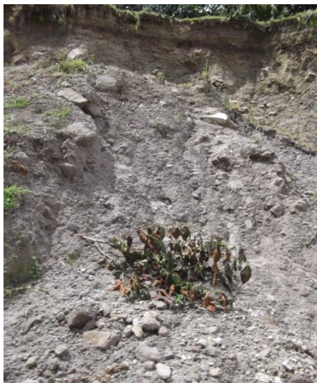
Fotografía 5.3. Erosión hídrica muy alta que provoca movimientos de remoción en masa, localidad de Malacatepec.
