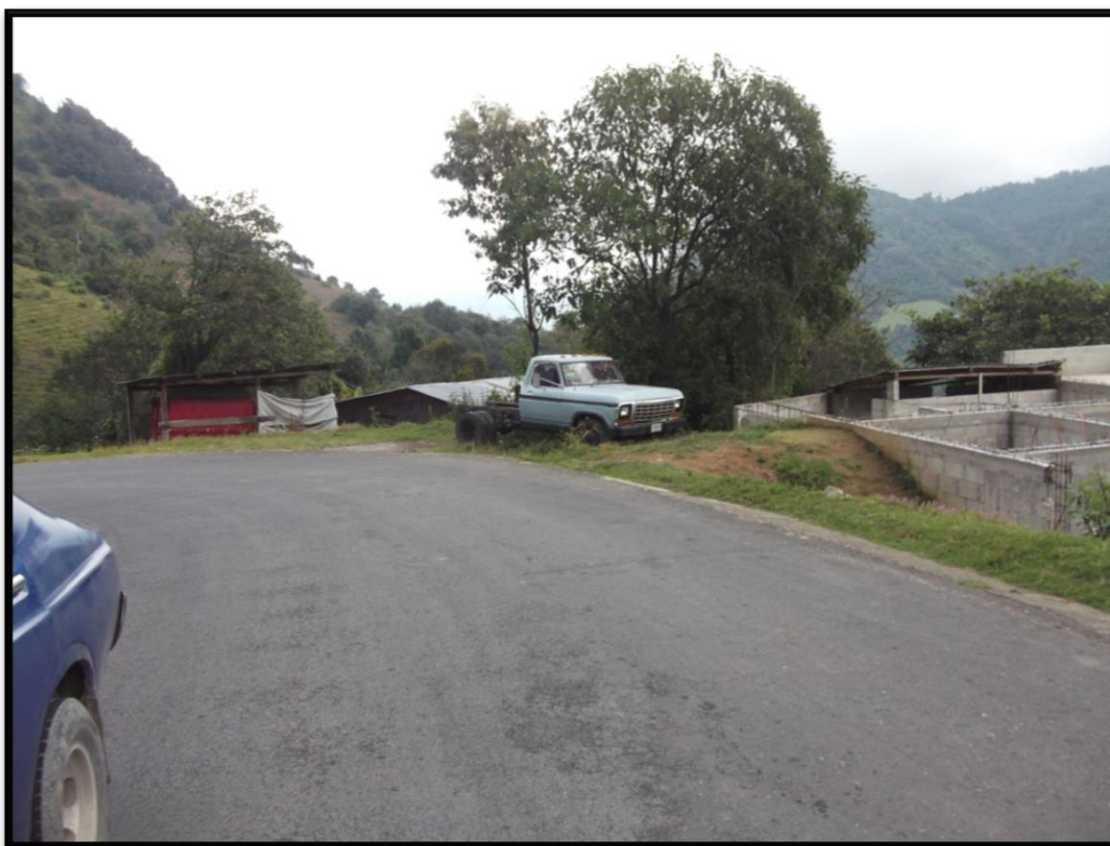
Figura 8.- Vivienda en riesgo por accidente vial en tramo Alpatláhuac- Malacatepec.
