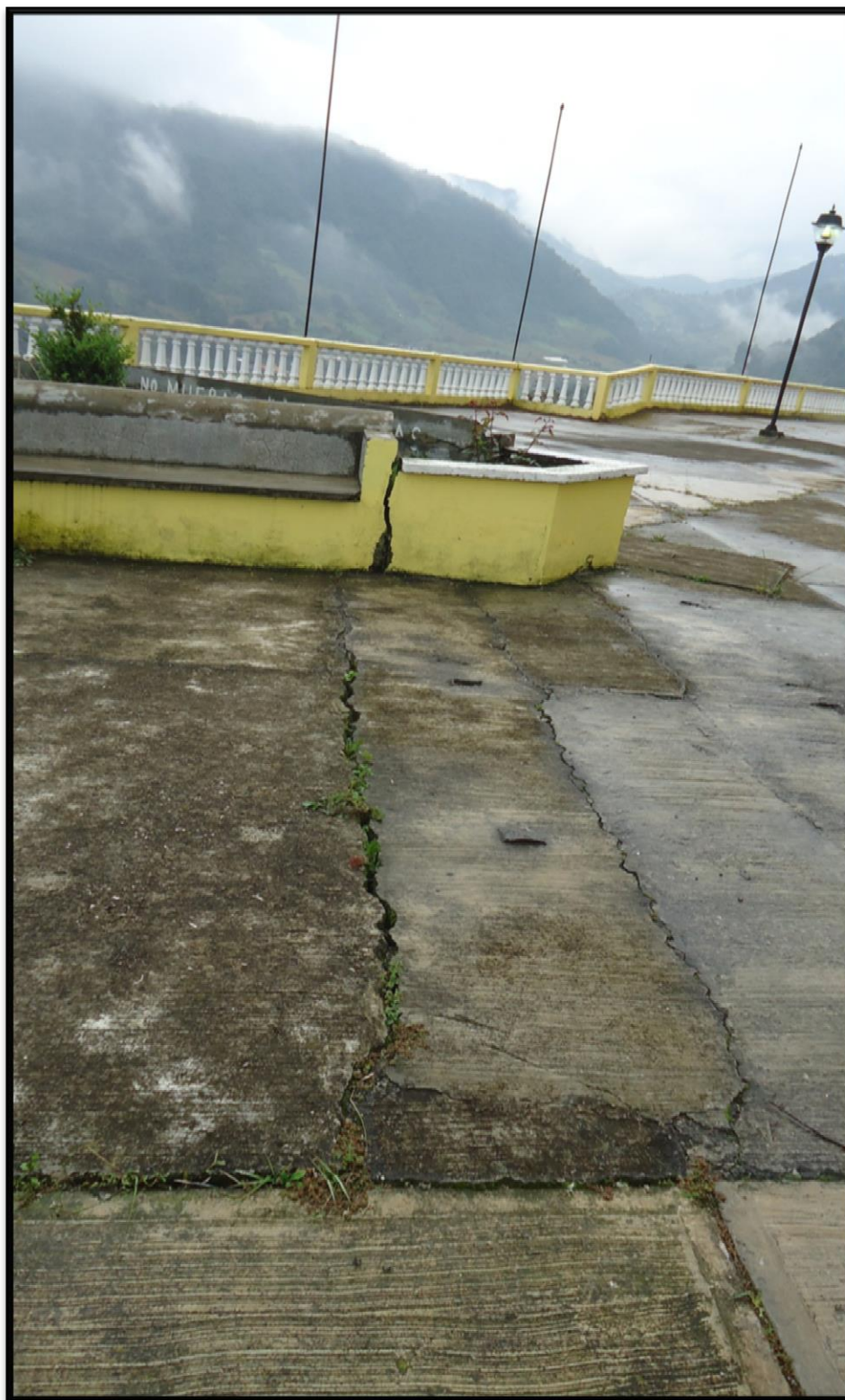
Figura 26.- Iglesia que presenta grietas por deslizamiento del cerro en el que se encuentra asentada en la cabecera municipal
