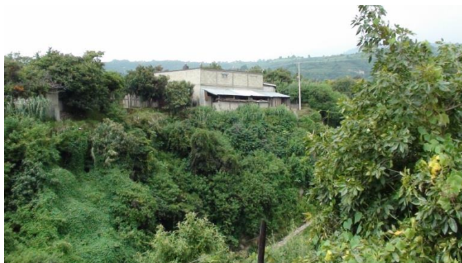
Foto 47. Vivienda ubicada junto a barranca
