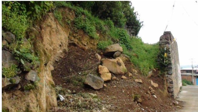
Foto 50. Muros contruidos en La Magdalena Yancuitlalpan para contener el material de las laderas
