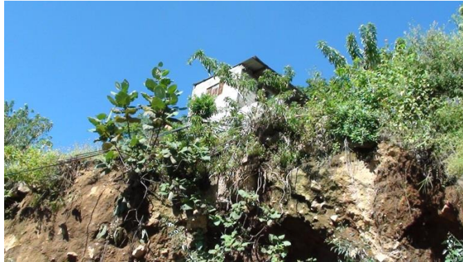
Foto 49. Vivienda de La Magdalena Yancuitlalpan ubicada en talud
