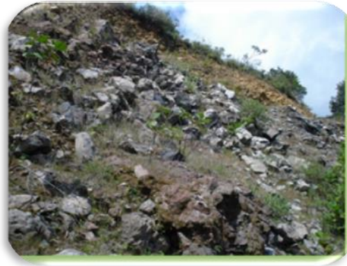
Foto 11. Derrumbe en la zona sur oriente del municipio de Tochimilco (recorrido en campo 17/09/2011).
