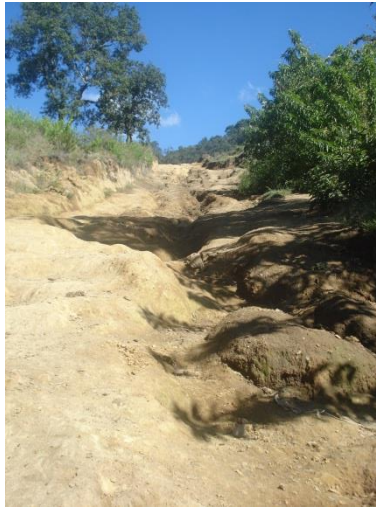
Foto 73. Erosión en La Magdalena
