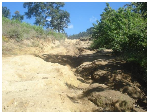
Foto 74. Erosión en La Magdalena
