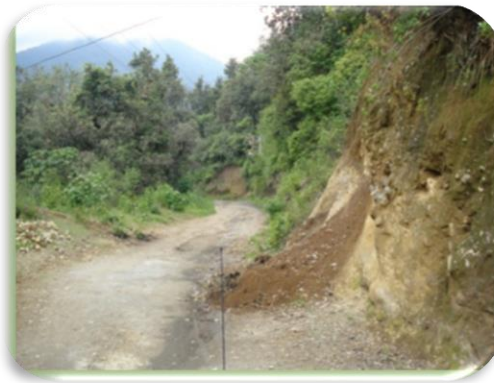
Foto 12. Derrumbe al sur poniente del municipio de Tochimilco.
