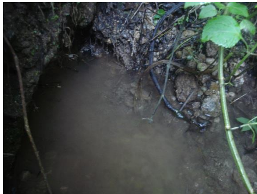
Foto 66. Posibles salida de flujos de lodo y escombros
