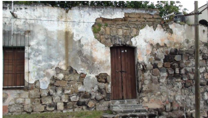
Foto 38. Casa dañada por sismo en Tochimilco
