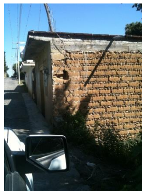
Foto 39. Casa dañada por sismo en Tochimilco
