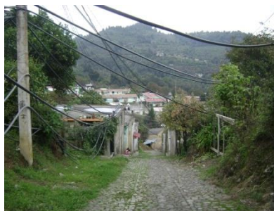
Foto 20. Agua entubada en la localidad de Santa Cruz Cuautomatitla (recorrido en campo 17/09/2011).
