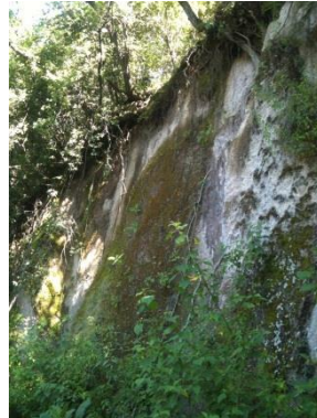
Foto 61. Talud de rocas ígneas
