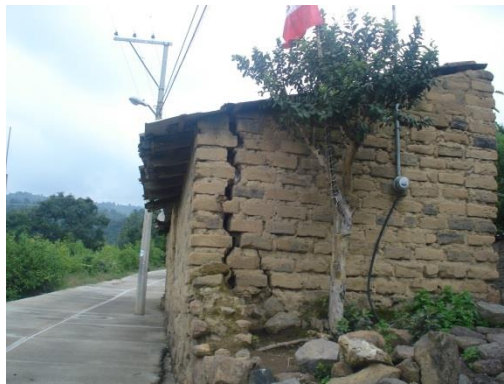
Foto 32. Vivienda en La Magdalena Yancuitalpan vulnerable
