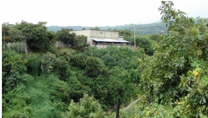
Foto 47. Vivienda ubicada junto a barranca
