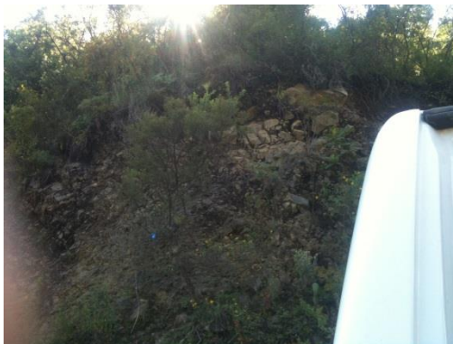
Foto 64. Talud con pérdida de vegetación
