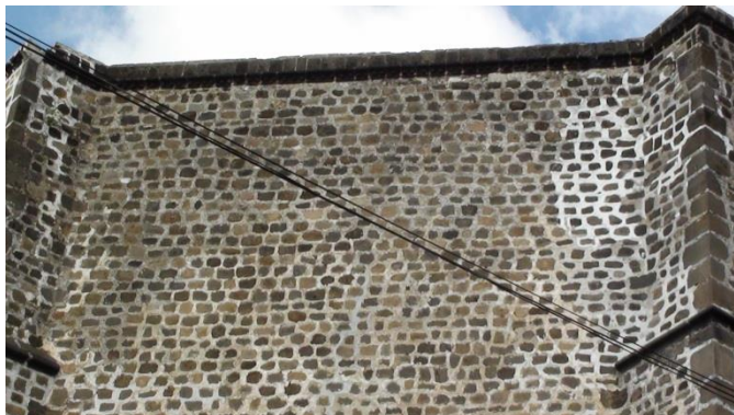
Foto 41. Ex-Convento dañado en su zona lateral
