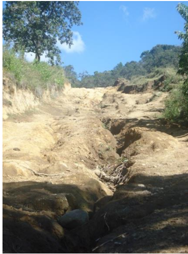
Foto 70. Erosión en La Magdalena
