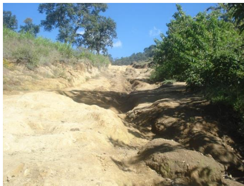
Foto 74. Erosión en La Magdalena
