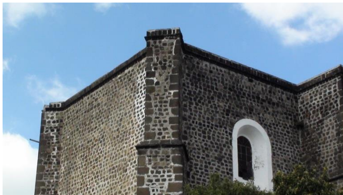
Foto 40. Ex-Convento dañado en su zona lateral
