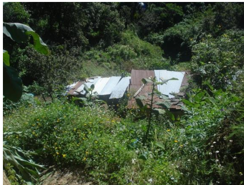
Foto 51. Vivienda con techo de lámina ubicada en barranca
