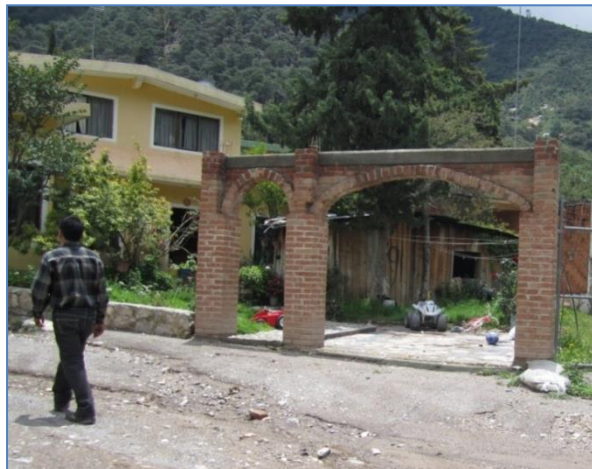
Imagen No 11. Vivienda de muro de mampostería y techo de concreto y al lado una construcción de madera con techo de lámina
