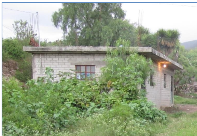
Imagen No 12. Vivienda de muro de block y techo de concreto.
