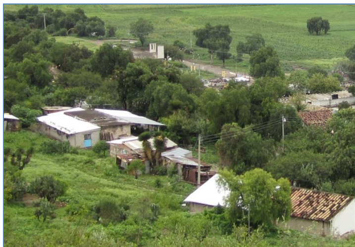
Imagen No 10. Tipología de vivienda predominante con muros de mampostería y Techo de lámina y/o concreto en la inspección del Carmen.
