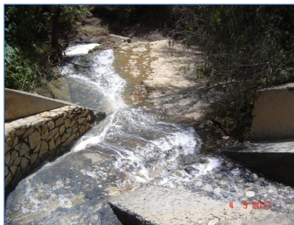
Imagen No 32. Descarga de aguas residuales de la cabecera municipal.
