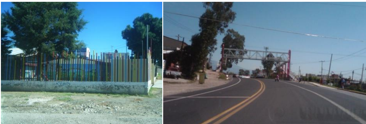
ILUSTRACIÓN 11. PROBLEMAS PARA LA CIRCULACIÓN PEATONAL: CARENCIA DE BANQUETAS, ASÍ COMO PUENTES PEATONALES EN DESUSO.
