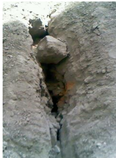
ILUSTRACIÓN 16. FRACTURAS POR DESECACIÓN EN LA CALLE COLORINES
