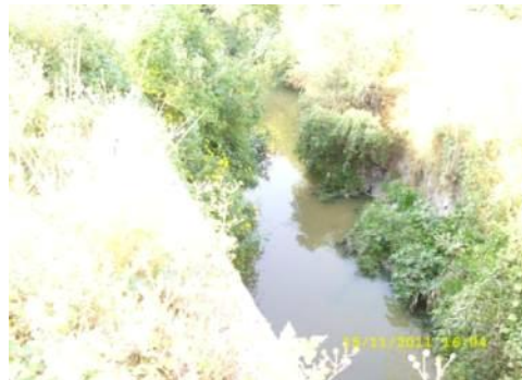
ILUSTRACIÓN 15. FRACTURA ESTRUCTURAL EL ZAPATERO
