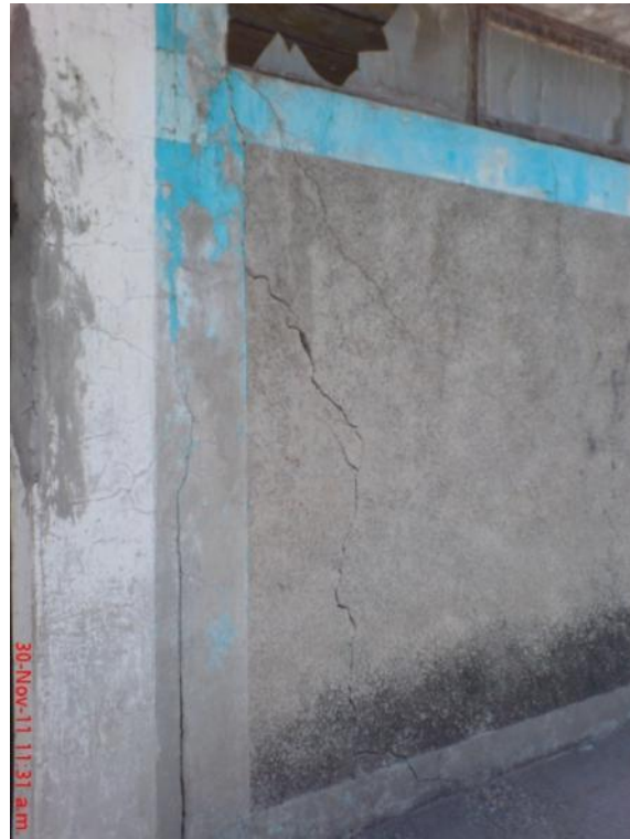
ILUSTRACIÓN 24. FRACTURA ESTRUCTURAL ZAPATERO Y FRACTURA POR DESECACIÓN EN LA CALLE COLORINES NO. 6.
