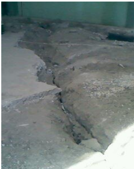
ILUSTRACIÓN 16. FRACTURAS POR DESECACIÓN EN LA CALLE COLORINES
