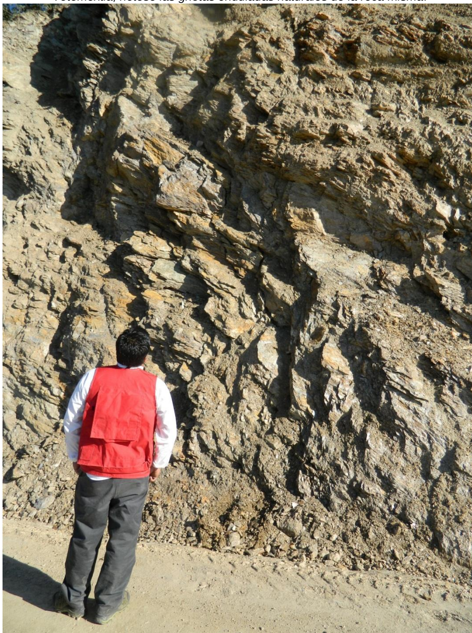
Figura 25. Fotografía de un talud en las afueras del pueblo de San Juan Quiotepec con dirección a Santa María Totomoxtlá, nótese las grietas onduladas naturales de la roca misma.
