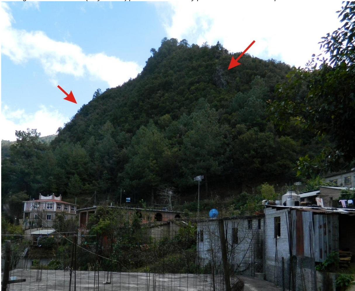
Figura 26. Fotografía de la ladera suroriental de San Juan Quiotepec (detrás del panteón) en donde se observan crestones de rocas (señalados por las flechas rojas) que afloran por encima de la cobertura de bosque. Estos crestones son de esquisto, fisurado y alterado por los agentes meteorizantes, por lo que en caso de presentarse un sismo de magnitud considerable (mayor a 5.5) pueden movilizarse y producir una caída o desprendimiento de rocas.
