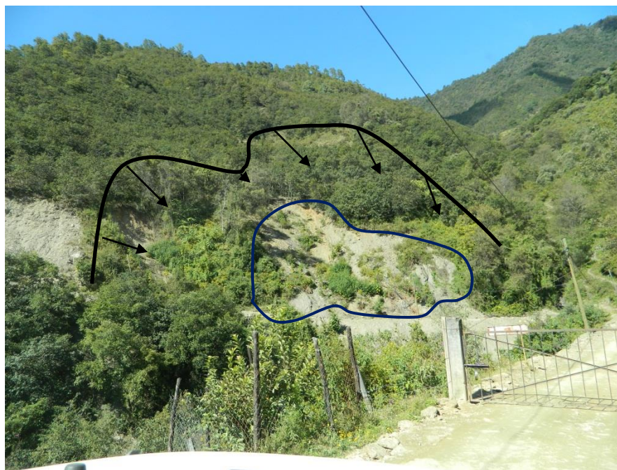
Figura 51. Se muestra un deslizamiento translacional que afecto el camino hacia Municipio de San Juan Quiotepec.
