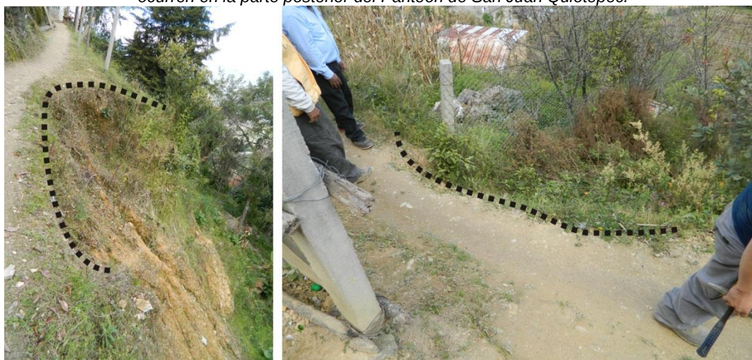
Figura 33. Pequeños deslizamientos complejos. Inician como un deslizamiento rotacional y terminan como un flujo, en donde se depósito viaja a una mayor distancia (en relación con el tamaño de su corona –línea discontinua). Ambas fotos ocurren en la parte posterior del Panteón de San Juan Quiotepec.
