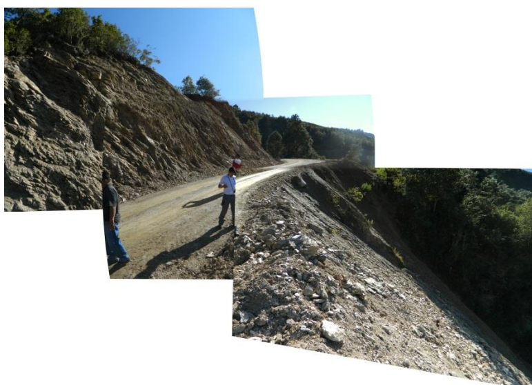
Figura 52. Camino rehabilitado para el cruce de vehículos del Municipio de San Juan Quiotepec hacia Santa María Totomoxtla..
