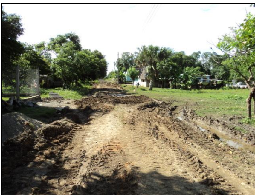
Fotografía 29. Estado que guardan las calles posterior a las inundaciones.
