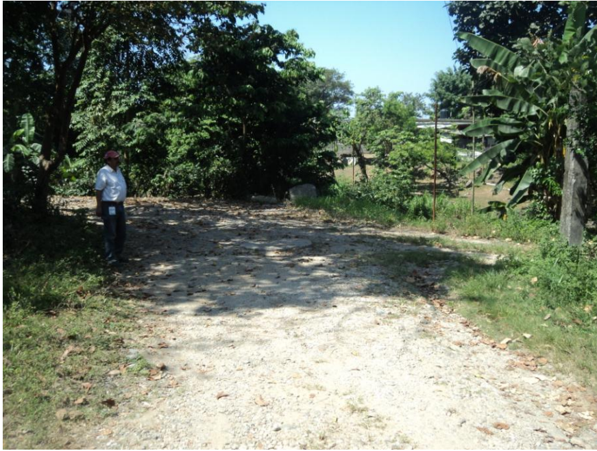
Fotografía No. 11. Estado en que se encuentra la Calle 15 de Septiembre la cual se inunda entre 0.25 y 0.40 m.
