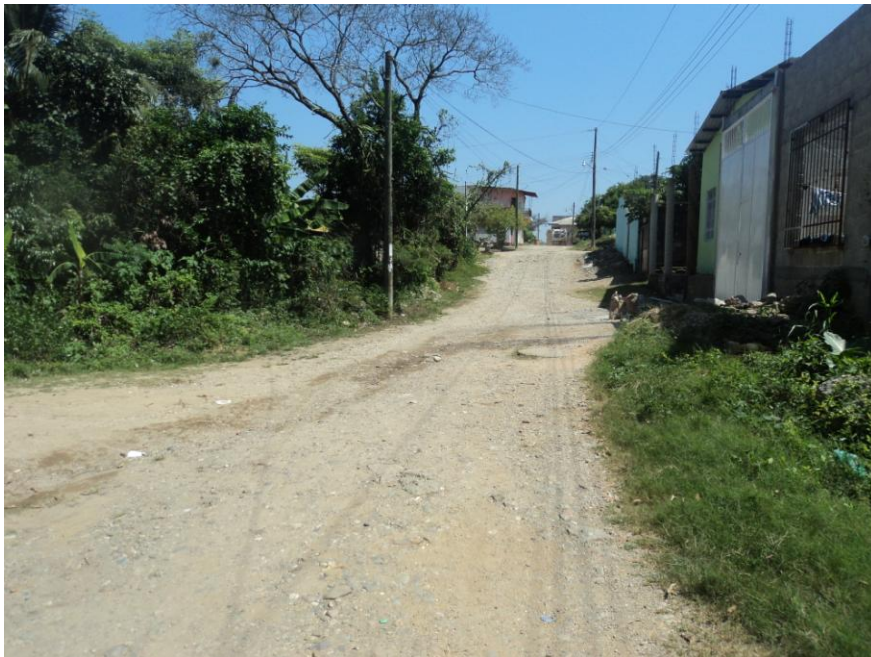
Fotografía No. 12. En la Calle 5 de Febrero y Brena Torres se observa la diferencia de elevación que puede influir en que una zona se inunde o no (nótese la pendiente del terreno).
