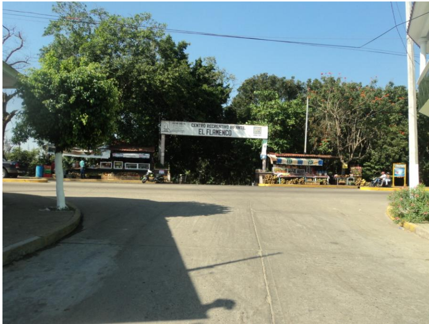
Fotografía No. 8. Sobre la Calle Morelos Esq. Muro Boulevard se tienen una diferencia de elevación de aproximadamente 1.1 m lo que limita la movilidad del agua pluvial.
