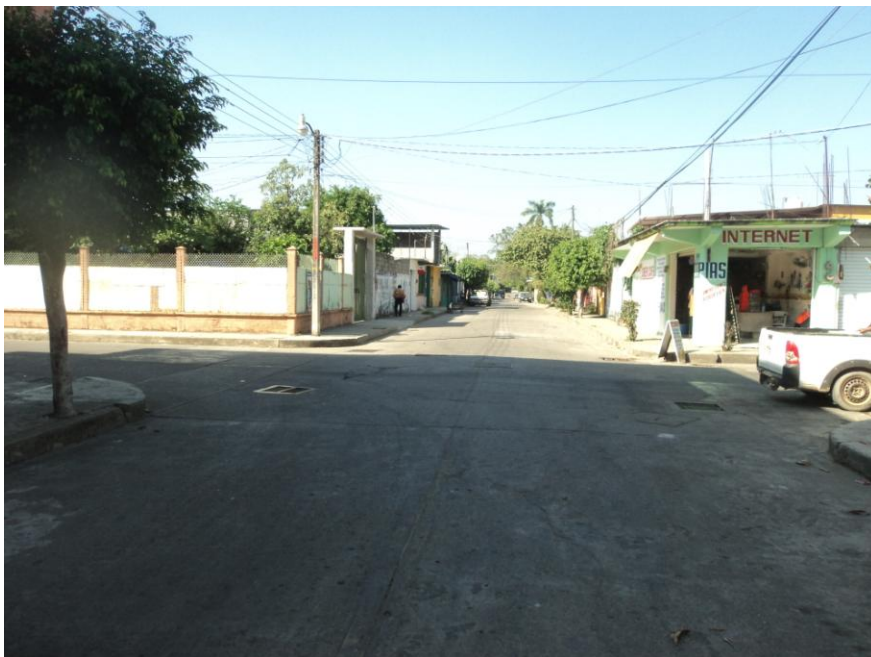
Fotografía No. 10. Sobre la Av. Buenfil, Esq. Morelos se tienen inundación por encharcamiento de entre 0.70 y 1.05 m.
