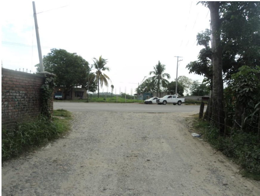
Fotografía No. 1. En esta fotografía se observa el desnivel, aunque mínimo; de aproximadamente 0.40 m del nivel de la Av. 2 de Septiembre con respecto a la elevación de la Calle Aurelia Rangel.
