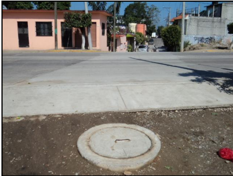
Fotografía 34. Realización de obras hidráulicas sobre el muro Boulevard.
