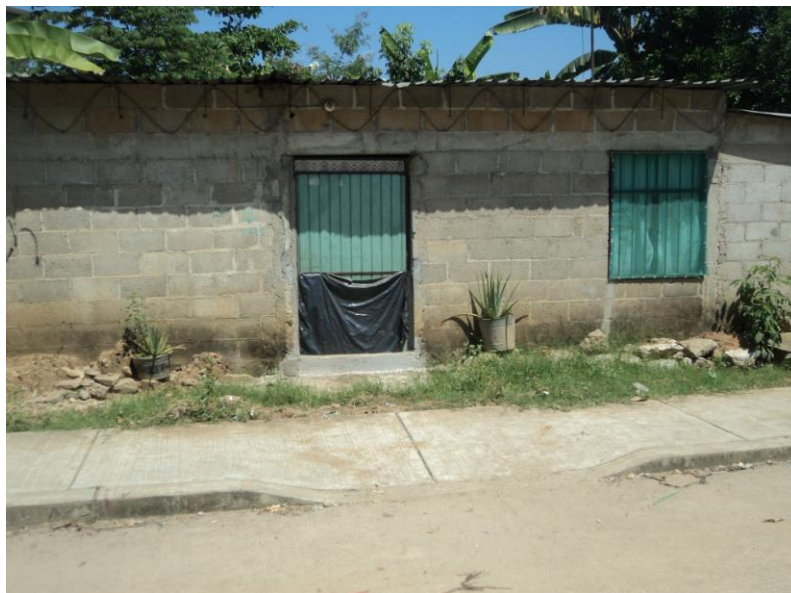
Fotografía No. 13. Sobre la Calle Sauce Esq. Encinal el nivel de inundación es de 0.50 m (obsérvese las manchas de humedad sobre la pared de la vivienda).
