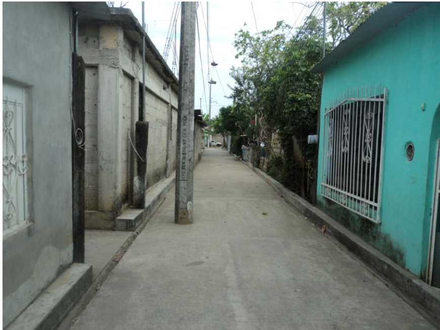
Fotografía No. 2. En la parte sur de la Colonia Víctor B. Ahuja se ubica la Calle 3 de Mayo la cual sufre problemas por encharcamiento con un incremento del nivel del agua de 0.30 m.
