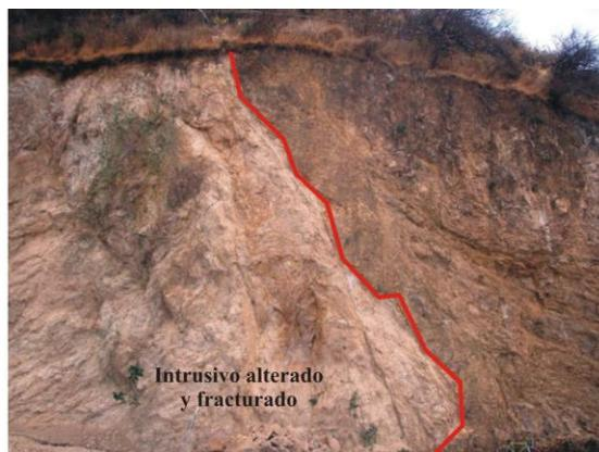
Figura 5.3.12. Afloramiento de la roca granítica alterada sobre el trazo de la carretera del cerro El Fortín. La fotografía de la derecha es un acercamiento del mismo punto.
