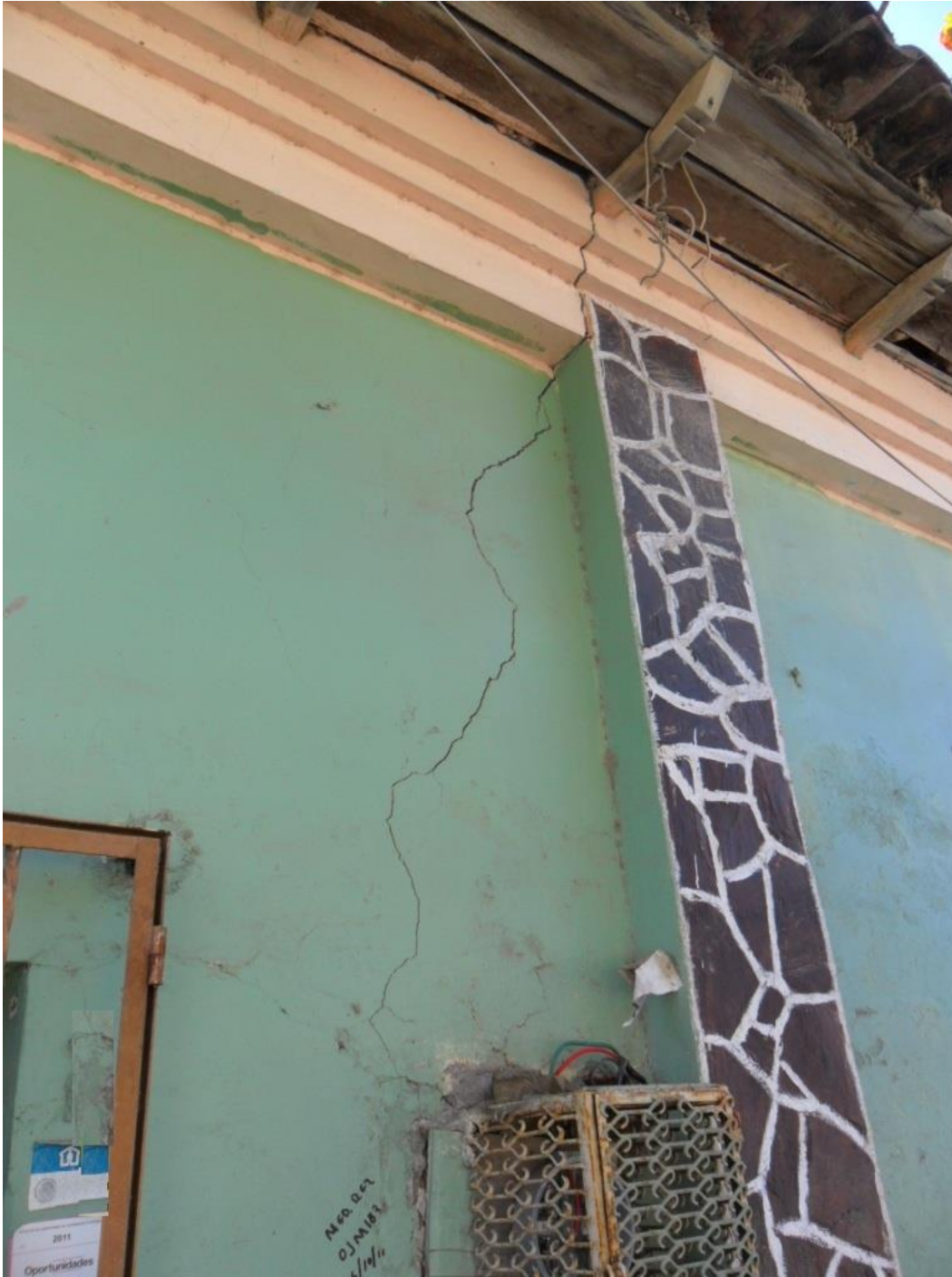
Imagen 2. Evidencia sísmica. Fractura transversal en vivienda en la localidad de Álvaro Obregón, Municipio de Heroica Ciudad Juchitán de Zaragoza, Oaxaca.
