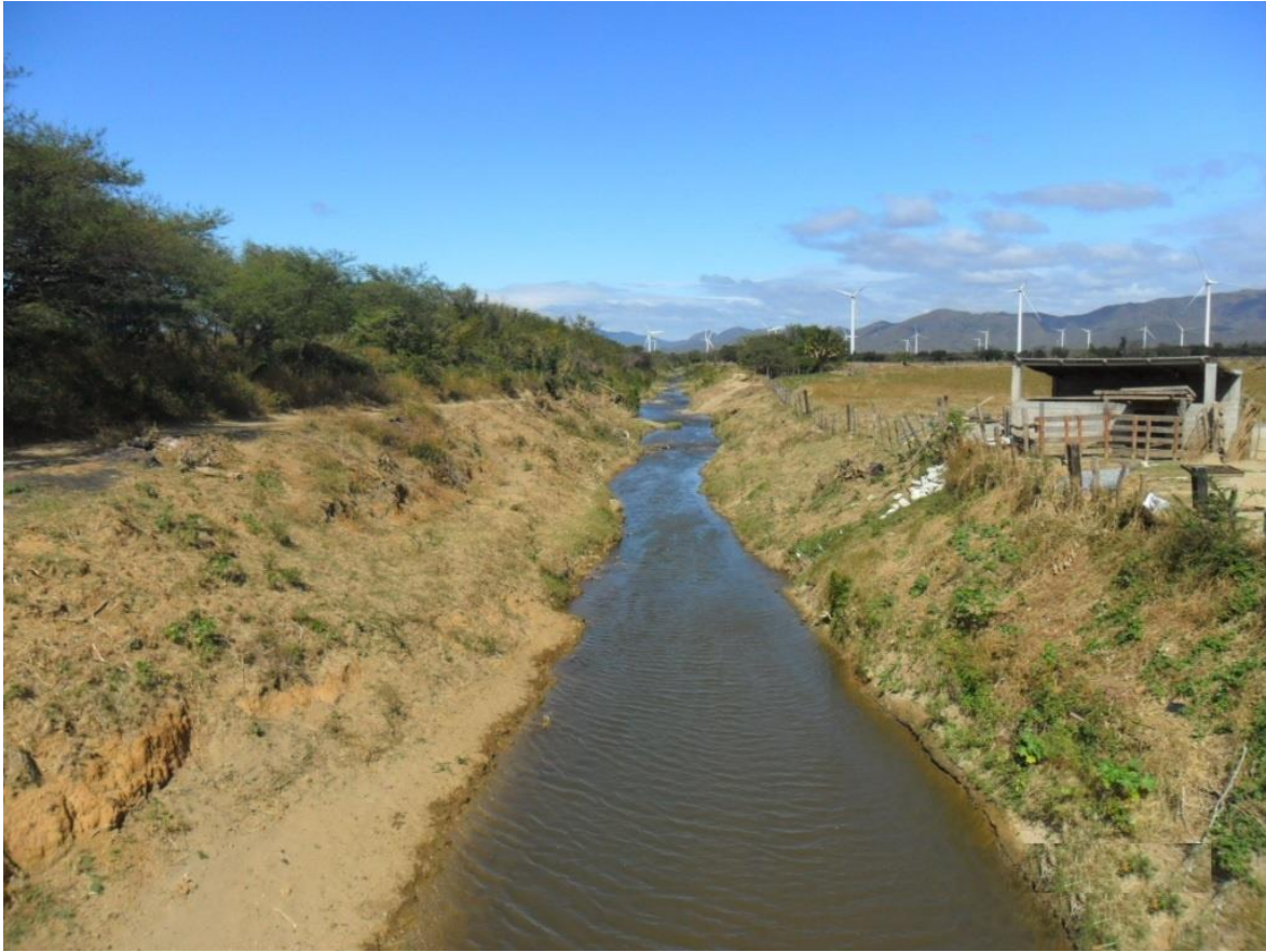
Imagen 3. Canal de riego. Municipio de Heroica Ciudad Juchitán de Zaragoza, Oaxaca.
