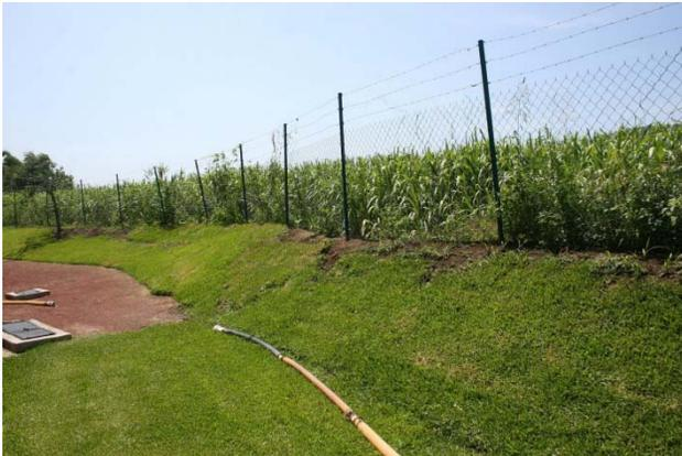
Foto VI.7.15 Bordo de contención contra inundaciones en el Balneario Las Estacas.
