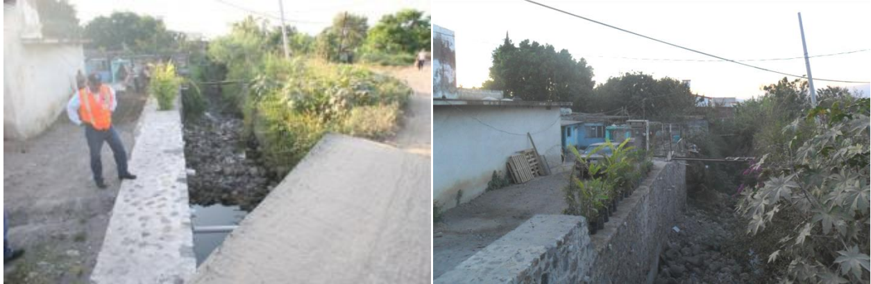
Figura 41. Canal (arroyo Xochimelcancingo) de alto poder de socavación en las calles 3 de noviembre y Camino a la Antigua Vía (o del FC Interoceánico)
