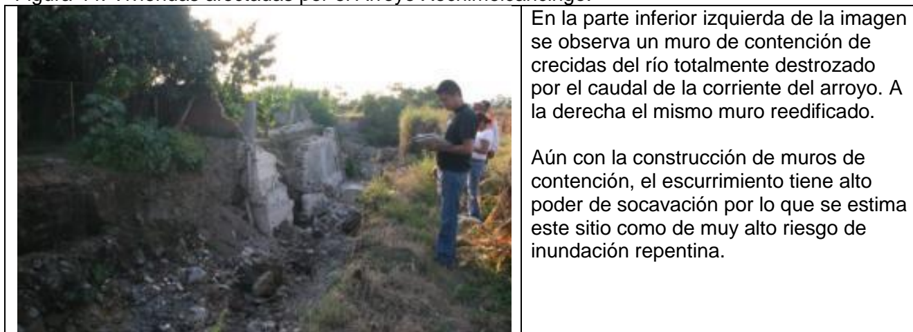
Figura 44. Viviendas afectadas por el Arroyo Xochimelcancingo.
