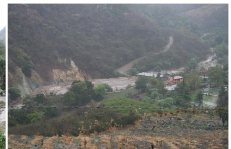
Ilustración 30.- Vista general del crecimiento del cauce del río y afectación a infraestructura cercana.
