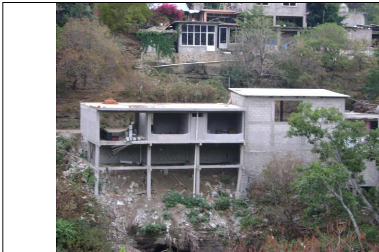
Ilustración 4.- Casa en zona de riesgo en el municipio de Jungapeo. Fuente: Programa municipal de desarrollo urbano Jungapeo, Michoacán 2010-2030
