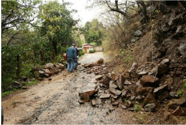
Ilustración 15.- Limpieza del derrumbe camino a Las Anonas.
