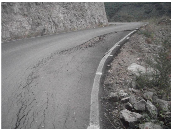
Ilustración 36.- Izquierda, hundimiento sobre la carretera de 15m de largo y 0.20m de hundimiento. Derecha, detalle.
