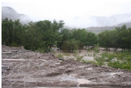
Ilustración 28.- Reblandecimiento de terreno por lluvia.
