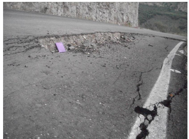
Ilustración 36.- Izquierda, hundimiento sobre la carretera de 15m de largo y 0.20m de hundimiento. Derecha, detalle.
