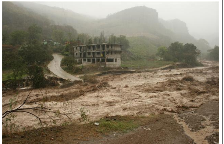
Ilustración 2.- Puente que comunica con la localidad de las Anonas. Fuente: Javier Esquivel
