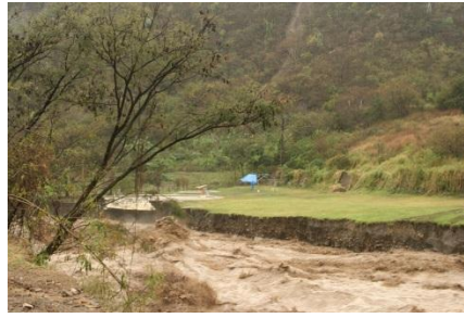
Ilustración 32.- Desgajamiento de terreno a causa del flujo de agua del río.
