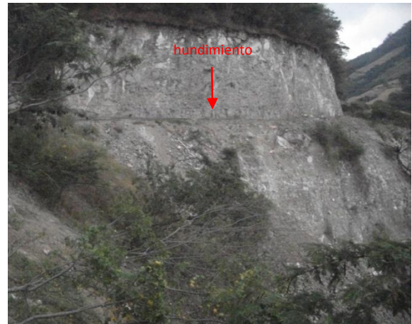
Ilustración 35.- Escarpe de aproximadamente 100m de alto.
