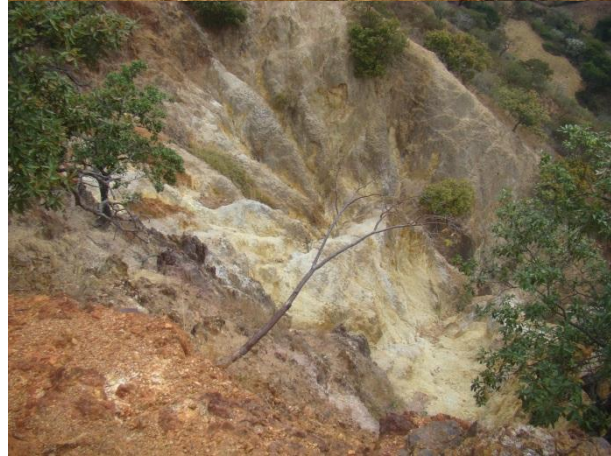
Ilustración 16.- Evidencia de deslizamiento: inclinación de árboles en ladera.
