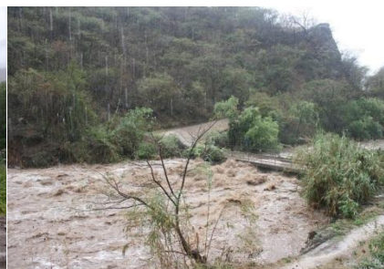
Ilustración 29.- Cauce del río a nivel del puente de Zumbaro, generador de un "cuello de botella".
