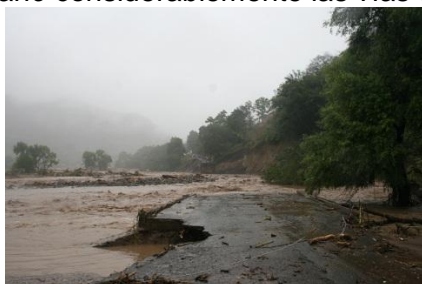
Ilustración 23.- Daño en carretera.
