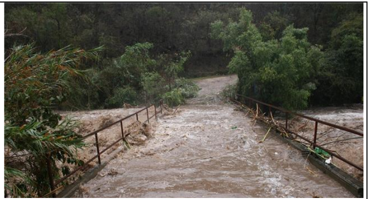
Ilustración 1.- Puente que comunica con la localidad de las Anonas. Fuente: Javier Esquivel
