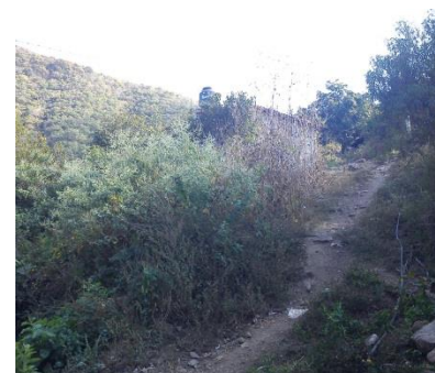
Foto 26. Compactación en B. Juárez. Fuente: A+I Construcciones S.A. de C.V.
