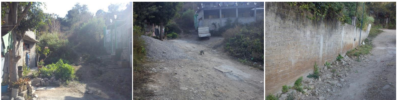
Foto 17. Flujos del cerro La Cruz, causados por precipitaciones. Fuente: A+I Construcciones S.A. de C.V.
