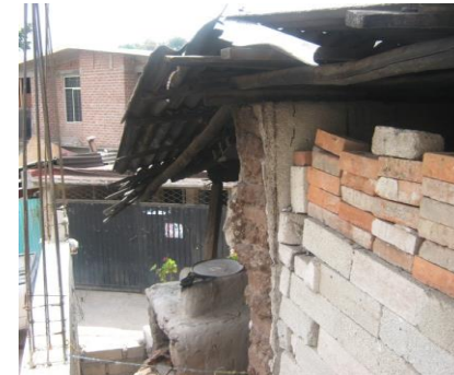
Foto 28. Daños en vivienda por ventarrones en la localidad de Timbuscatío. Fuente: A+I Construcciones S.A. de C.V.
