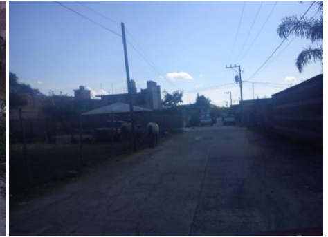
Foto 21. Deterioro en pavimentos provocados por cambios en el comportamiento del suelo, además de la inclinación y hundimiento de los postes. Fuente: A+I Construcciones S.A. de C.V.
