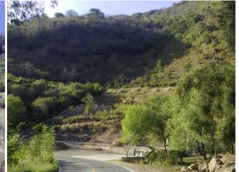
Foto 8. Formación de pequeñas terrazas y acumulación de rocas al pie de las superficies afectadas por deslizamiento, sobre la carretera federal 51 en su paso por Guanoro. Fuente: A+I Construcciones S.A. de C.V.
