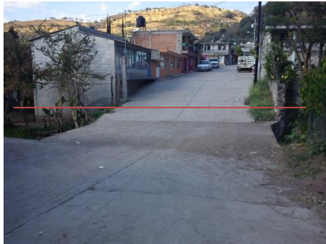
Foto 32. Paso del río La Caldera por la cabecera municipal, indicando el nivel alcanzado en episodios de inundaciones anteriores.
