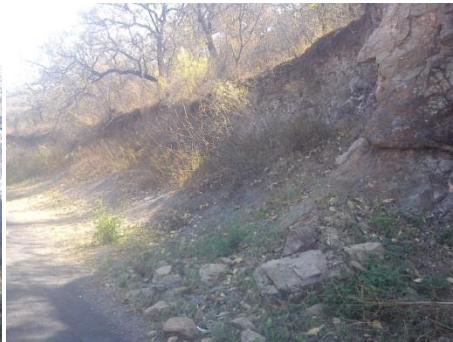
Foto 11. Derrumbe a pie de la carretera Tuzantla-Timbuscatío principalmente en temporada de lluvias, observándose fisuras en el escarpe. Fuente: A+I Construcciones S.A. de C.V.
