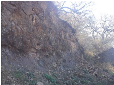
Foto 11. Derrumbe a pie de la carretera Tuzantla-Timbuscatío principalmente en temporada de lluvias, observándose fisuras en el escarpe. Fuente: A+I Construcciones S.A. de C.V.
