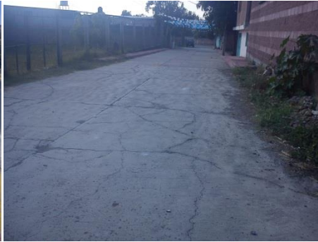
Foto 21. Deterioro en pavimentos provocados por cambios en el comportamiento del suelo, además de la inclinación y hundimiento de los postes. Fuente: A+I Construcciones S.A. de C.V.
