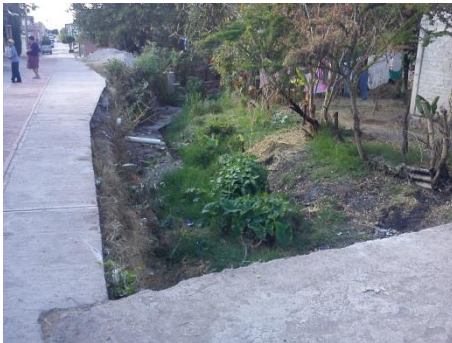
Foto 1. Descarga de drenaje en arroyo del centro de Benito Juárez. Fuente: A+I Construcciones S.A. de C.V.
