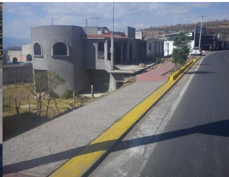
Foto 21. Las Charcas, emplazada sobre un hundimiento al sur de Benito Juárez. Fuente: A+I Construcciones S.A. de C.V.
