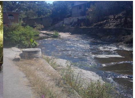
Foto 3. Descarga de drenaje en la localidad de Timbuscatío. Fuente: A+I Construcciones S.A. de C.V.
