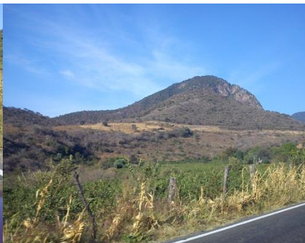
Foto 24. Hundimiento en terrenos que se encuentran en los costados de la carretera, presentando pastizales verdes sin ser temporada de lluvias, indicando la influencia de aguas freáticas en la superficie. Fuente: A+I Construcciones S.A. de C.V.
