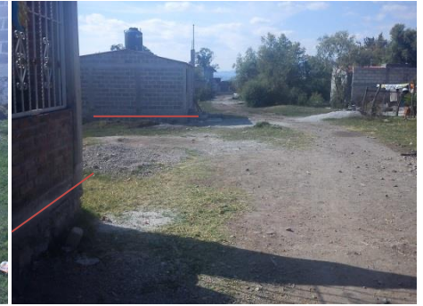
Foto 31. Nivel alcanzado por el agua en zona de viviendas habitadas en Las Charcas.
