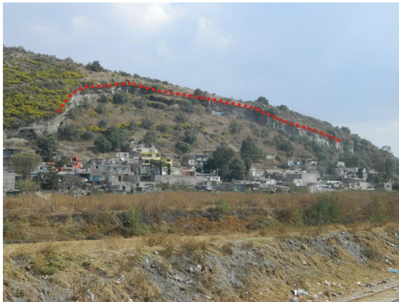
Figura 27. Deslizamiento translacional (corona de desprendimiento –línea discontinua) en las laderas del Cerro de Xico.
