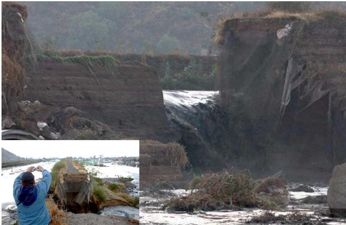
Figura 45. Imágenes del rompimiento en Canal La Compañía 2010
