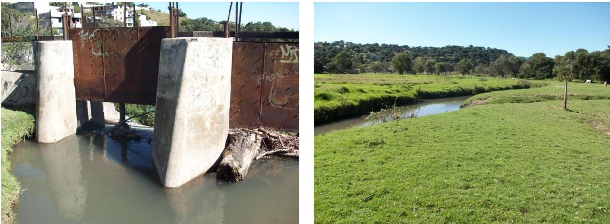
Fig. 5.16 Dos aspectos de la Presa La Colmena en donde se observa que la cortina de la presa y el nivel del fondo de la presa están a pocos centímetros de diferencia, salvo por la formación de un pequeño arroyo dentro de los terrenos azolvados.
