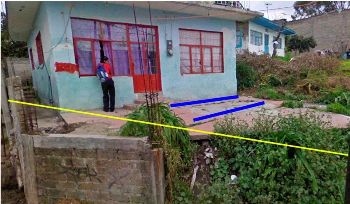
Figura 5.3. Expresión de una fractura geológica (línea amarilla) sobre la calle Guadalupe Victoria, se observan grietas en el piso de una vivienda (líneas azules).
