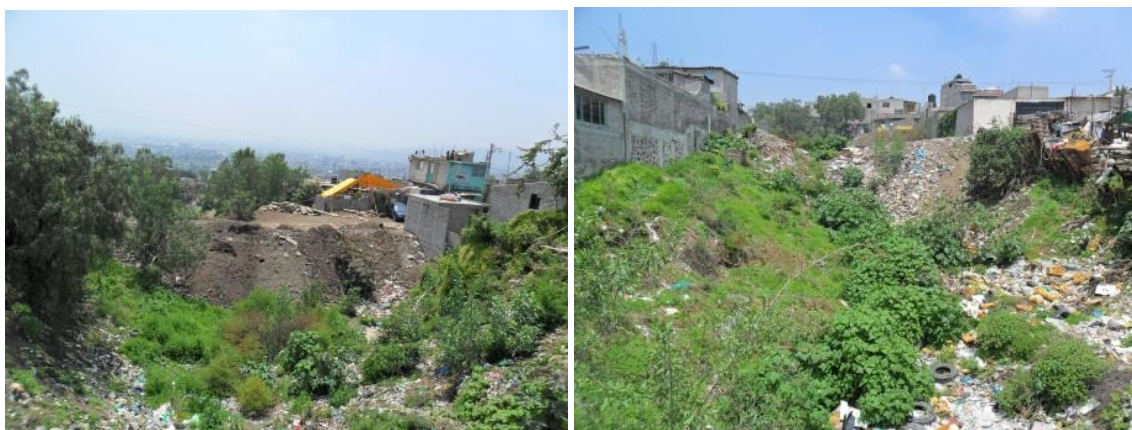
Figura 44. Barranca ubicada en la calle del Rosal
