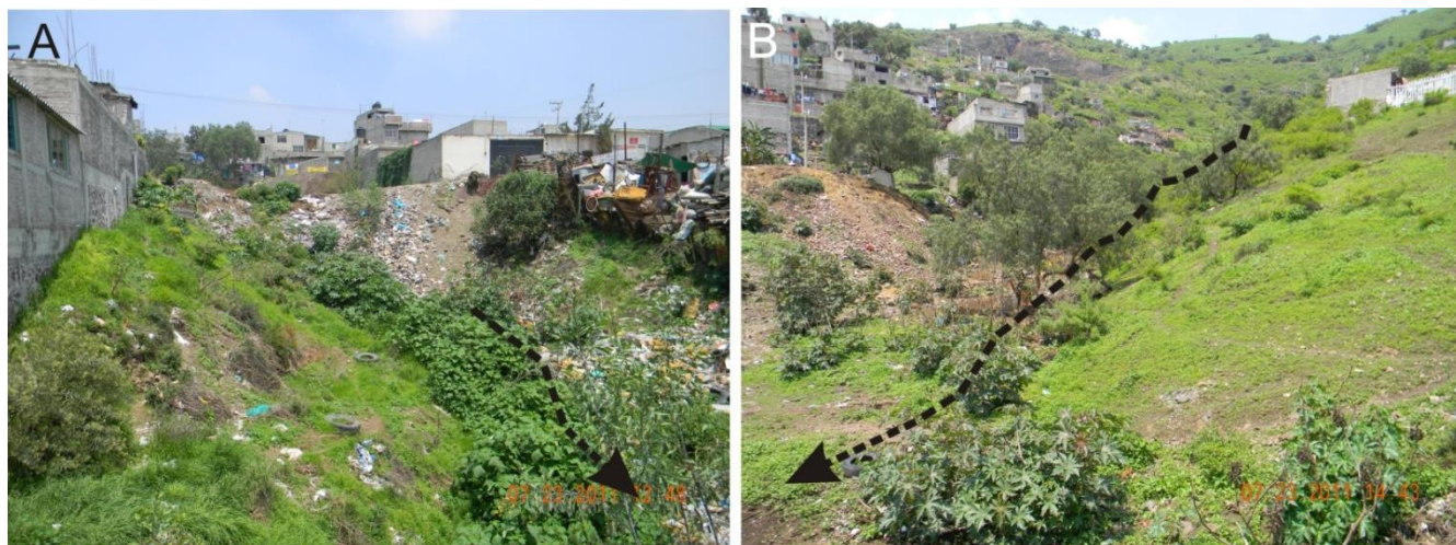
Figura 31. Fotografía en donde se muestra el relleno de un cauce para el emplazamiento de un camino. 3B. Fotografía en donde se observa la urbanización casi por completo de una ladera del pequeño cauce
