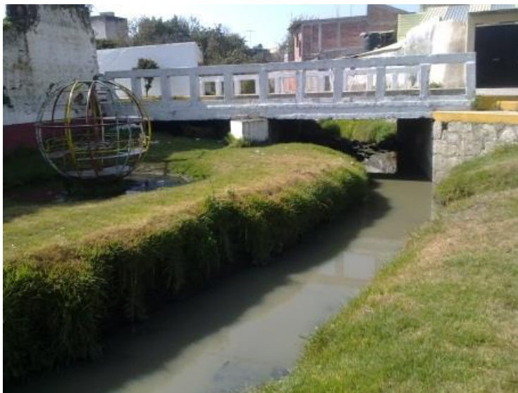
Figura 53. Puente 'invadido' en su sección hidráulica. Calle Ocampo.
