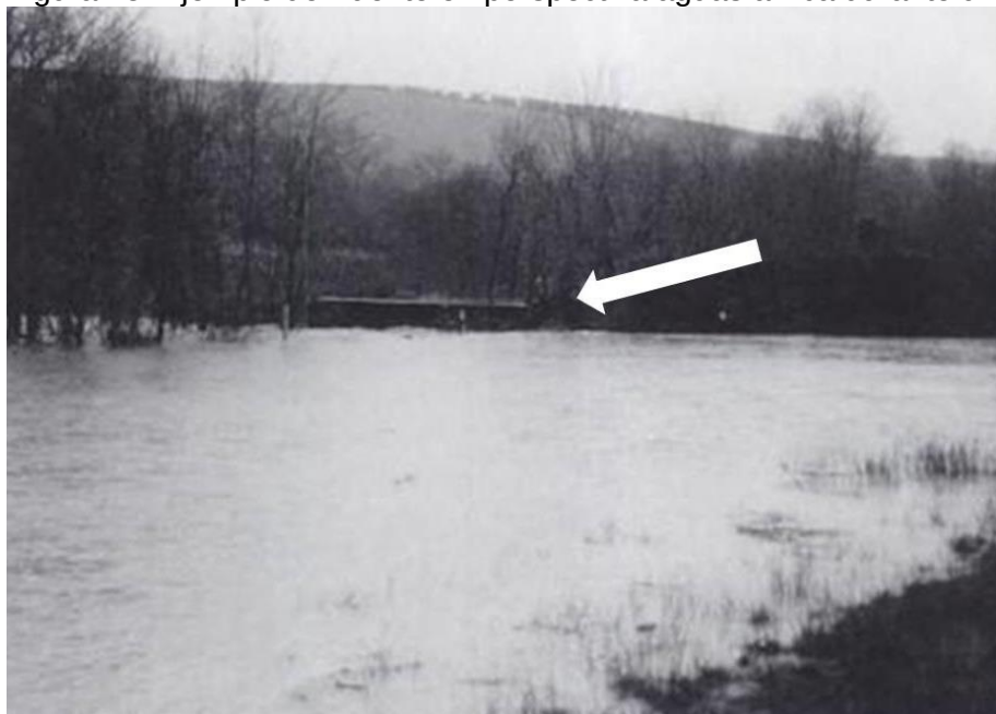
Figura 45. Ejemplo de Puente en perspectiva aguas arriba durante una inundación atípica.
