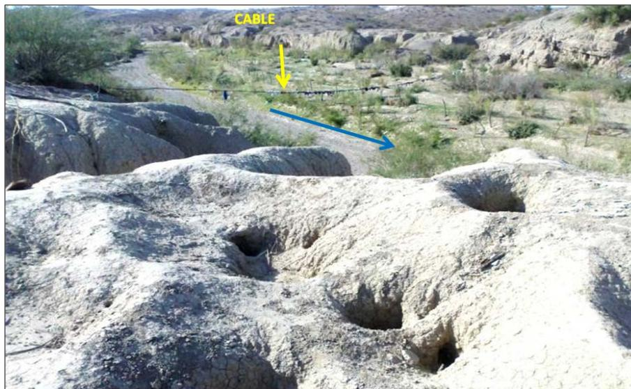
Foto 5.1.7.(1) Cable sobre Arroyo La Zanja margen derecha con erosión hídrica
