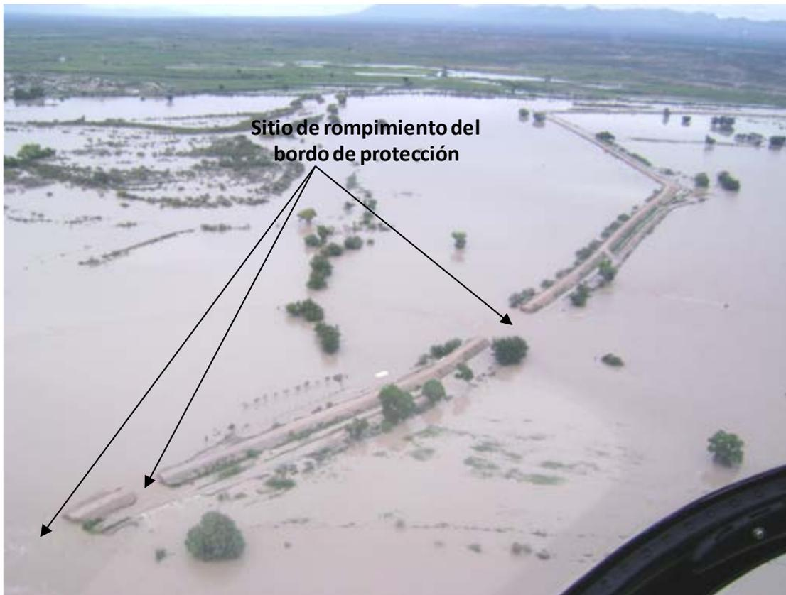
Foto 5.6.1.1.(1).-Sitios de rompimiento del bordo de protección en la margen derecha del Río Conchos
