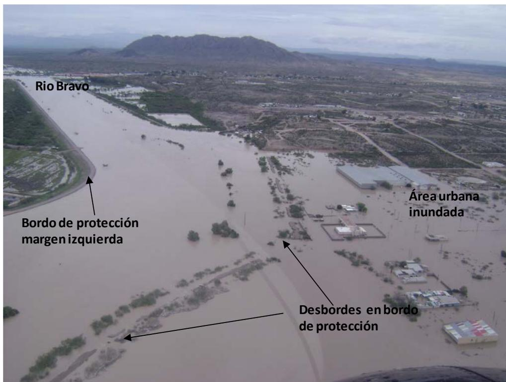
Foto 5.6.1.1.(4) Inundación Aguas abajo del puente internacional
