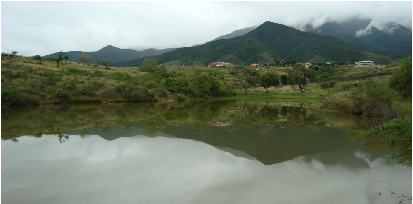
Figura 76. Presa reguladora de picos en la sierra norte de Yatareni.
