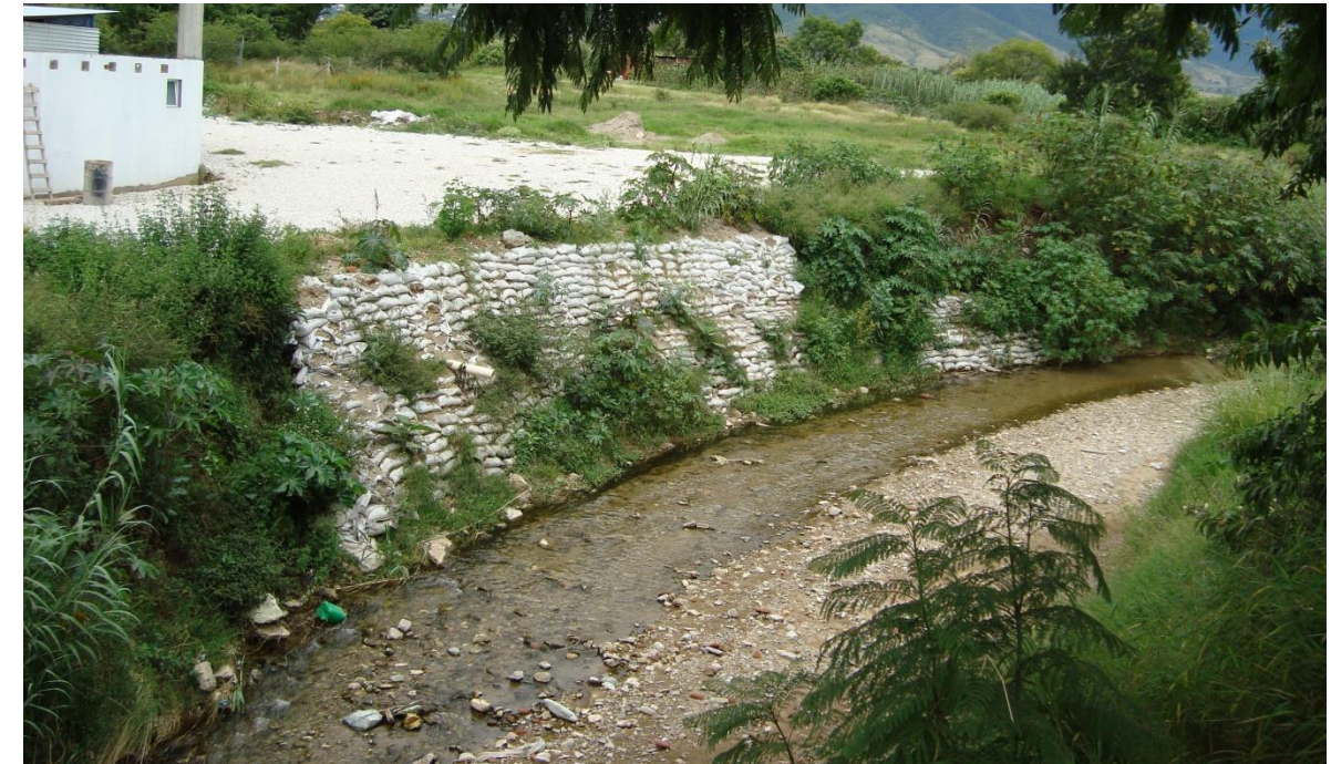
Figura 74. Zona inundable en río Dolores (nótese costalera en Puente de Santa Lucía)
