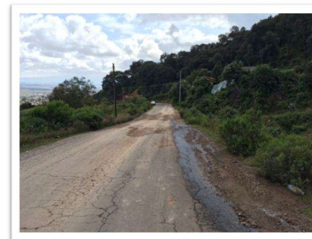
En resumen los fenómenos que abarcan los tipos de deslizamientos, principalmente están dañando la infraestructura carretera dentro del municipio de San Felipe del Progreso, en específico la carretera No. 16, como se muestra en la siguiente figura en la que se detallan diferentes fenómenos.
