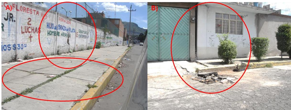
Figura 66. Foto A, Av. Siervo de la Nación en los límites con el distrito Federal se localizan varios sistemas de fallas activas con alto grado de peligro producto de los movimientos que generan grietas en la infraestructura como en las paredes y banquetas según se muestra, UTM X 500736.71, Y 2140877.88. Fotos B Calle helechos se presentan aberturas entre las casas producto del agrietamiento del suelo Coordenadas UTM X 501194.68, Y 2141313.65 1 de octubre de 2014.
