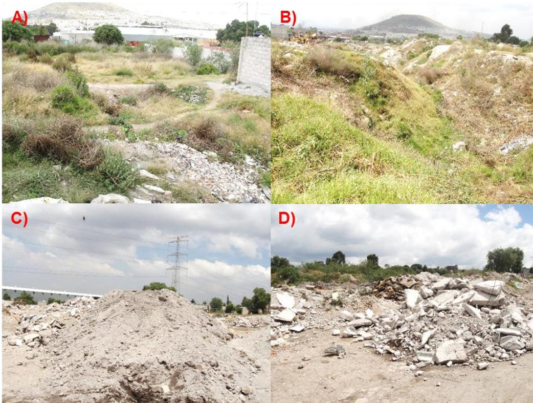
Figura 54. Fotos A a D La Barranca del Muerto al oriente del municipio se encuentran siendo rellenada con material de cascajo y basura esto representa un alto grado de peligro producto de hundimientos de tierras, una vez que se encuentra completamente rellena la población se asienta sobre los escombros, por lo que las construcciones están sin cimientos fijos. Coordenadas Fotos A y B UTM X 506802.92, Y 2143329.87, Coordenadas Fotos C y D UTM X 506962.32, Y 2143328.49 1 de octubre de 2014.
