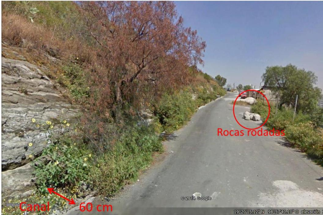
Figura 84. Desazolve del canal de desagüe. Obstruye el corrimiento de agua y genera acarreo de material hacia las viviendas, con esto se evitaría flujos de lodo y caída de rocas.
