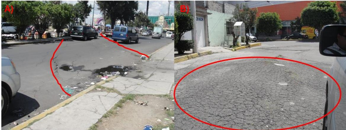
Figura 60. Foto A y B, Av. Siervo de la Nación en los límites con el Distrito Federal zonas falladas, esto representa un alto grado de peligro debido que la subsidencia provoca inestabilidad en el terreno, rompe el asfalto e infraestructura. Coordenadas Fotos A y B UTM X 500870.48, Y 2141374.16, 1 de octubre de 2014.
