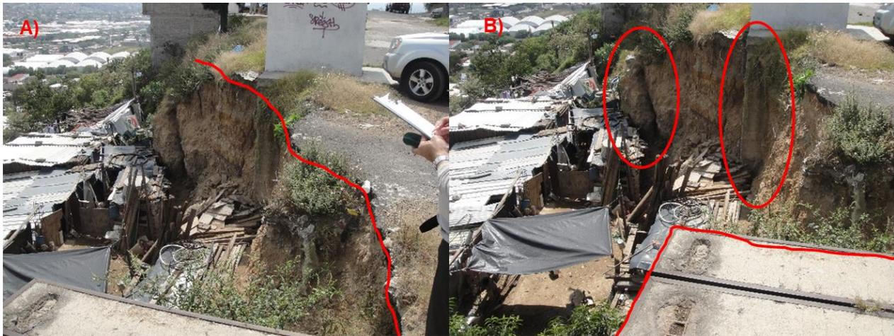
Figura 43. Foto A ladera de la calle camino vecinal existen asentamientos con alto grado de peligro producto de deslizamientos de tierras, la población se asienta a escasos metros de la pared del volcán y está cayendo constantemente material. La foto B se observa que la construcción está sin cimientos fijos y probables bloques de pueden deslizar. Coordenadas UTM X 504027.40, Y 2138587.37, 1 de octubre de 2014.
