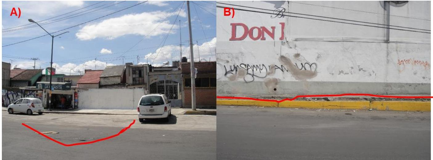
Figura 63. Foto A y B Av. Siervo de la Nación en los límites con el Distrito Federal, áreas de riesgo por inestabilidad en el terreno y provoca daños a las infraestructura, como se observa en las fotos, depresiones y levantamiento de banquetas. Coordenadas Fotos A y B UTM X 500870.48, Y 2141374.16, Coordenadas 1 de octubre de 2014.
