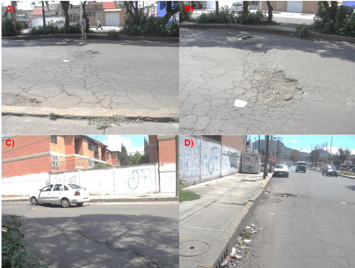
Figura 67. Foto A, Av. Siervo de la Nación en los límites con el distrito Federal se localizan varios sistemas de fallas activas con alto grado de peligro producto de los movimientos por sismos, se aprecia la avenida con fallas que hacen resaltar grietas, Coordenadas UTM X 500813.89, Y 2141164.81. 1 de octubre de 2014.
