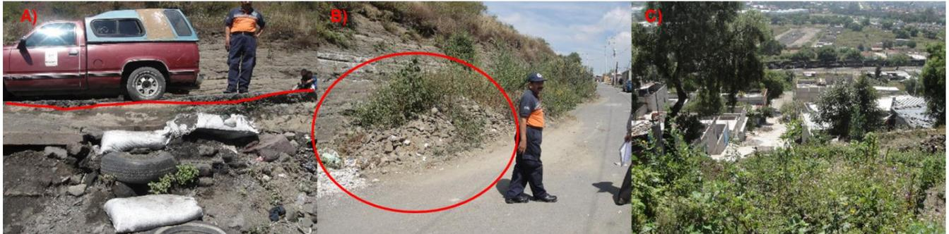
Figura 51. Foto A ladera de la calle Camino vecinal con alto grado de peligro producto de derrumbes, la población pone llantas y costales para que no continúe cayendo material, en la foto B se puede observar material acarreado por la ladera producto de derrumbes aguas abajo y foto C calles sin pavimentar con material suelto que puede ser acarreado y provocar derrumbes y caída de rocas.
