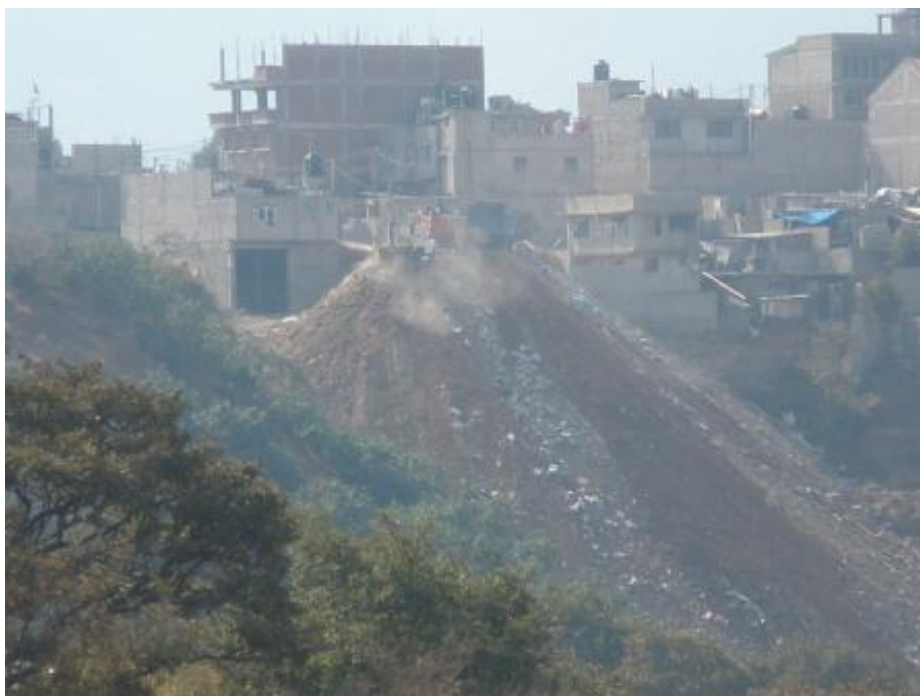
Figura 41. Momento en el que se rellena la barranca al norte de las colonias México 68 y las Huertas Sección 3.
