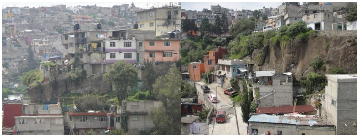
Figura 48. Fotos de Viviendas con alto grado de precariedad que representan alta vulnerabilidad construidos de lámina, cartón y algunos de tabique. El factor más importante es que las casas se encuentran debajo o menos de 5 metros de la pared de desprendimiento que presenta más de 90° de pendiente, ahí construyeron un muro de rocas para calzar un posible desprendimiento de la constante caída de rocas.
