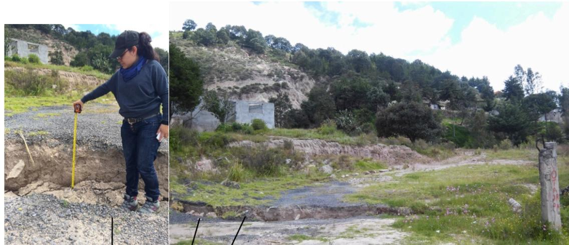
Fotografía 14. Zona 1 de daño por fracturas a infraestructura carretera, Carretera No. 55.
