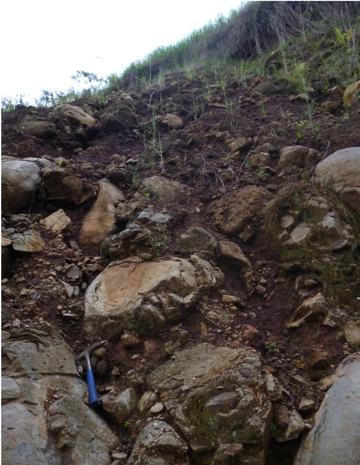
Fotografía 13. Roca de origen volcánico de composición andesítica en una matriz de suelo limoarcilloso, evento ocurrido por un deslizamiento en la localidad de Tecontla.
