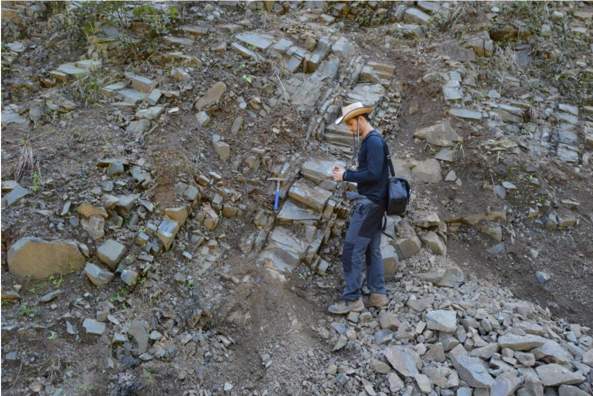
Fotografía 20. Toma de muestra de un deslizamiento de suelo y roca de composición basáltica 55.93 metros de ancho. Camino San Cristóbal - Totonicapa.
