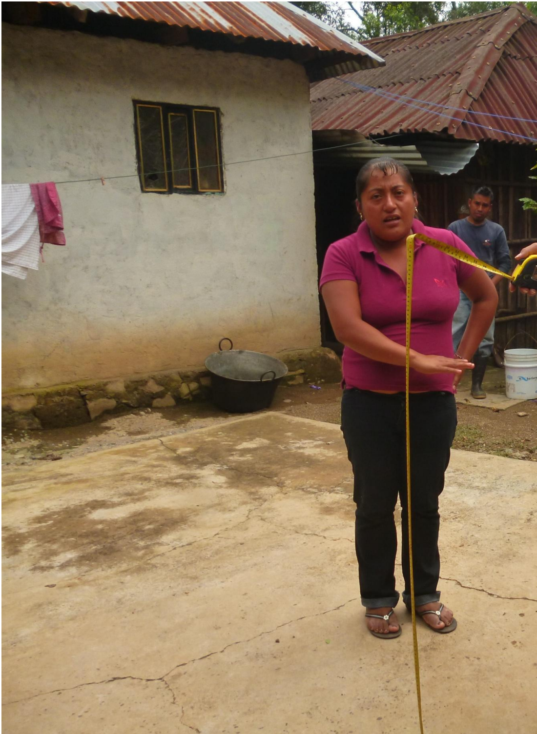
Fotografía 6. Vivienda afectada por la acumulación hídrica en la localidad de Ixtlapala
