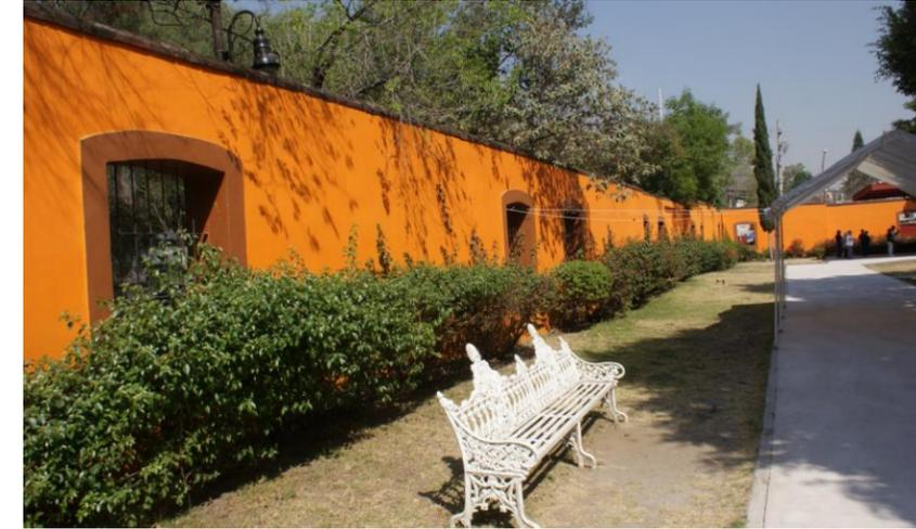
Ilustración 29. Construcción de roca basáltica con muros de 50 cm de espesor. Valor patrimonial en el centro de Coyoacán (Parque de la Tercera Edad).
