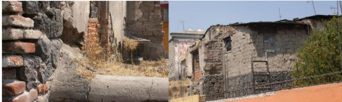
Ilustración 30. Construcción de adobe y roca basáltica. Barrio La Candelaria.
