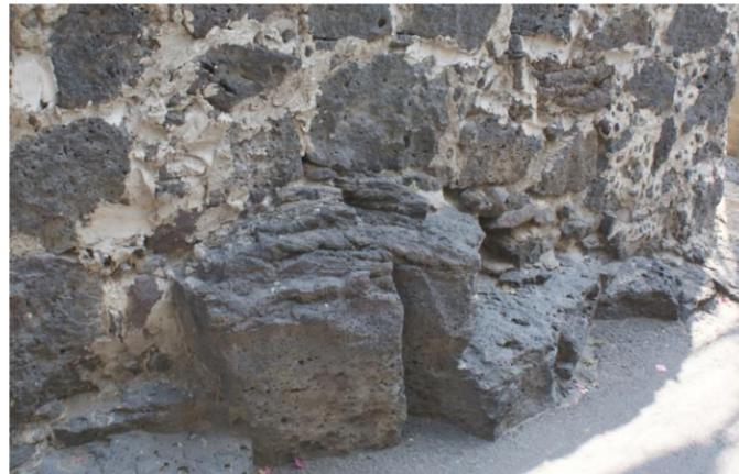
Ilustración 31. Construcción cimentada sobre la roca madre. Barrio La Candelaria.
