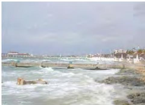
Figura 1.2.4-3 b Destrucción del muelle por la combinación del oleaje y marea de tormenta del huracán en Cozumel.
