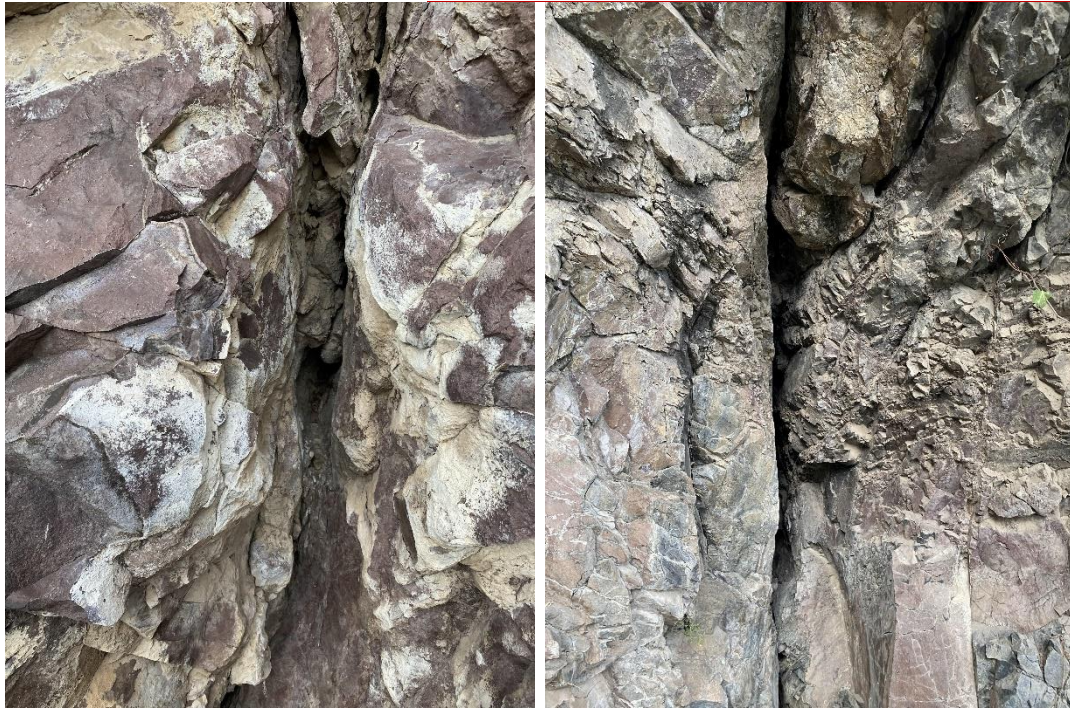
Figura V.4. Fracturas presentes en la roca.
