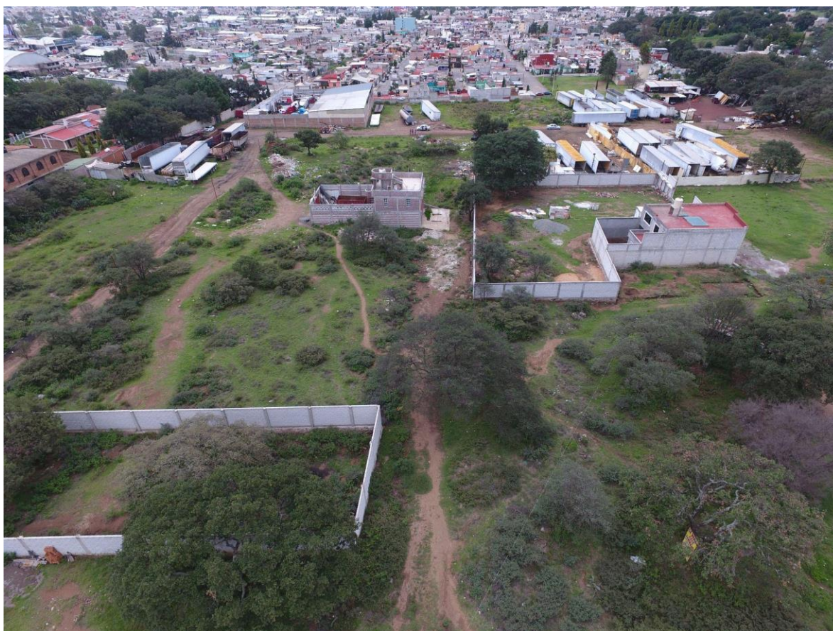
Figura 24. Zona de escorrentías que afectan a la población de la localidad de Unidades Habitacionales.
