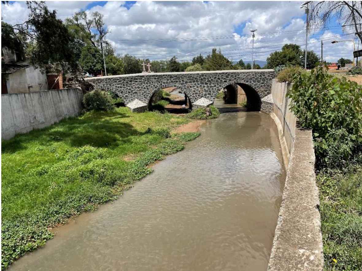
Figura 25. Puente de Ahíla en la cabecera municipal. En este punto desembocan la mayoría de las escorrentías en temporada de lluvias.
