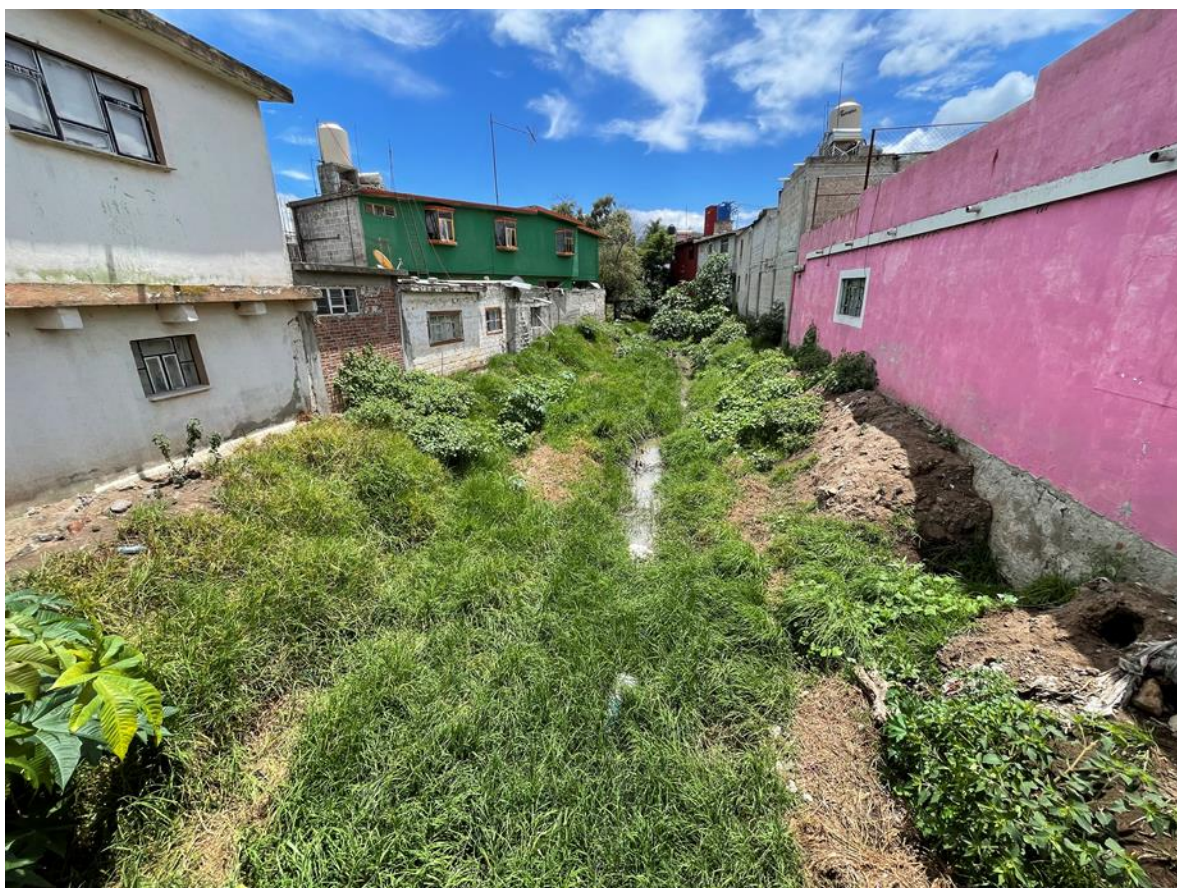
Figura 26. Zona con riesgo de inundación dentro de la cabecera municipal a la altura de la Calle Corregidora.
