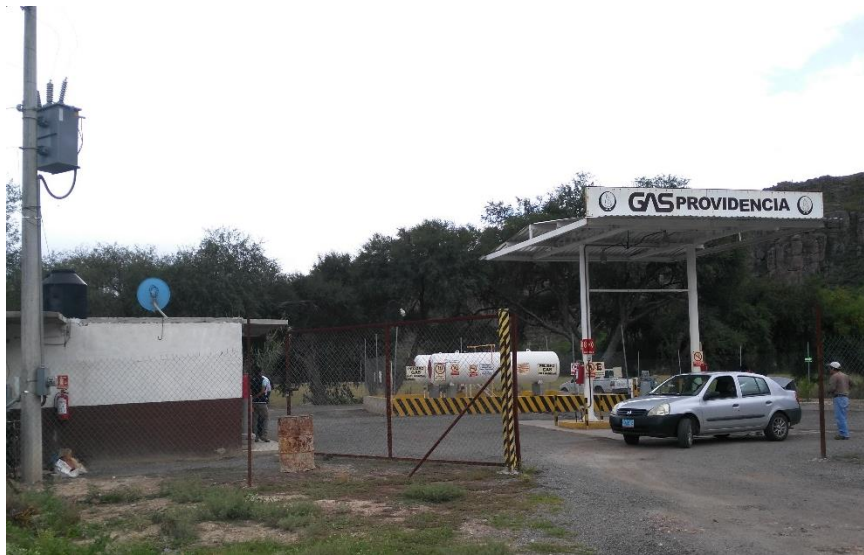
Figura 81. Estación de Gas L.P. para carburación ubicada en el municipio de Victoria (Coordinación Municipal de Protección Civil, n.d.)
