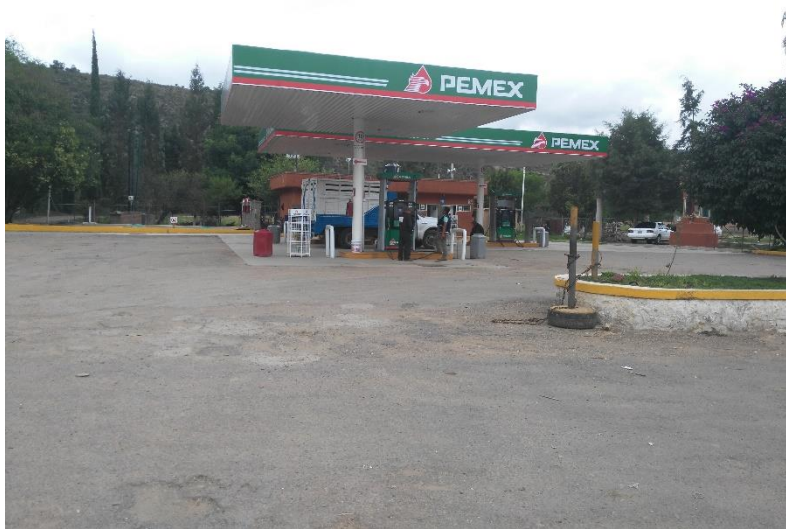
Figura 79. Estación de Servicio para almacenamiento y expendio de diésel y gasolinas ubicada en el municipio de Victoria, Gto. Fuente: (Coordinación Municipal de Protección Civil, n.d.).
