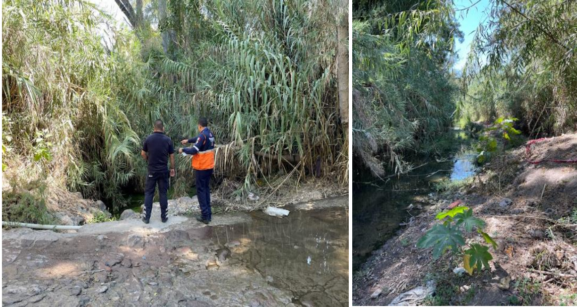
Figura 66. . Recorrido de inspección a Zonas de Peligro y Riesgo por Inundación en Río Victoria, Calle Calvario, Victoria, Gto. Fuente: (CEPC, 2022)
