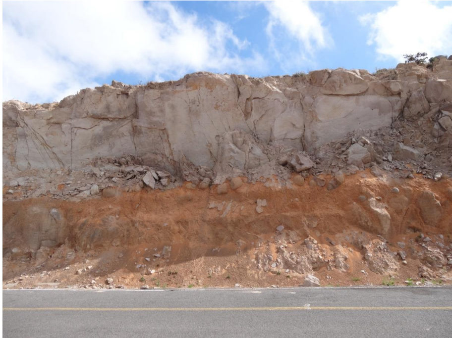
Figura 53. Talud en la carretera Cañada de Moreno-Xichú km 28+100 Tramo Puerto del Aire. Fuente: (GTIRALTIEG, 2015).
