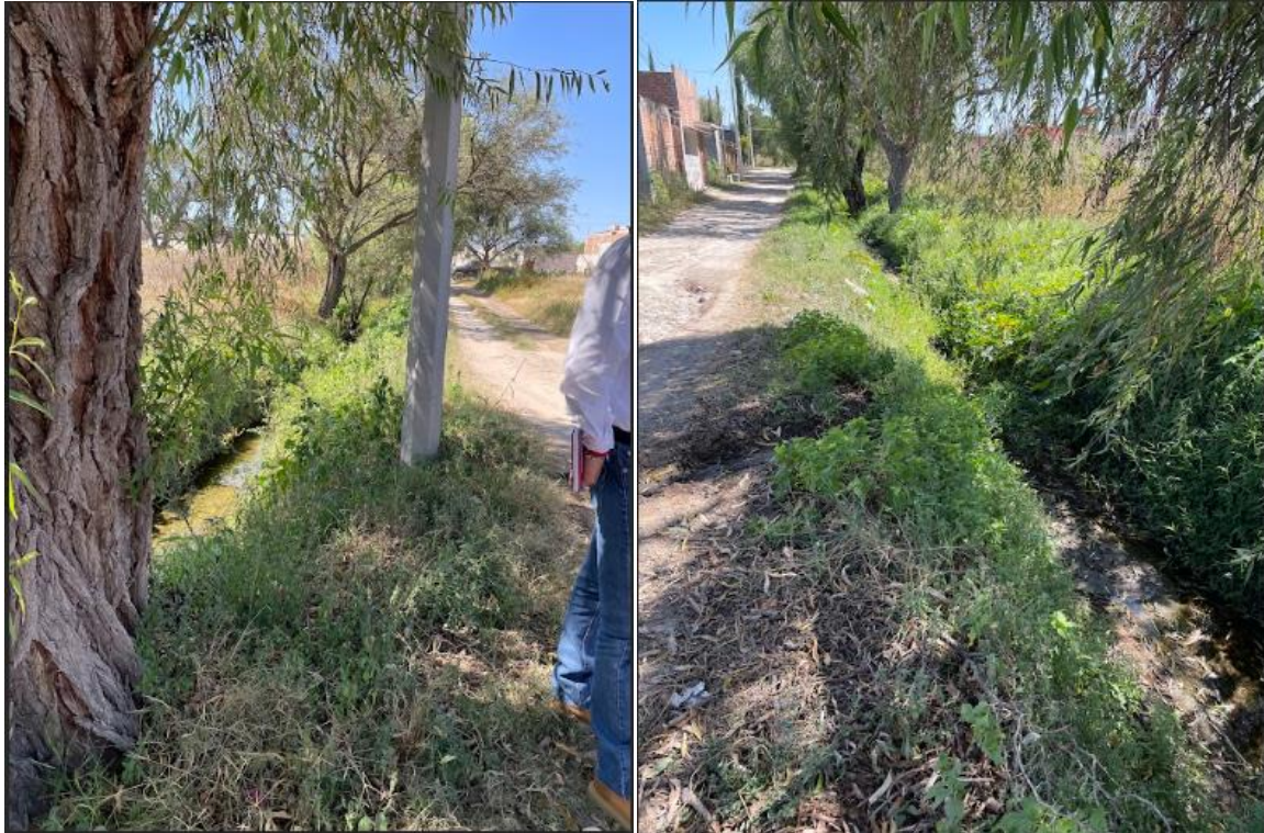
Figura 60. Recorrido de inspección a Zonas de Peligro y Riesgo por Inundación Canal en operación, Colonia Guanajuatito, Tarandacuaao, Gto. Fuente: (CEPC, 2022)
