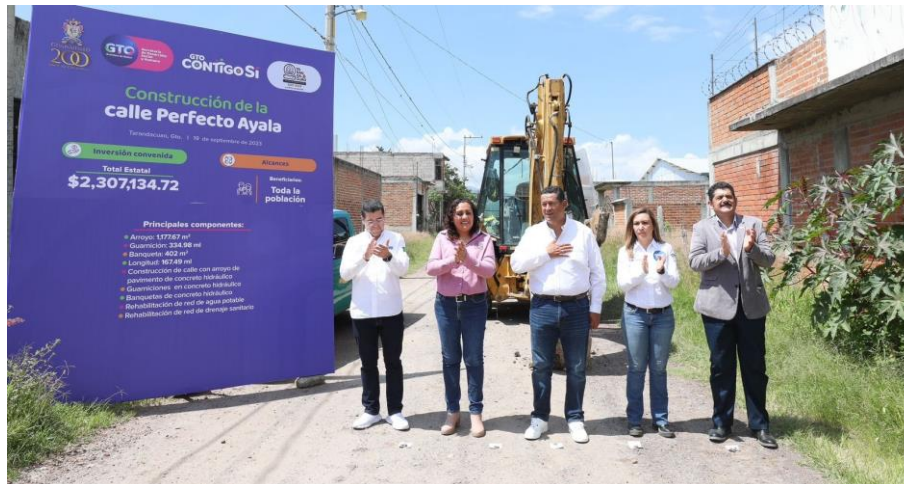
Figura 41. Arranque de obra vial en comunidades marginadas en el municipio de Tarandacua. Fuente: Gobierno del Estado
