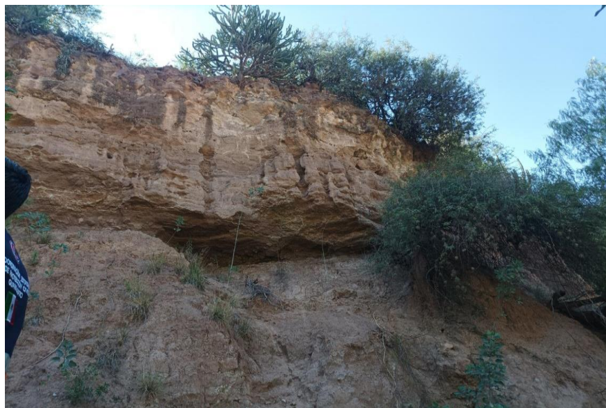
Figura 63. Recorrido de inspección a Zonas de Peligro y Riesgo por Inundación en el Río Tierra Blanca, Comunidad Ortega, Santa Catarina, Gto. Fuente: (CEPC, GTO)
