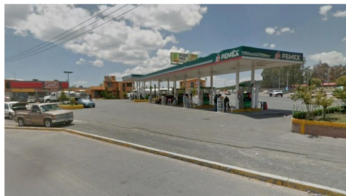
Figura 82. Estación de Servicio para almacenamiento y expendio de diésel y gasolinas ubicada en el municipio de San Luis de la Paz (Coordinación Municipal de Protección Civil, n.d.).
