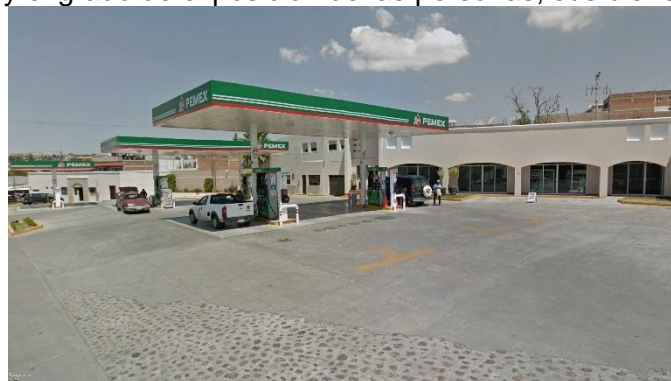
Figura 82. Estación de Servicio para almacenamiento y expendio de diésel y gasolinas ubicada en el municipio de Coroneo (Coordinación Municipal de Protección Civil, n.d.).
