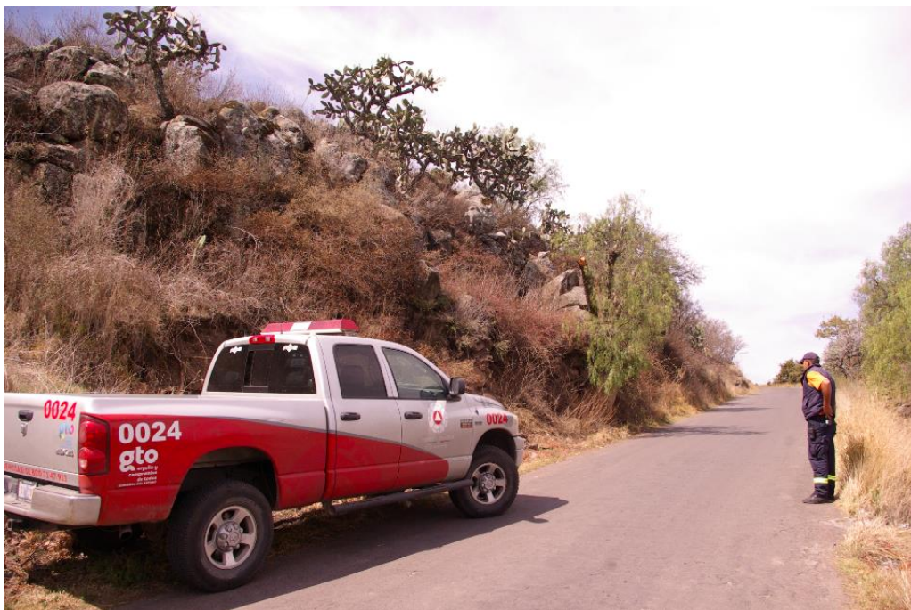
Figura 51. Ladera inestable en la Localidad Ojo de Agua, Coroneo. Fuente: (CEPC 2015).
