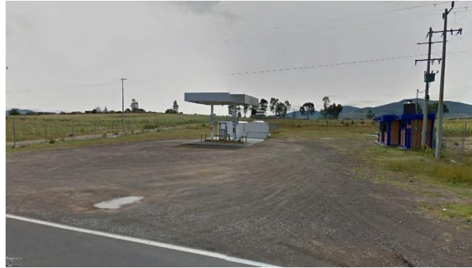
Figura 84. Estación de Gas L.P. para carburación ubicada en el municipio de Coroneo (Coordinación Municipal de Protección Civil, n.d.).
