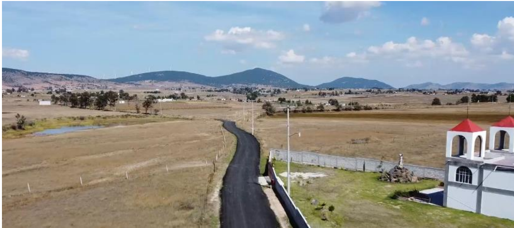
Figura 43. Rehabilitación de infraestructura vial en localidades marginadas del municipio de Coroneo. Fuente: Gobierno Municipal
